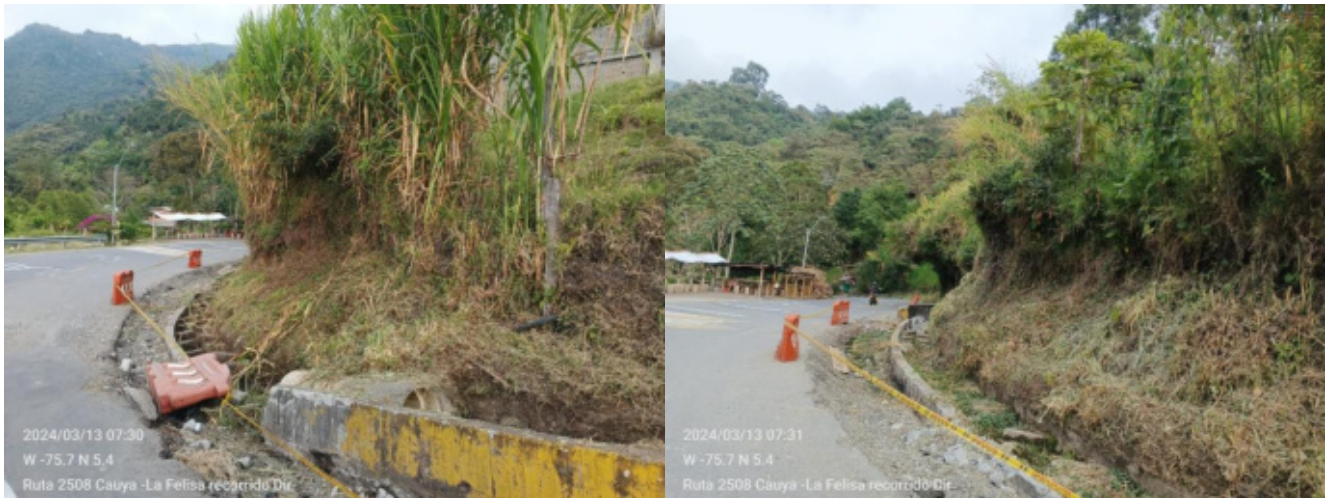
Fotografía 4 Señalización inestable y deficiente
