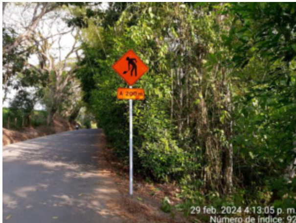
Imagen 1: Instalación señalización vertical
