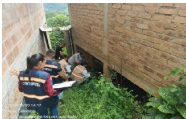
RF 22. Visita disipador PR 59+455 Ruta 5003
