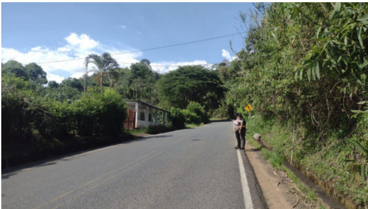
Fotografía 10: Recorrido ruta 2507 Remolinos - Cauya
