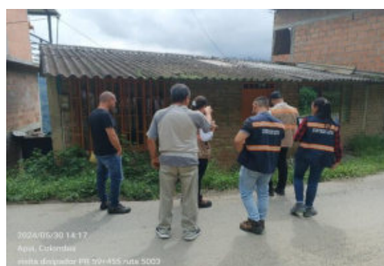
RF 23. Visita disipador PR 59+455 Ruta 5003
