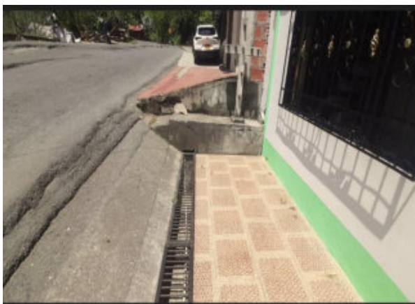
RF 9. P.Q.R.D.S Las Pilas Ruta 2508 Antes de obra
