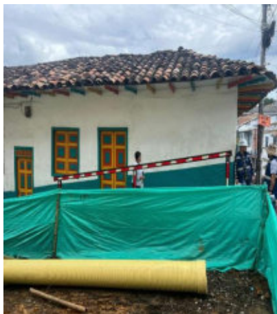
RF 4. Vivienda afectada Apia Calle 11 Cra 8 esquina
