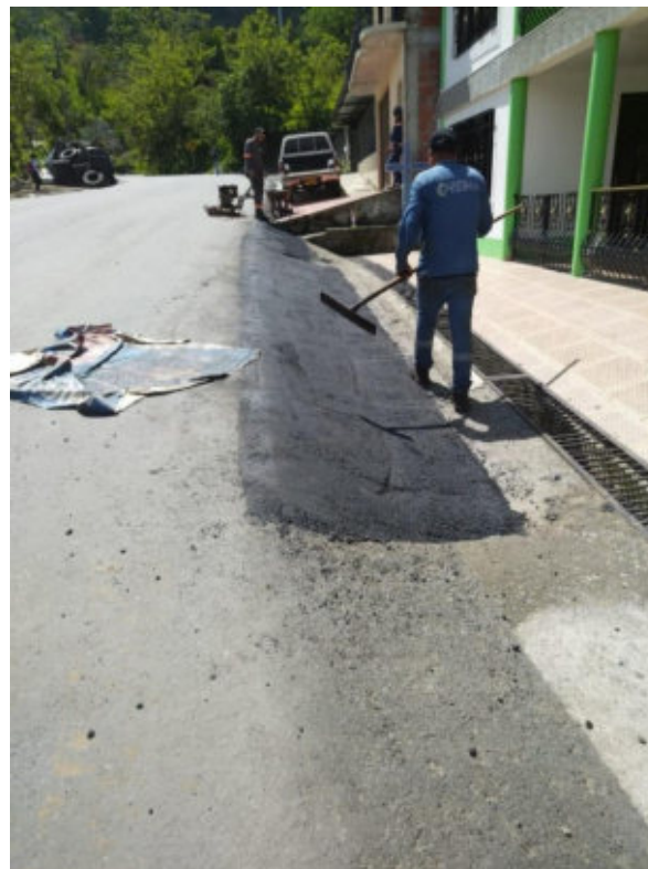
Fotografía 4: Intervención en ingreso del predio de la señora Jimena Suarez. PR 40+200 RUTA 2508
