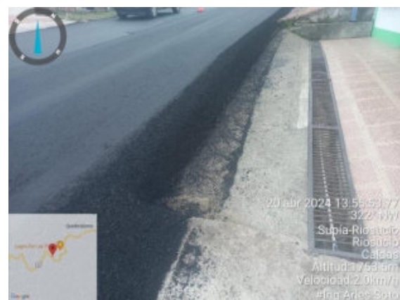
RF 10. P.Q.R.D.S Las Pilas Ruta 2508 Después de obra
