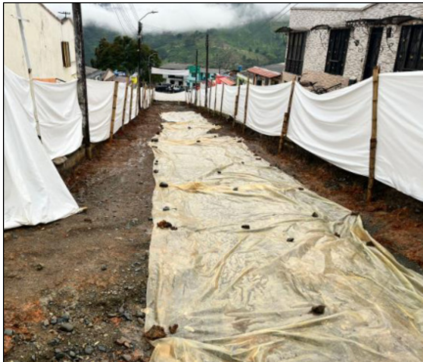
Figura 15. Instalación de cerramiento en yute.
