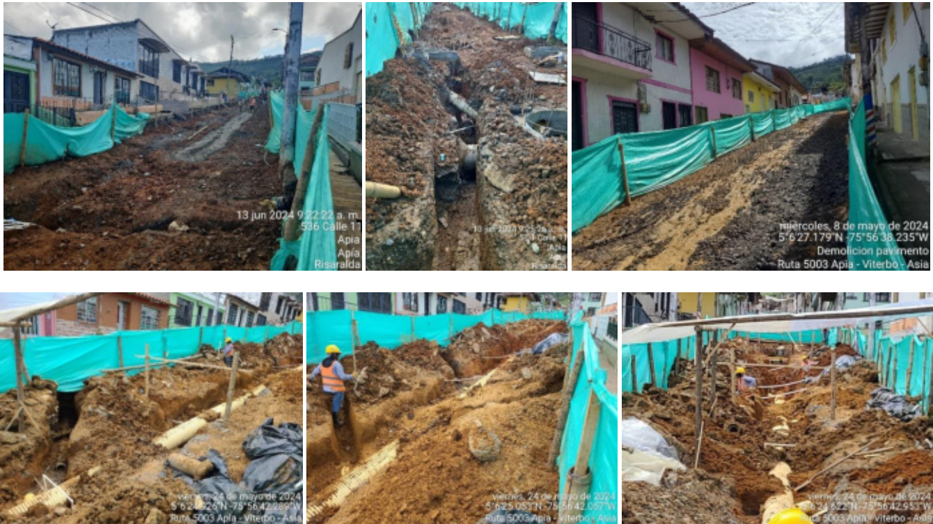
Fotografía 2 ejecución etapa 2 instalación de redes de acueducto y alcantarillado en el municipio de APIA
