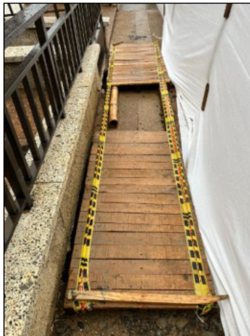
Figura 19. Señalización de tableros en andenes con cinta.
