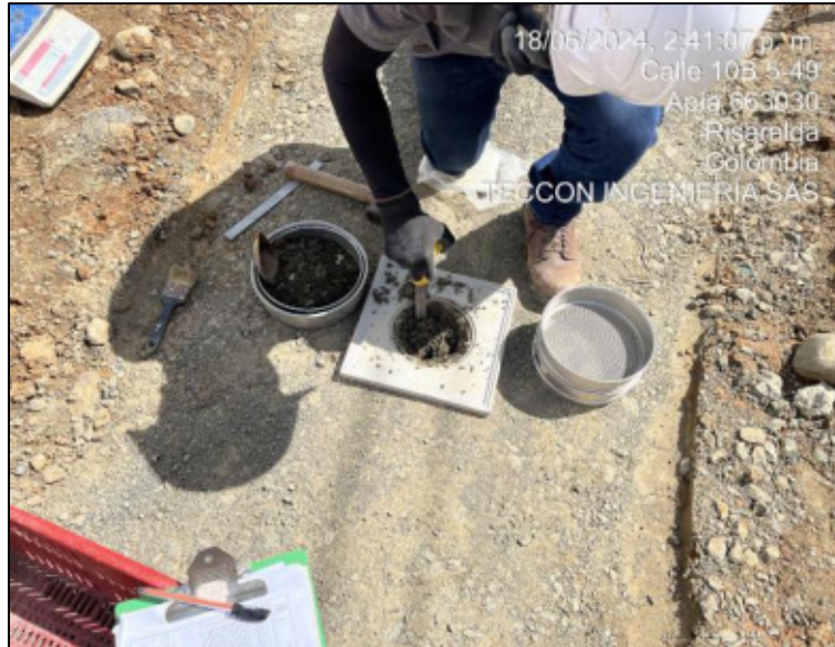
Figura 5. Ensayo de densidad en subbase granular.
