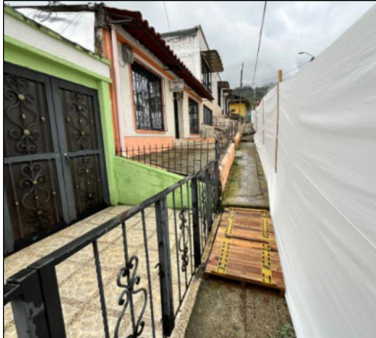
Figura 18. Mejoramiento de tableros para paso peatonal lado izquierdo.
