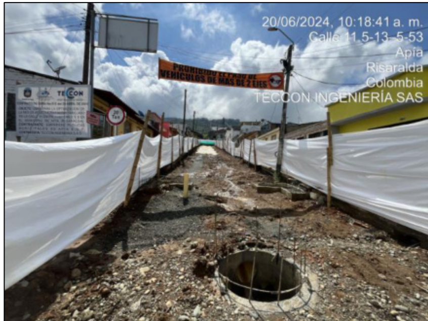
Figura 10. Vista general del Tramo No. 01 desde Carrera 5.
