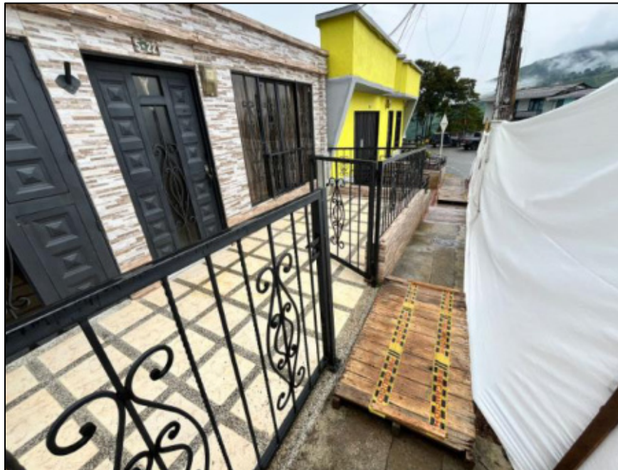
Figura 17. Mejoramiento de tableros para paso peatonal lado izquierdo.
