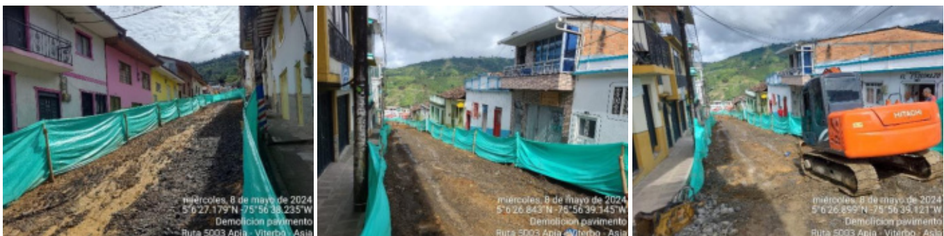
Fotografía 1 ejecución etapa 1 pavimentación rígido urbano en el municipio de APIA
