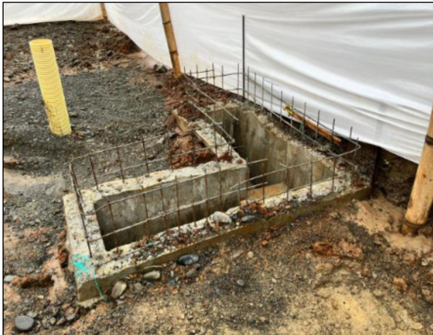
Figura 13. Sumidero doble rejilla lado derecho en el sentido del flujo.
