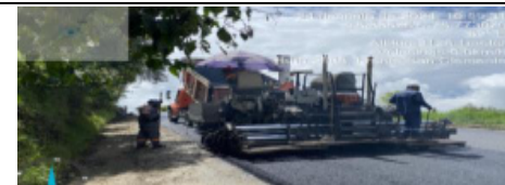
RUTA 2508 CAUYÁ - LA FELISA SECTOR SAN CLEMENTE PR17+800 INSTALACIÓN CAPA AFÁLTICA
