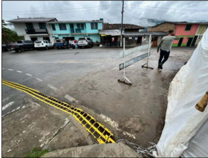
Figura 16. Limpieza de la vía principal – crucero.
