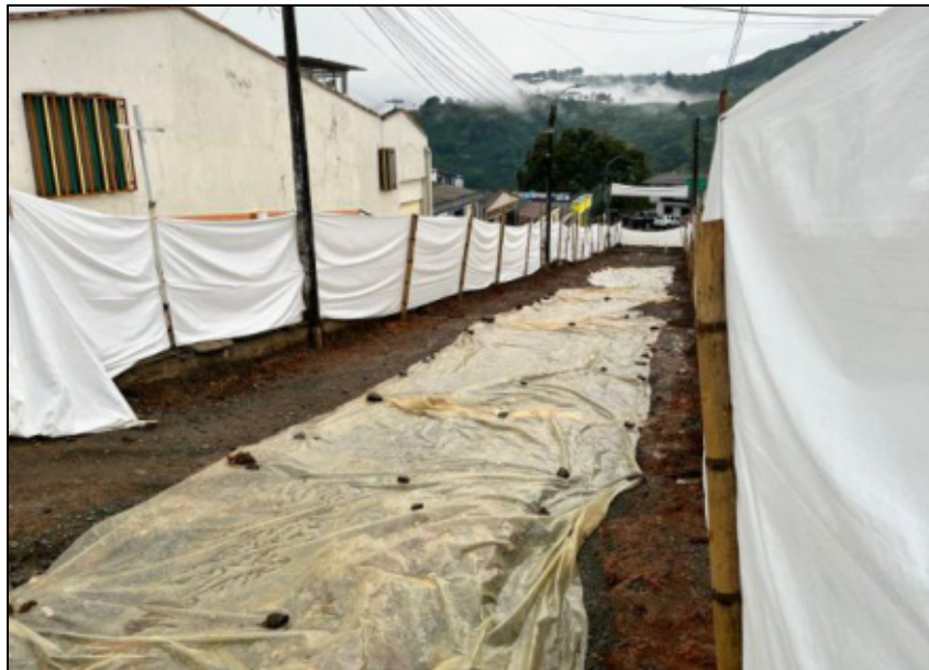
Figura 11. Vista general del Tramo No. 01 desde carrera 6.
