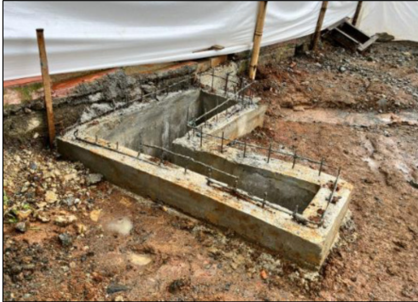
Figura 12. Sumidero doble rejilla lado izquierdo en el sentido del flujo
