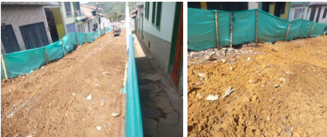
Fotografía 1 estado obras calle 11 calle 5 a 8 - 11 junio 2024
