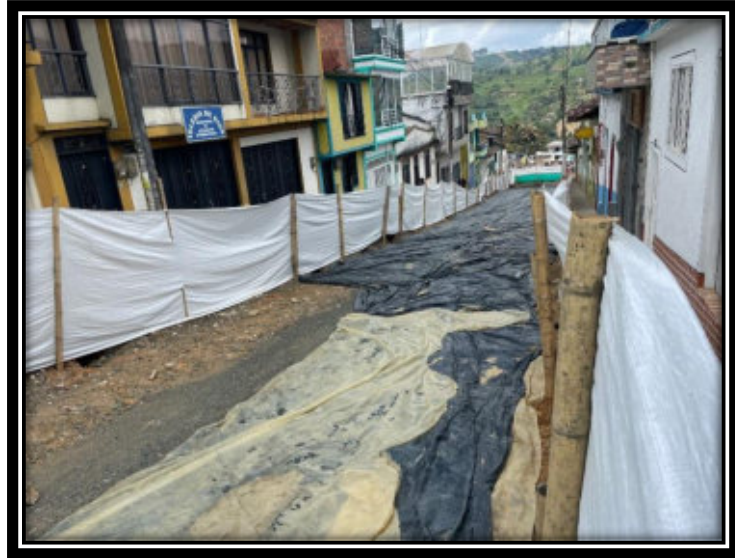
Imagen 2 y 3: Como se puede evidenciar la tramos N° 02 y 03 calle 11 entre carreras 6 y 8 tiene corrido el plástico, y la lluvia empieza a socavar las brechas de acueducto y alcantarillado que se compactaron y entregaron.
