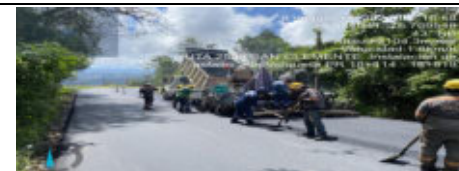
RUTA 2508 CAUYÁ - LA FELISA SECTOR SAN CLEMENTE PR18+300 INSTALACIÓN CAPA AFÁLTICA
