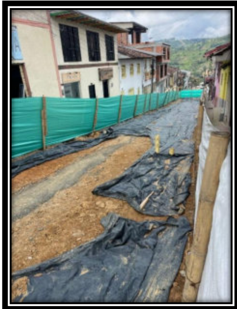
Imagen 2 y 3: Como se puede evidenciar la tramos N° 02 y 03 calle 11 entre carreras 6 y 8 tiene corrido el plástico, y la lluvia empieza a socavar las brechas de acueducto y alcantarillado que se compactaron y entregaron.
