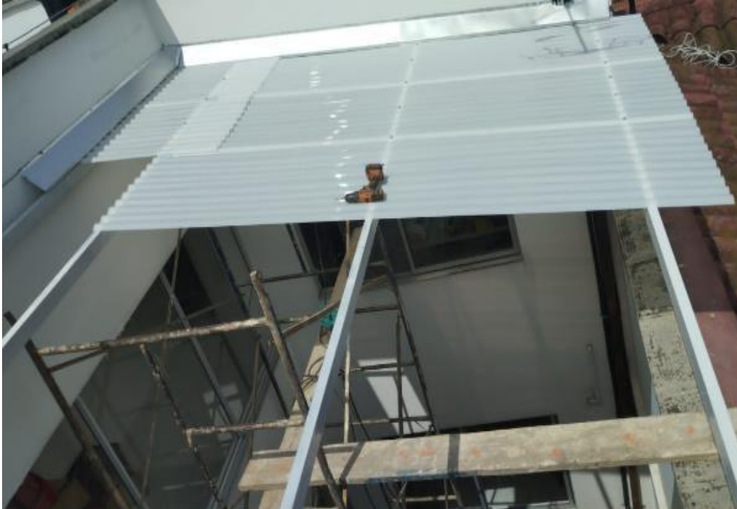
Foto: Sustitución cubierta y del sistema de flanches perimetrales; Sede-ORIP La Mesa. Fuente: Archivo CONSORCIO INTERAGRUPACIONES Dic-2023.
