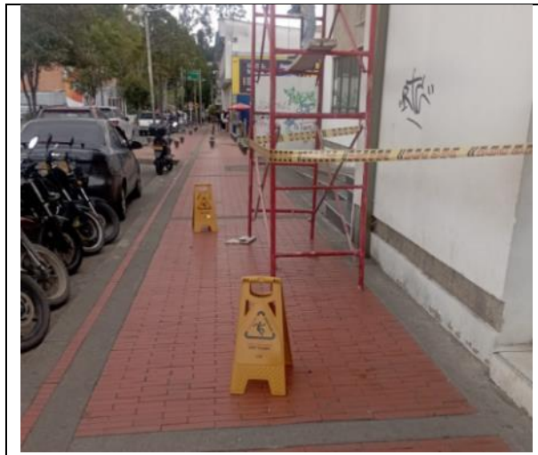
Foto: Intervención de fachadas Sede Guaduas, dic-2023.
