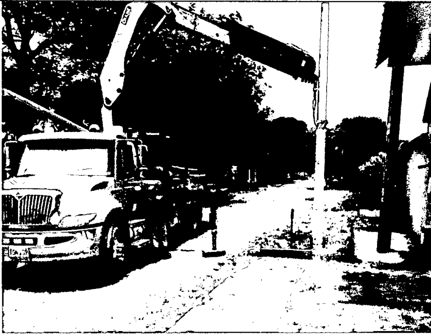
FOTO 7: HINCADO DE POSTES EN FERRECONCRETO SECTOR VEREDA EL TRIUNFO.
