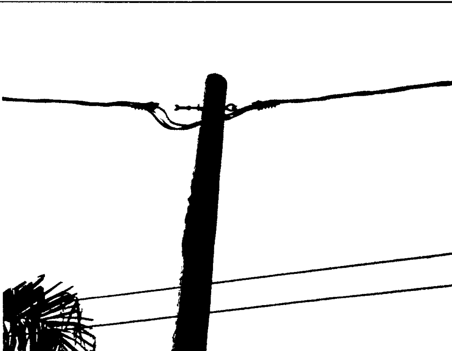
FOTO 10: INSTALACIÓN DE ESTRUCTURA DE RETENCIÓN DOBLE EN B.T LA-327
