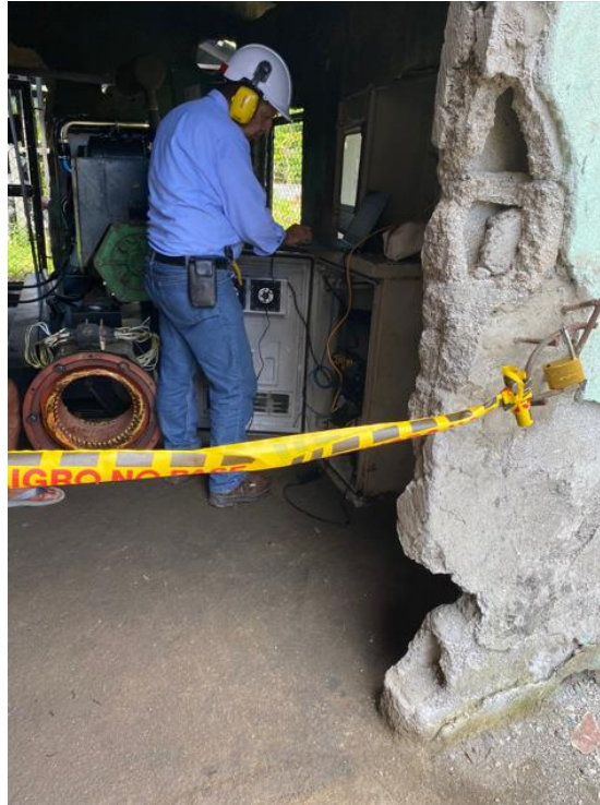
Imagen No 9 señalización y uso de EPP
