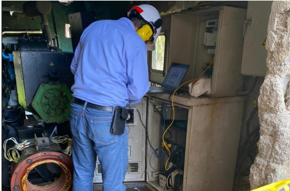
Imagen No 3 Rack de Comunicaciones, medidor y transferencia
