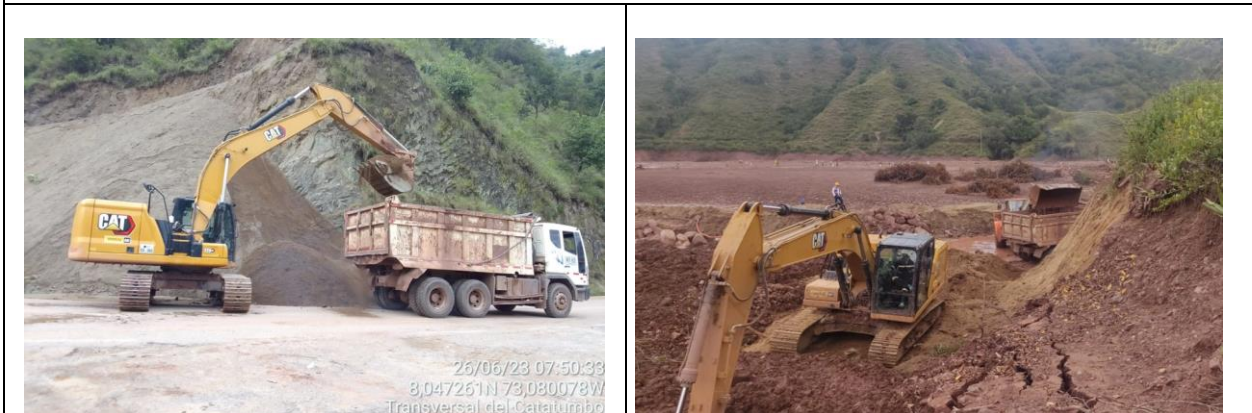
Cargue de arena para jarillón y adecuación de la vía de acceso al área de disposición provisional.
