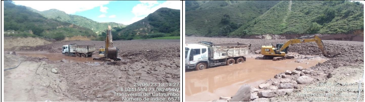
Retiro de material de lodos en el frente del PR52+0089.
