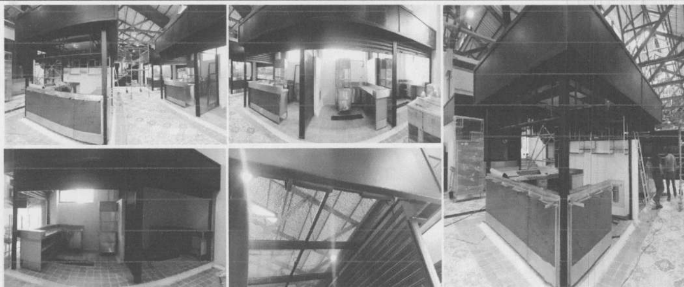
ARMADO E INSTALACION DE MOBILIARIO PARA MODULOS DE NAVE CENTRAL
