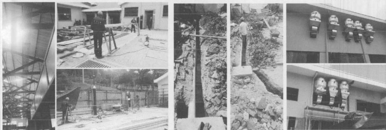
INSTALACION RED DE GAS - EXCAVACION PARA RED DE GAS - INSTALACION DE HONGOS DE EXTRACCION
