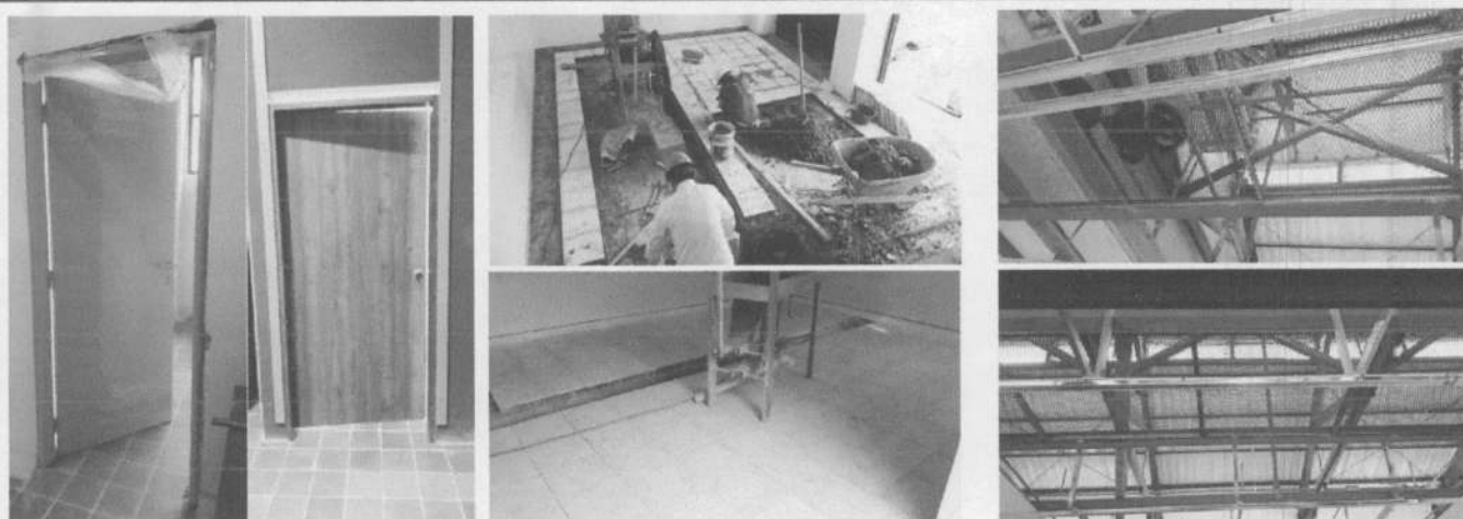
INSTALACION DE PUERTAS METALICAS Y MADERA - INSTALACION DE PISO VIBROPRENSADO EN SHUT DE BASURAS - INSTALACION DE MALLA DE VENTILACION PARA COCINAS
