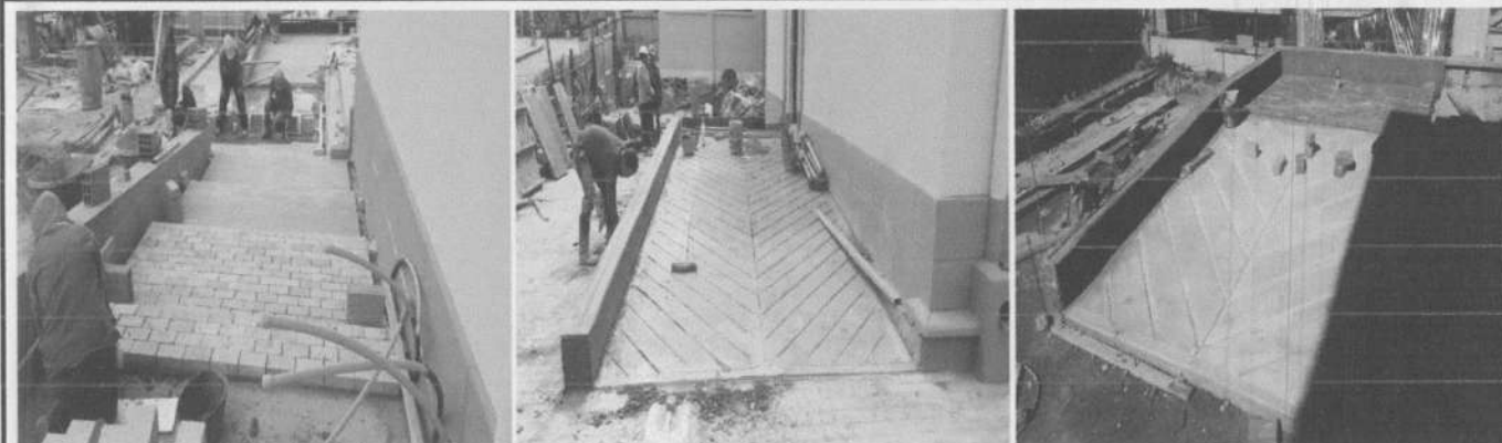
CONSTRUCCION DE RAMPAS Y ESCALERAS DE ACCESO A NAVE CENTRAL
