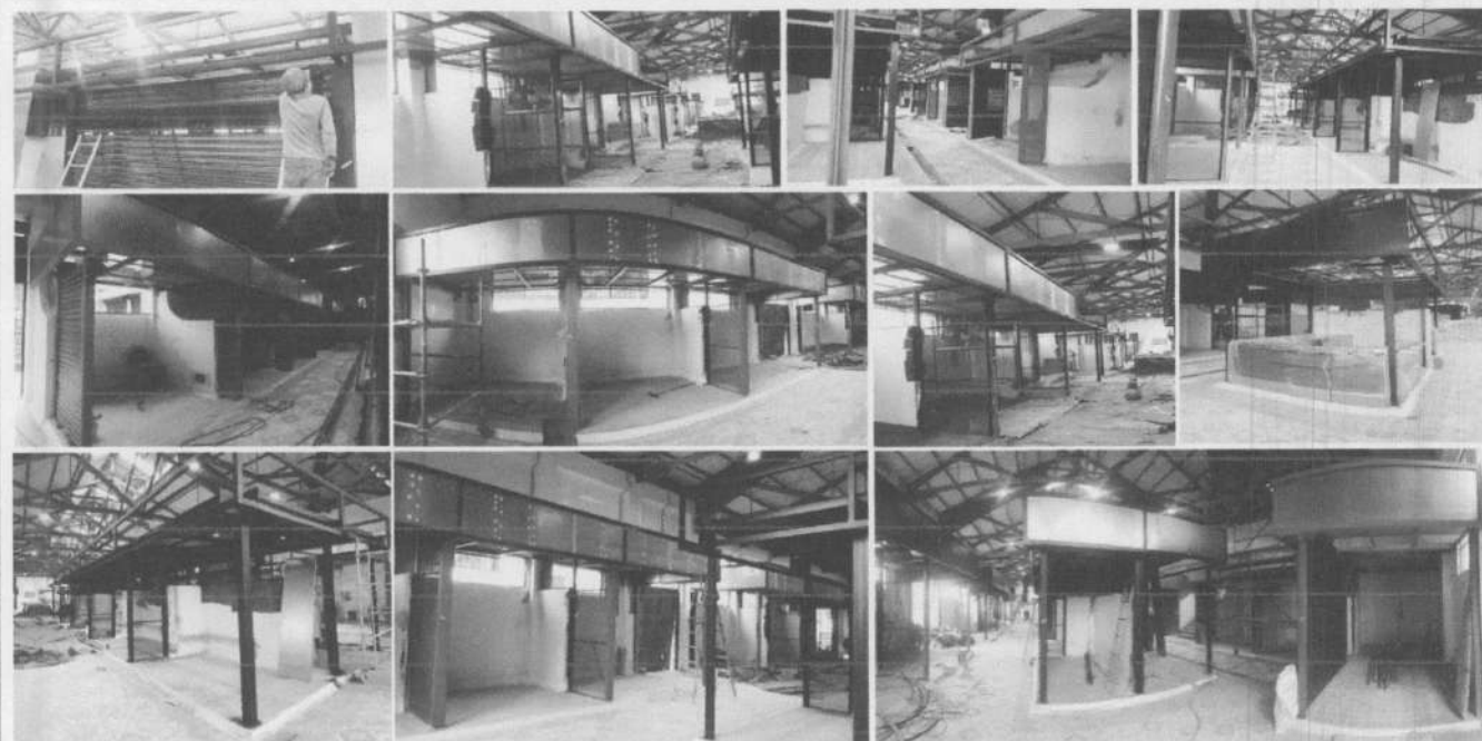
ARMADO DE PUERTAS ENROLLABLES Y LAMINA DE CALLROLLED PARA AVISOS-PINTURA ANTICORROSIVA Y EPOXICA NEGRA
