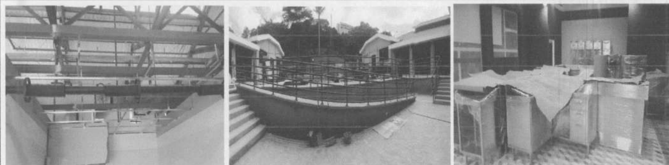
ARMADO DE ESTRUCTURA PARA CIELO RASO EN COCINAS - INSTALACION DE BARANDA EN PLAZOLETA ORIENTAL - RECIBO DE MOBILIARIO PARA MODULOS
