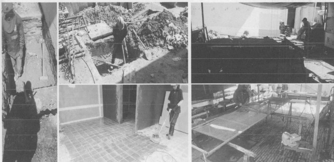
EXCAVACION CAJAS DE INSPECCION - EXCAVACION CAJAS DE INSPECCION Y LIMPIEZA DE PISO EN SALON MULTIPLE - ARMADO DE DIVISIONES EN MALLA EXPANDIDA PARA MODULOS
