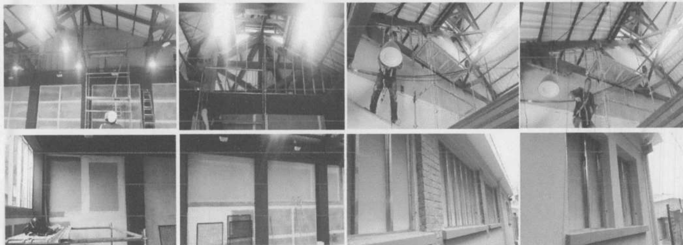
INSTALACION DE SUPERBOARD EN SALON MULTIPLE
