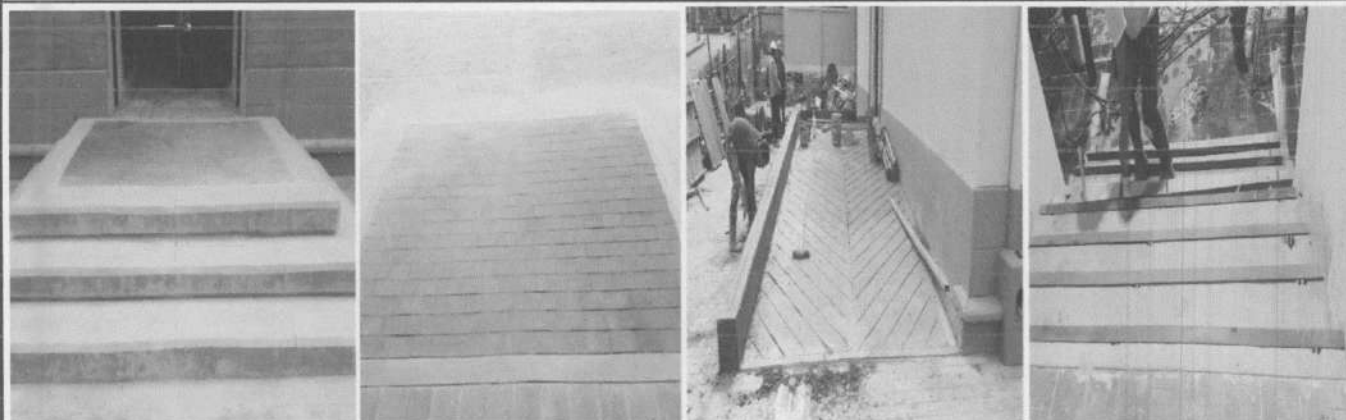
ARMADO Y CONSTRUCCION DE RAMPAS Y ESCALERAS
