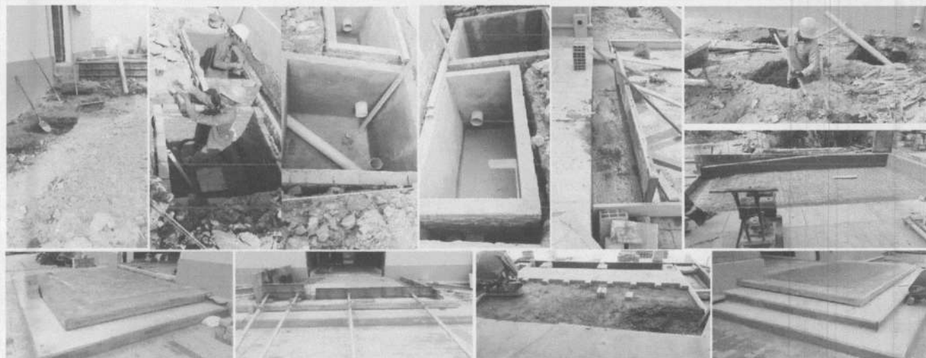
EXCAVACION Y ARMADO DE CAJAS DE INSPECCION Y AFORO - ARMADO Y CONSTRUCCION DE CONFINAMIENTO DE RAMPAS Y ESCALERAS
