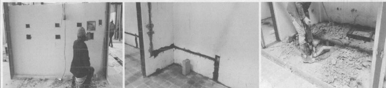
CORRECCION DE PUNTOS ELECTRICOS SEGUN NORMA Y ADECUACION DE PUNTOS SANITARIOS EN MODULO DE LAVADO COMUN
