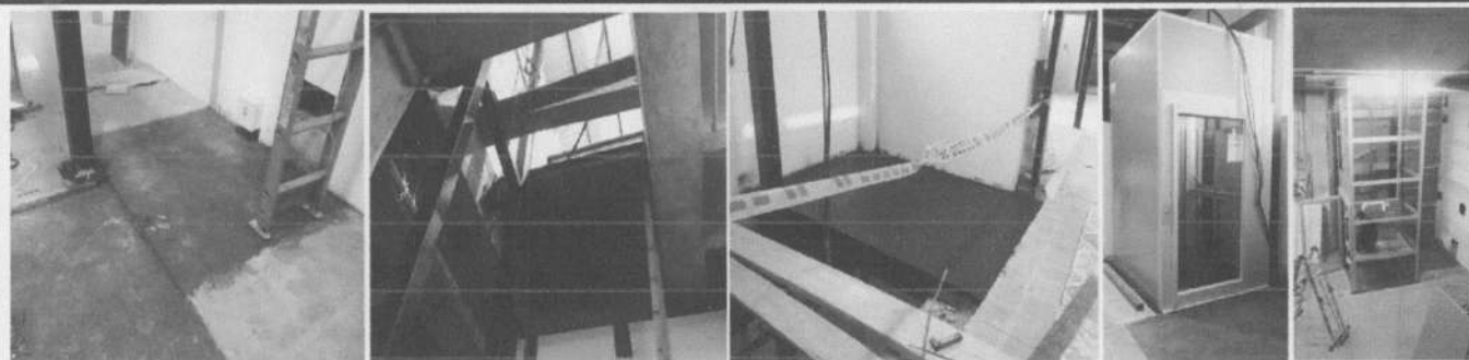
INSTALACION DE PLATAFORMA PARA ASCENSOR
