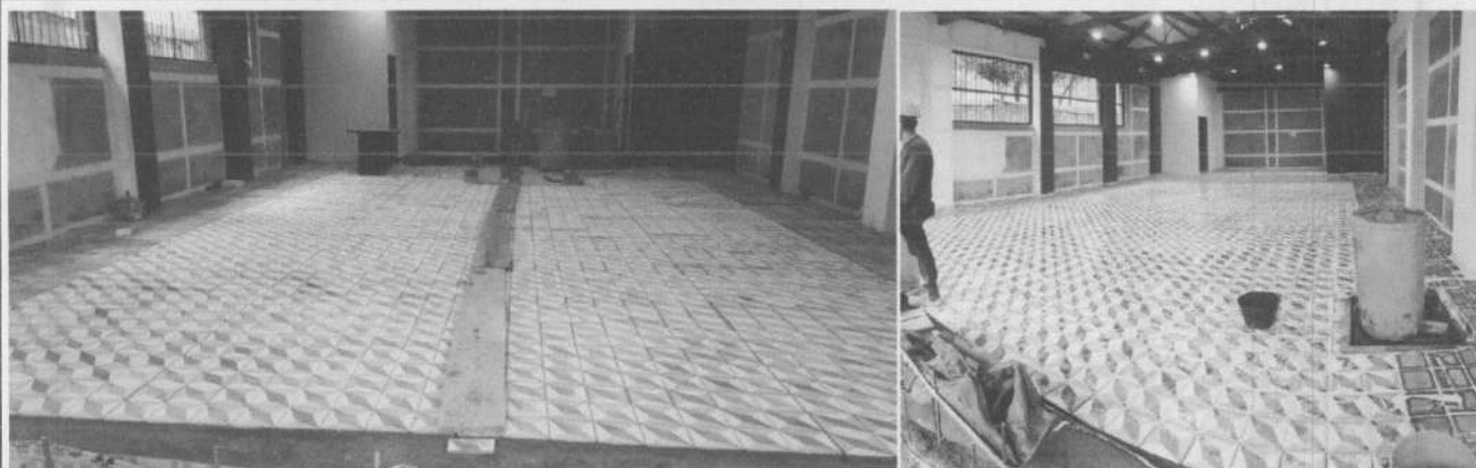
INSTALACION DE PISO Y EMBOQUILLADO EN SALON MULTIPLE
