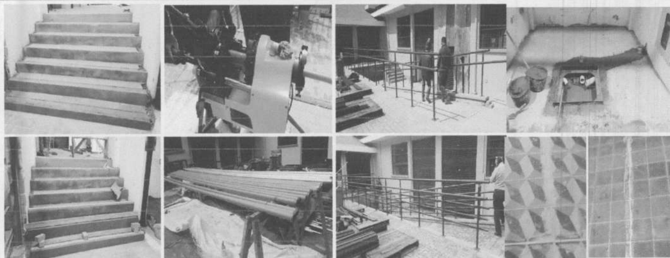
ACABADO ESCALES NAVE CENTRAL - TUBERIA PARA RED DE GAS - ARMADO BARANDA PARA RAMPAS -COLECTOR LAVADO COMUN Y JUNTAS DE PISO
