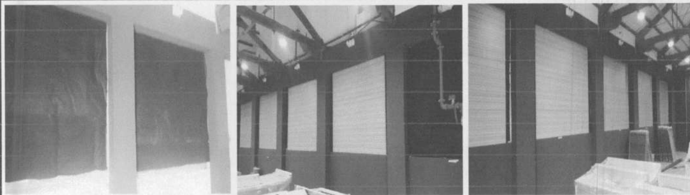
INSTALACION DE AISLANTE ACUSTICO Y REVESTIMIENTO DE MUROS EN SALON MULTIPLE
