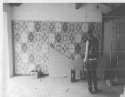
INSTALACION DE ENCHAFE DE MURO EN ZONA DE COCINAS Y EMBOQUILLADO - INSTALACION DE PISO EN TAPAS DE CAJAS DE INSPECCION
