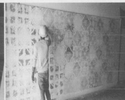
INSTALACION DE ENCHAFE DE MURO EN ZONA DE COCINAS Y EMBOQUILLADO - INSTALACION DE PISO EN TAPAS DE CAJAS DE INSPECCION
