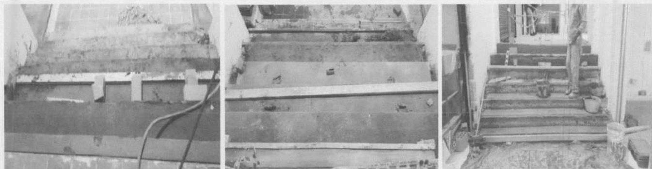
REMATE DE ACBADO EN ZONA DE ESCALES EN CONCRETO
