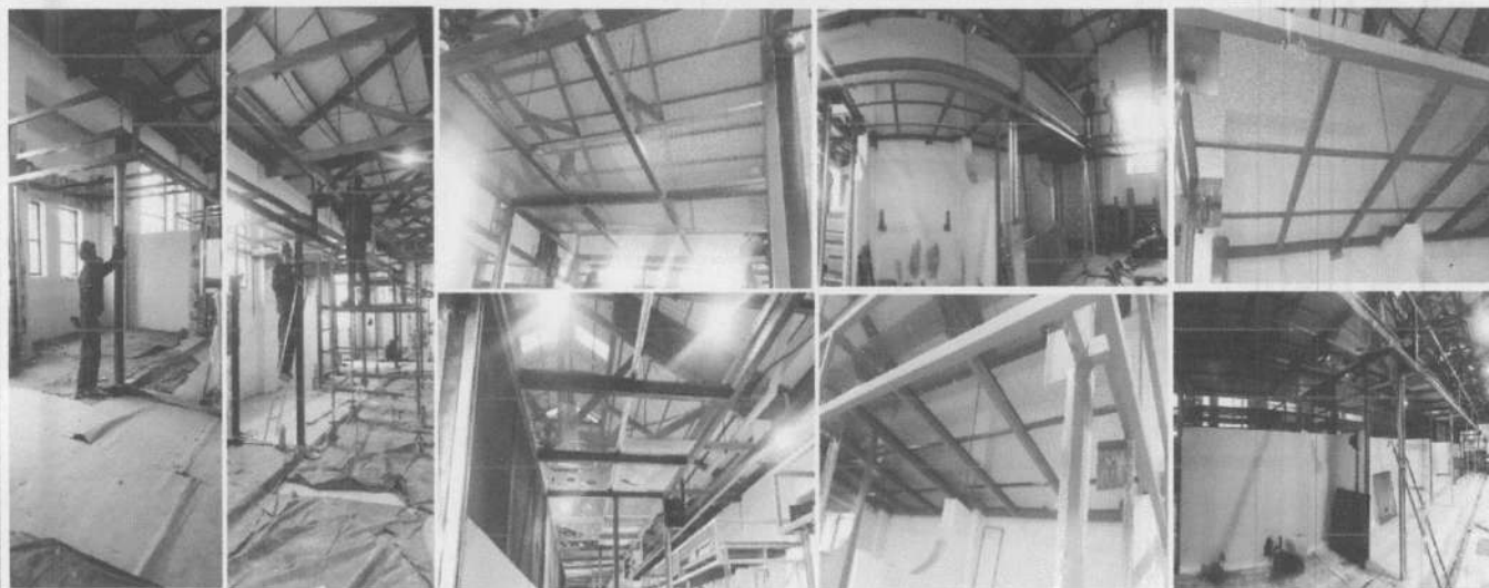
LIMPIEZA DE ESTRUCTURA PARA INSTALACION DE ANTICORROSIVO - ARMADO DE DIVISIONES HORIZONTALES Y VERTICALES DE MALLA EXPANDIDA
