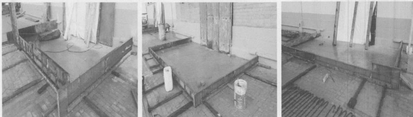
ARMADO DE FORMALETA PARA PLATAFORMAS DE ACCESO A NAVE CENTRAL COSTADO OCCIDENTAL
