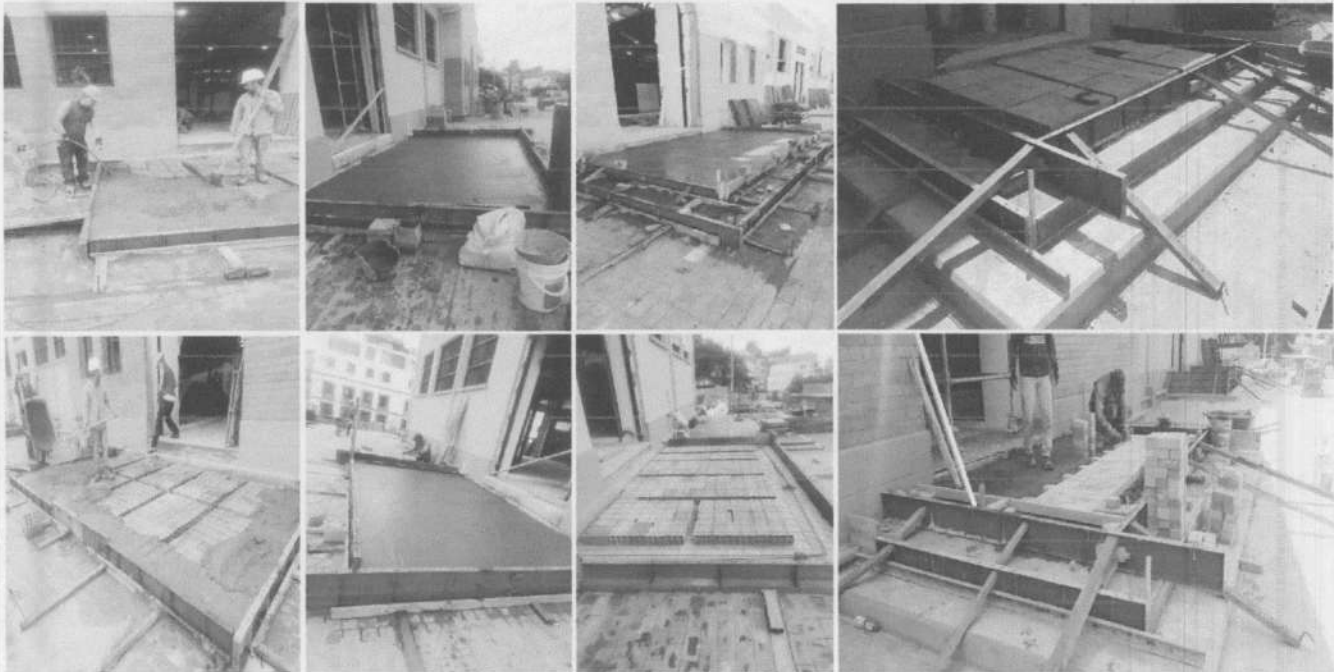
ARMADO Y CONSTRUCCION DE PLATAFORMAS DE ACCESO A NAVE CENTRAL
