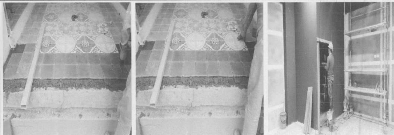
REMATE DE ACCESOS EN NAVE CENTRAL Y REMATE DE VANOS EN PUERTAS DE SALON MULTIPLE
