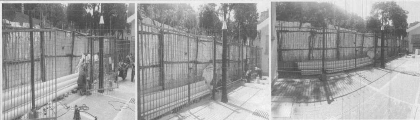
ARMADO Y MONTAJE DE REJA ORNAMENTADA
