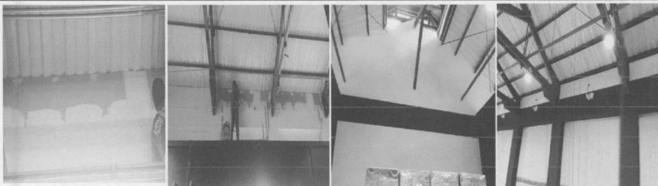
INSTALACION DE SUPERBOARD EN NAVE CENTRAL Y SALON MUTIPLE
