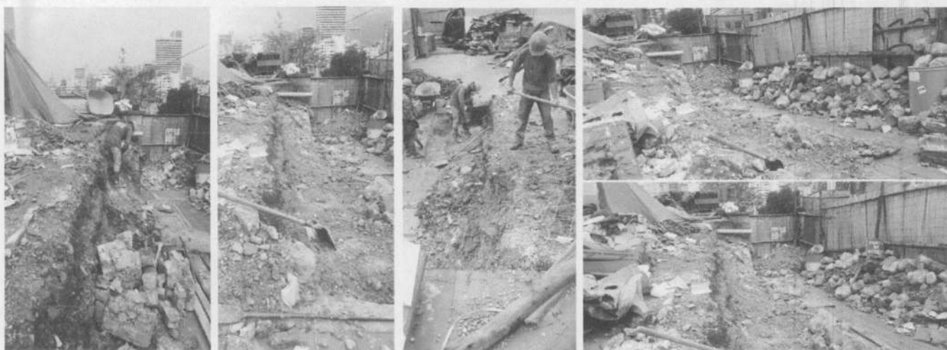
DEMOLICION DE ESTRUCTURAS EN CONCRETO PARA INSTALACION DE MURO DE CONTENCION ZONA NORTE
