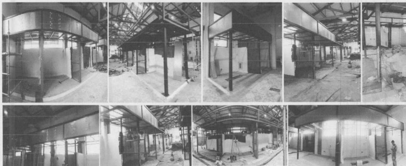
INSTALACION DE LAMINA COLLROLLED PARA AVISOS , MASILLADO Y PULIDA E INSTALACION DE PINTURA ANTICORROSIVA Y ESMALTE EN ESTRUCTURA METALICA DE MODULOS EN NAVE CENTRAL
