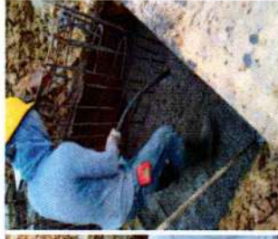
ACERO DE REFUERZO PARA CONSTRUCCION DE MURO DE CONTENCIÓN PLAZOLETA NORTE.
