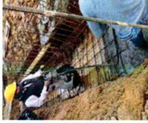
ACERO DE REFUERZO PARA CONSTRUCCION DE MURO DE CONTENCIÓN PLAZOLETA EXTERIOR.
