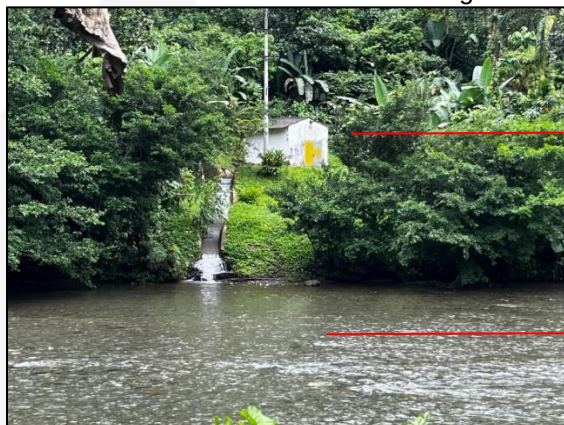
Registro fotográfico 2. Caseta PCH
