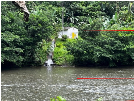
Registro fotográfico 2. Caseta PCH
