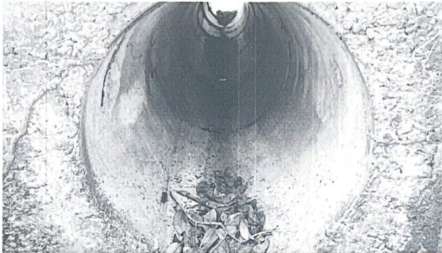
Imagen 5. Estructura hidráulica en buen estado
