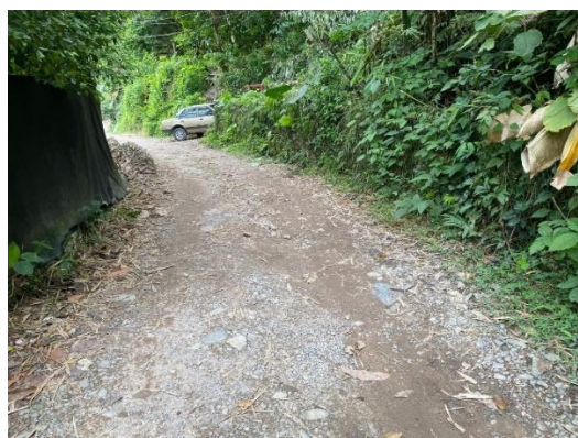
Foto No 4 Estado de la vía actual
