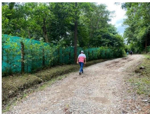
Foto No 6 Estado de la vía actual
