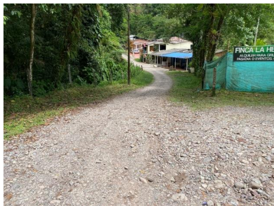
Foto No 2 Estado de la vía actual
