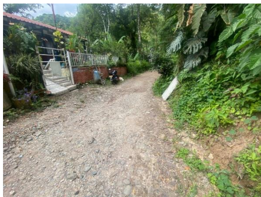
Foto No 5 Estado de la vía actual
