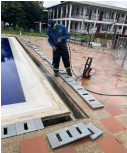
Limpieza de Rejillas
