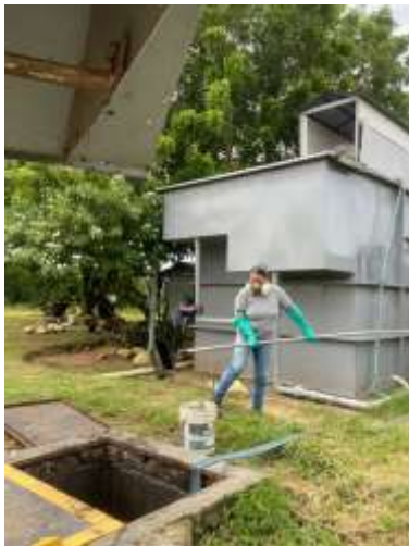
Limpieza Tanque Cribado
