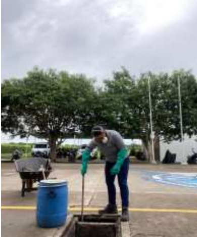
Limpieza Trampa de Grasas
