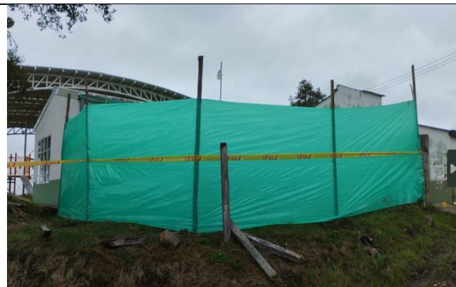
Cerramiento de obra
