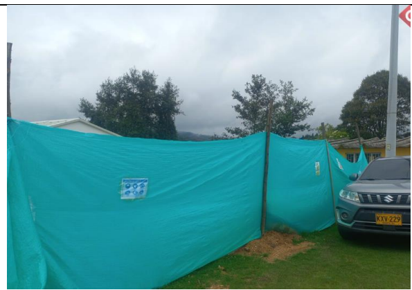
Cerramiento de obra
