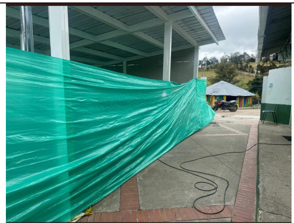
Cerramiento de obra
