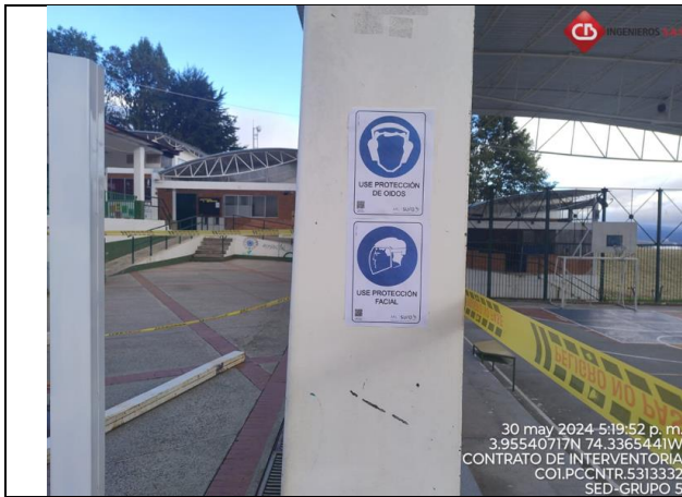
Señalización en obra
