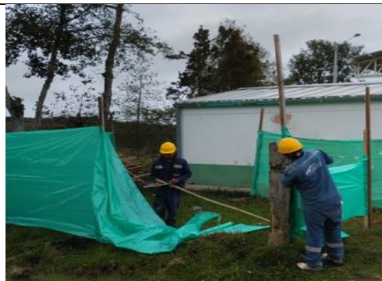
Cerramiento de obra
