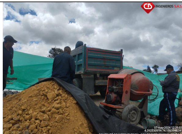
Equipos y maquinaria en obra
