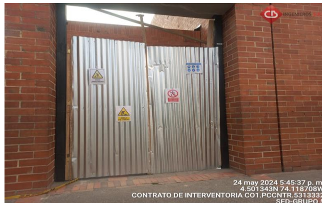
Señalización en obra
