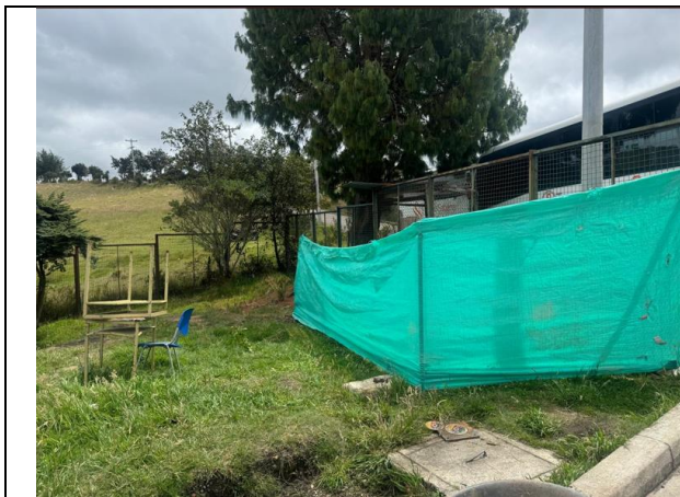
Cerramiento en obra
