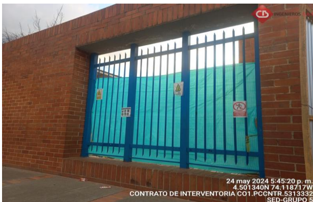
Cerramiento de obra
