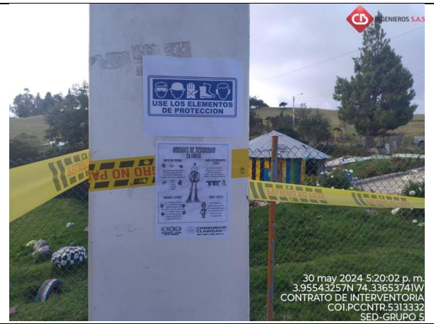
Señalización en obra
