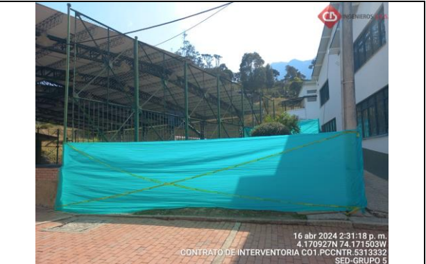
Cerramiento de obra
