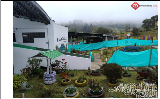
Cerramiento de obra
