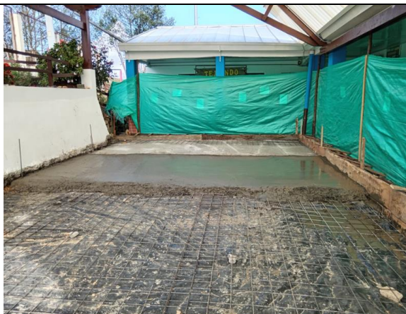
Cerramiento de obra
