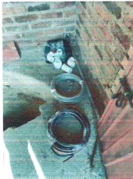
Materiales usados en la instalación
