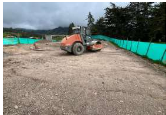
COMPACTACIÓN AFIRMADO URBANISMO
