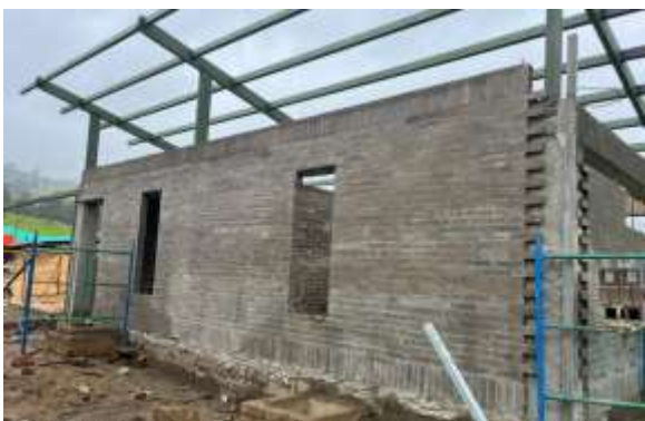
ENCHAPE VIGAS AÉREAS EN LADRILLO
