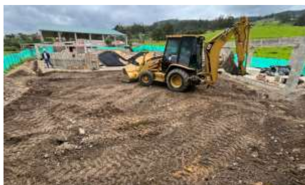
INSTALACIÓN AFIRMADO URBANISMO Y GIMNASIO
