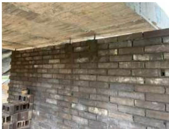
MAMPOSTERIA Y ANCLAJE DOVELAS
