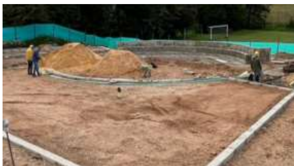
INSTALACIÓN DUCTOS ELÉCTRICOS
