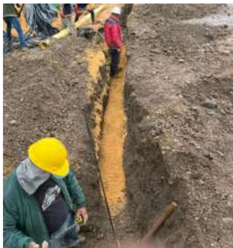
ZANJA E INSTALACIÓN TUBERÍA RED AGUAS LLUVIA
