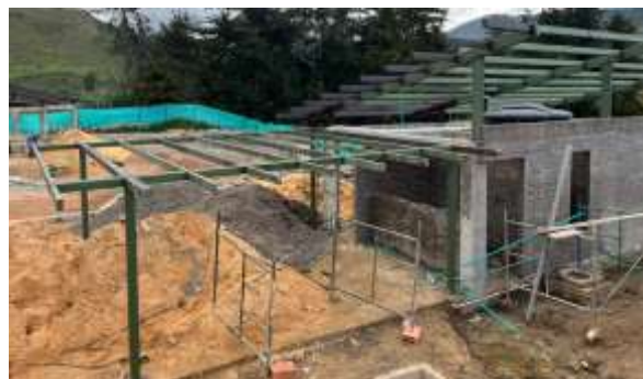
ESTRUCTURA METÁLICA PERGOLA ED. SERVICIOS
