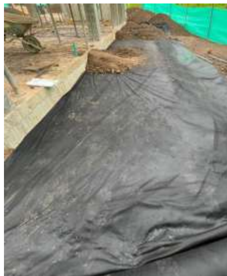
INSTALACIÓN GEOTEXTIL URBANISMO
