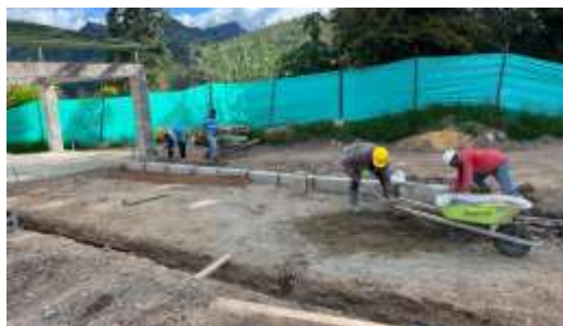
INSTALACIÓN SARDINEL GIMNASIO
