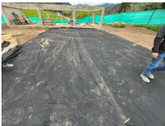
INSTALACIÓN GEOTEXTIL GIMNASIO VITAL
