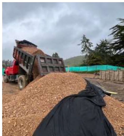
TRANSPORTE SUBBASE URBANISMO Y GIMNASIO
