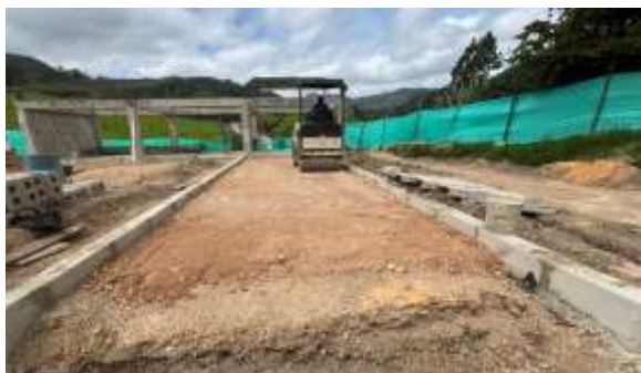
COMPACTACIÓN SUBBASE GIMNASIO
