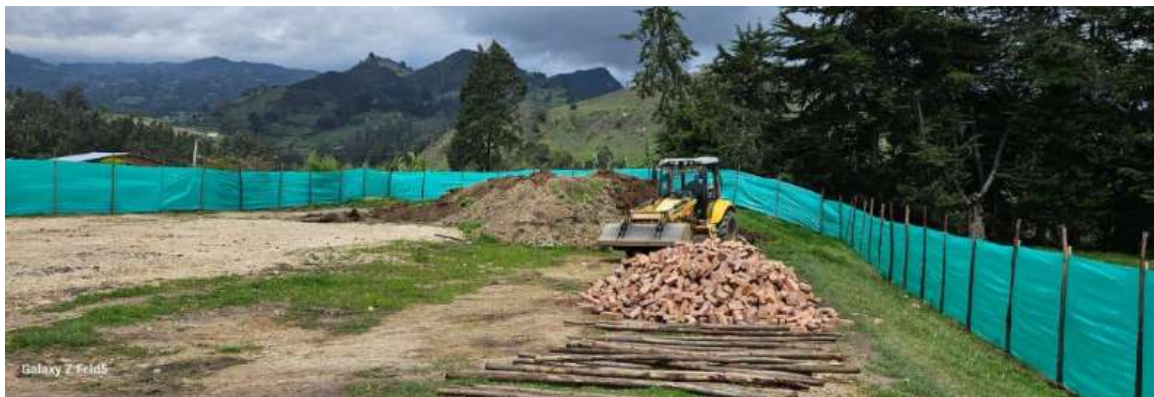
IMAGEN No 4 – ESTADO DE PREDIO PARA INICIO DE OBRA
