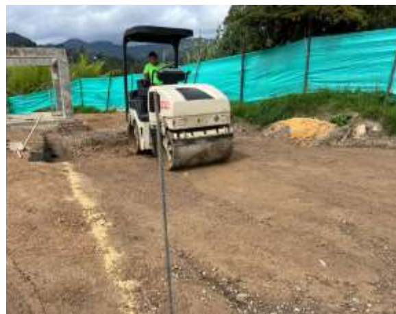
COMPACTACIÓN AFIRMADO URBANISMO
