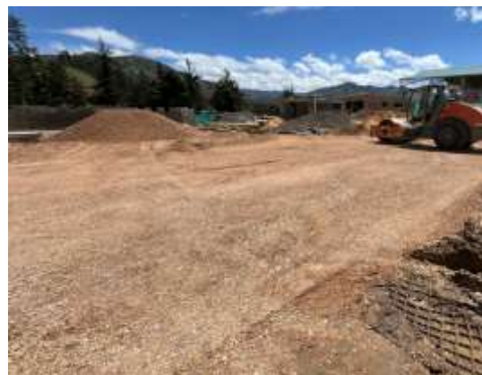
COMPACTACIÓN SUBBASE URBANISMO
