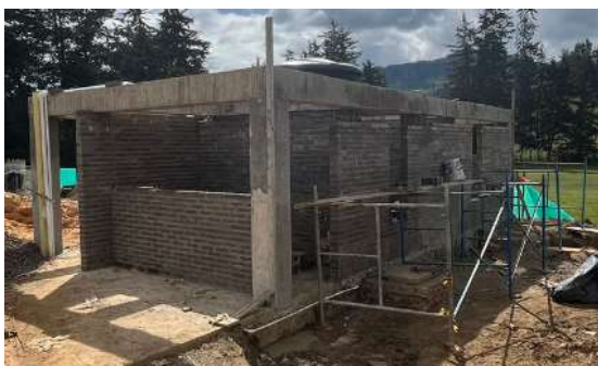
MAMPOSTERÍA ED. SERVICIOS
