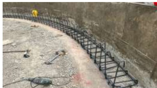
ACERO DE REFUERZO MURO GRADERÍAS
