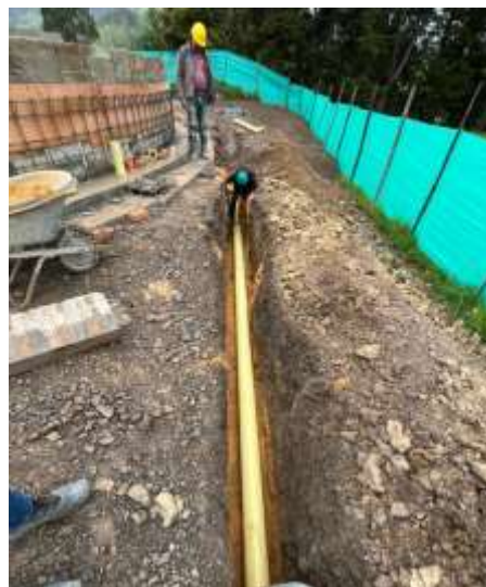
ZANJA E INSTALACIÓN TUBERÍA RED AGUAS LLUVIA
