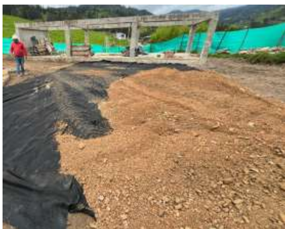
INSTALACIÓN SUBBASE GIMNASIO VITAL
