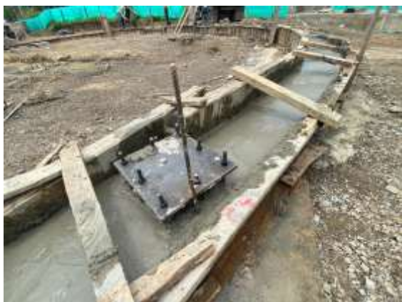
VIGA DE CIMENTACIÓN ED. POLIVALENTE
