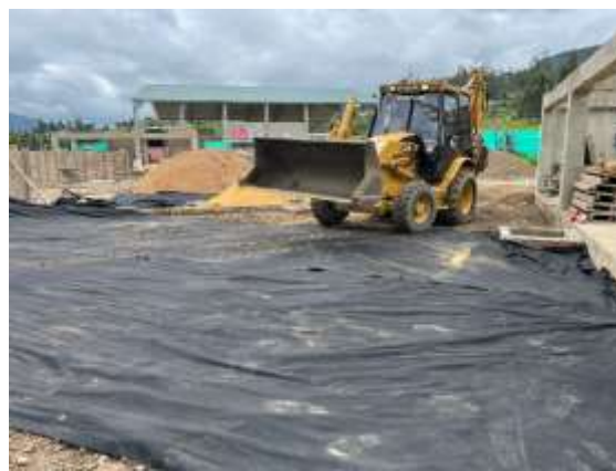
INSTALACIÓN GEOTEXTIL URBANISMO
