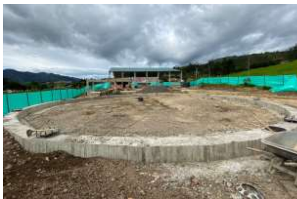
VIGA DE CIMENTACIÓN Y PLATINAS ED. POLIVALENTE
