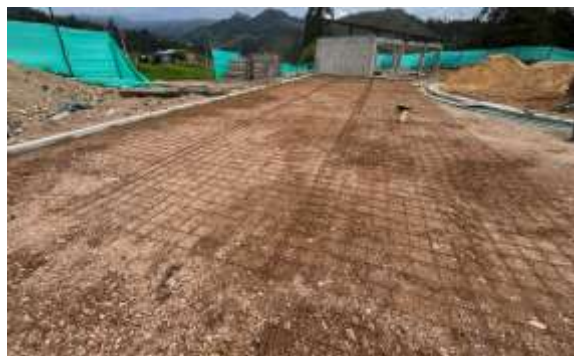
MALLA ELECTROSOLDADA PLACA PARQUE
