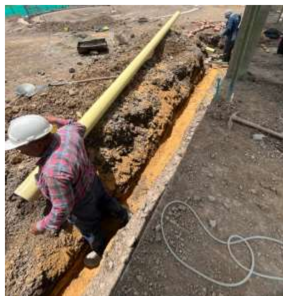
ZANJA E INSTALACIÓN TUBERÍA RED AGUAS LLUVIAS
