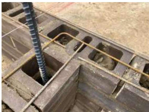
DOVELAS Y GRAFILES MAMOSTERÍA ED. SERVICIOS
