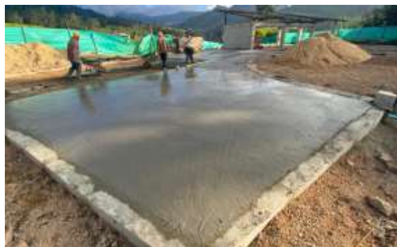
PLACA DE CONCRETO PARQUE INFANTIL
