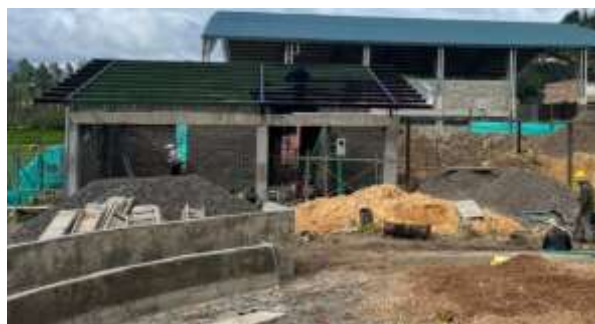
PINTURA ESTRUCTURA ED. SERVICIOS
