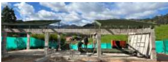
ESTRUCTURA METÁLICA ED. COMPLEMENTARIO
