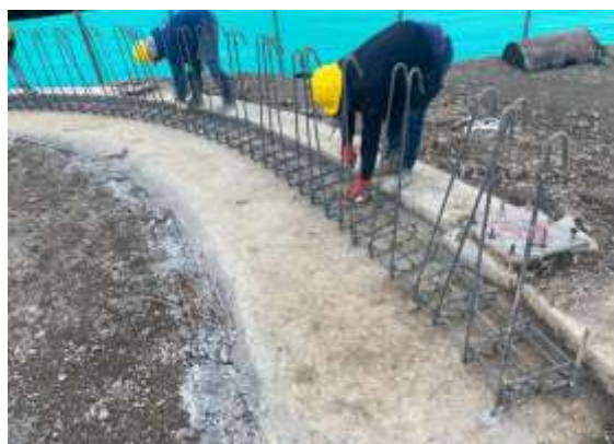
ACERO MURO GRADERÍAS ED. POLIVALENTE
