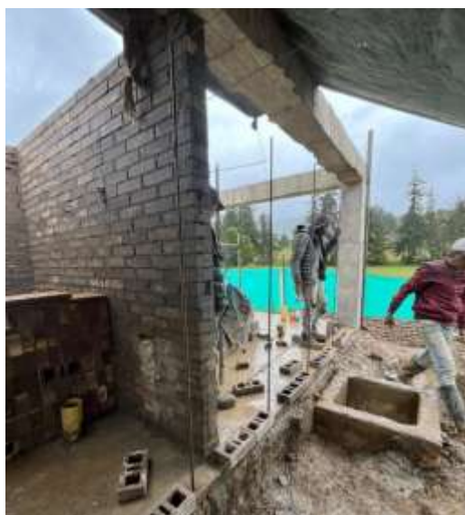
ANCLAJE DOVELAS ED. SERVICIOS
