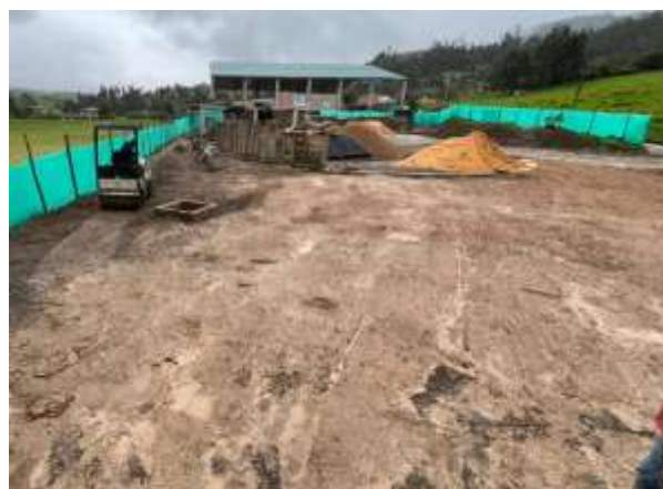
COMPACTACIÓN AFIRMADO URBANISMO
