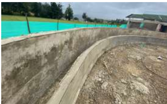
MUROS DE CONTENCIÓN GRADERÍAS
