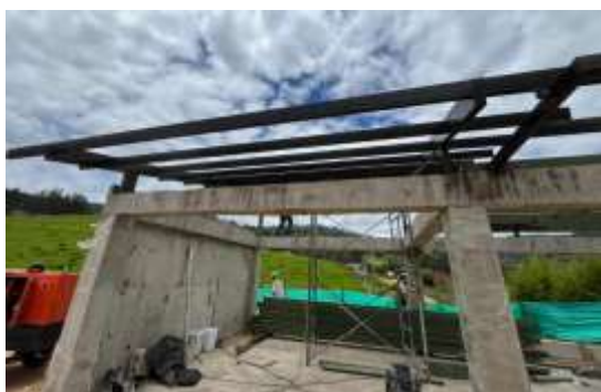
PINTURA ESTRUCTURA METÁLICA ED. COMPLEM.
