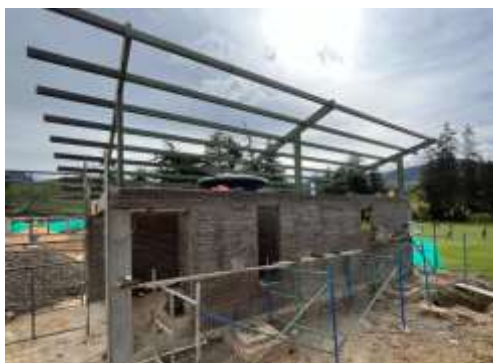
ESTRUCTURA METÁLICA ED. SERVICIOS
