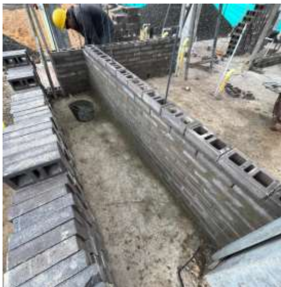
MAMPOSTERÍA ED. SERVICIOS
