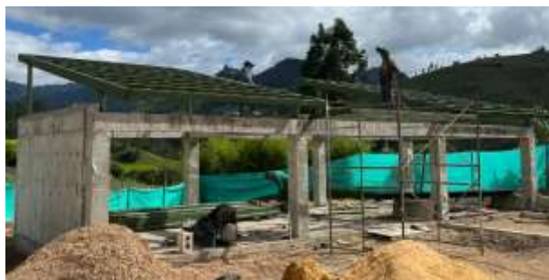
ESTRUCTURA METÁLICA ED. COMPLEMENTARIO
