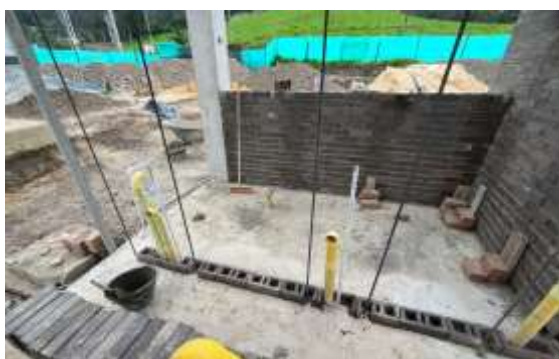
ANCJALE ELEMENTOS NO ESTRUCTURALES
