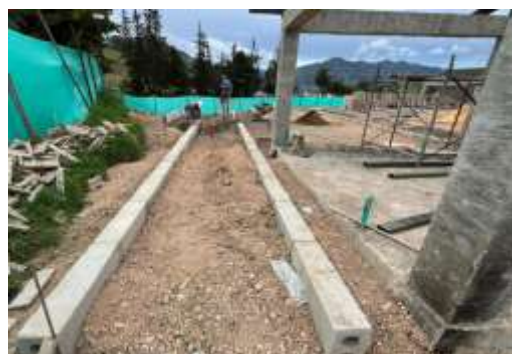
INSTALACIÓN SARDINEL PISTA DE TROTE
