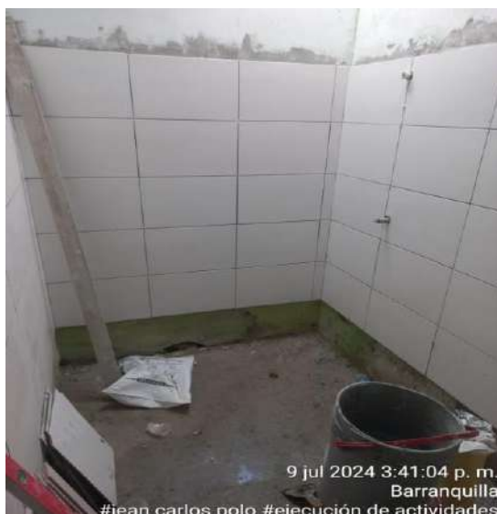
Imagen 4 Ejecución de actividades, barrio las Malvinas, Propietario: Jean Carlos Polo
