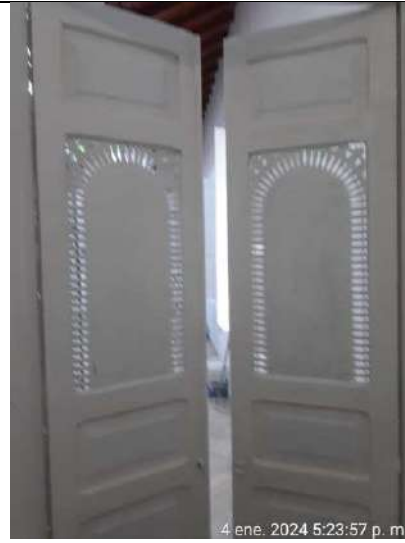
MANTENIMIENTO DE PUERTAS DE MADERA
