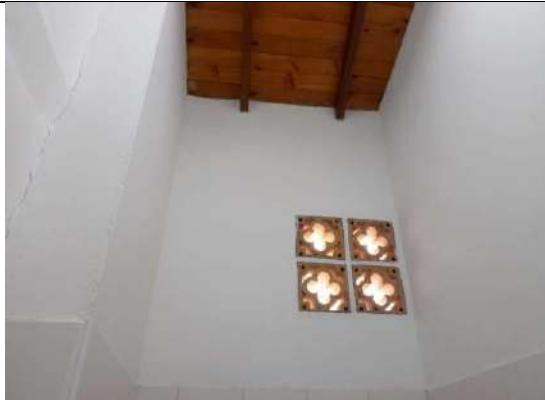
APLICACIÓN DE VINILO SOBRE MUROS INTERIORES
