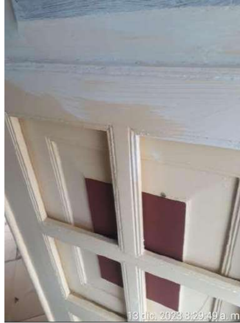
PINTURA IGNIFUGA CONTRA INCENDIOS SOBRE MADERA
