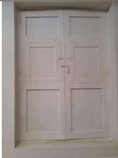
MANTENIMIENTO DE VENTANAS DE MADERA
