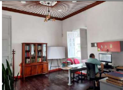
APLICACIÓN DE VINILO SOBRE MUROS INTERIORES
