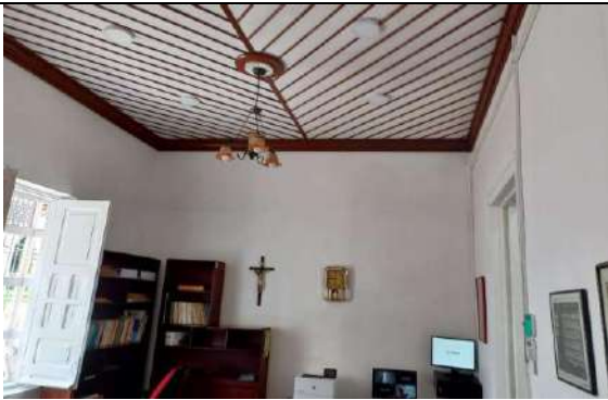
APLICACIÓN DE VINILO SOBRE MUROS INTERIORES
