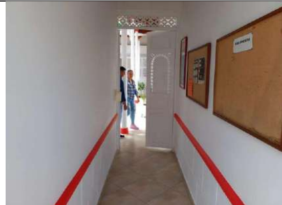
APLICACIÓN DE VINILO SOBRE MUROS INTERIORES
