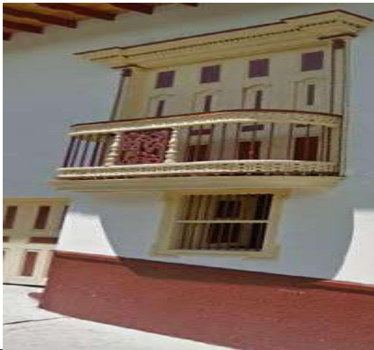
MANTENIMIENTO DE BARANDAS DE MADERA
