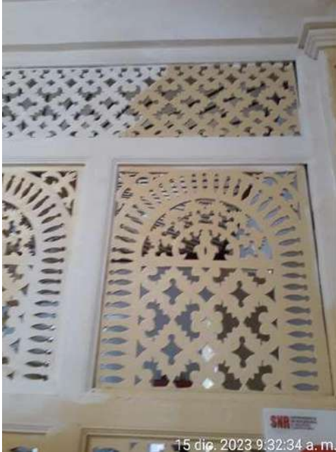
PINTURA IGNIFUGA CONTRA INCENDIOS SOBRE MADERA
