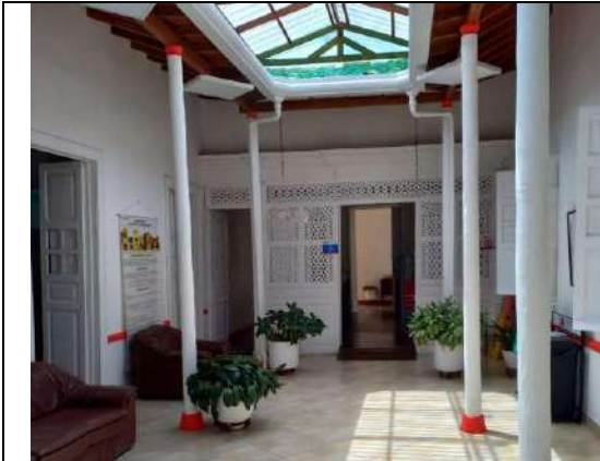
SONDEO Y LIMPIEZA DE CANALES Y BAJANTES
