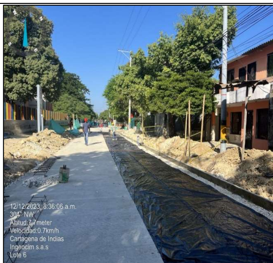
Suministro de plástico negro y canastillas de juntas constructivas en tramo a fundir en el frente de la Venao Flórez.
