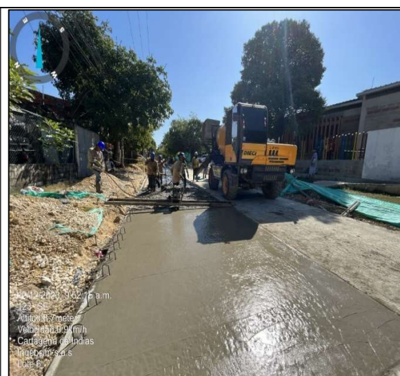
Suministro e instalación de concreto rígido MR-42 calle 31b entre Cra 59 y Cra 56 o transversal 56 (Avenida Venao Flórez).
