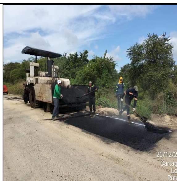
Continuación del Suministro e instalación de asfalto en la variante ruta 90.
