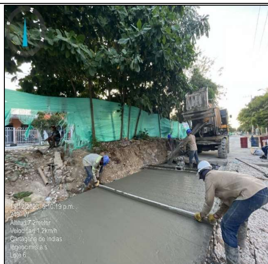
Excavaciones calle 31b entre Cra 59 y Cra 56 (avenida Antonio Venao Flores) km 0+200 - k0+220 calzada completa
