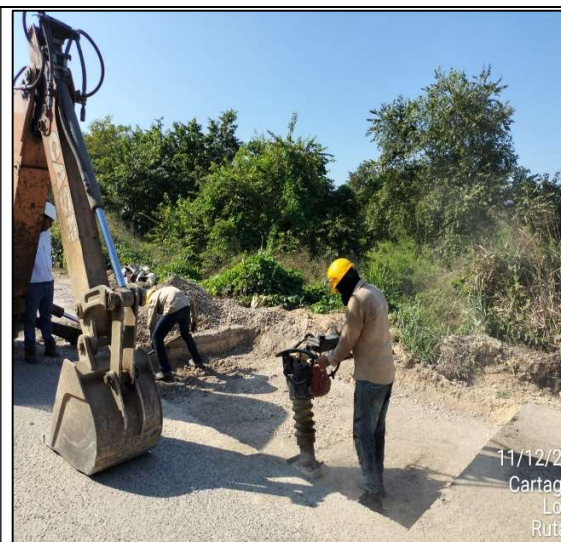
Compactaciones de algunos tramos añadidos para el mejoramiento de la variante ruta 90
