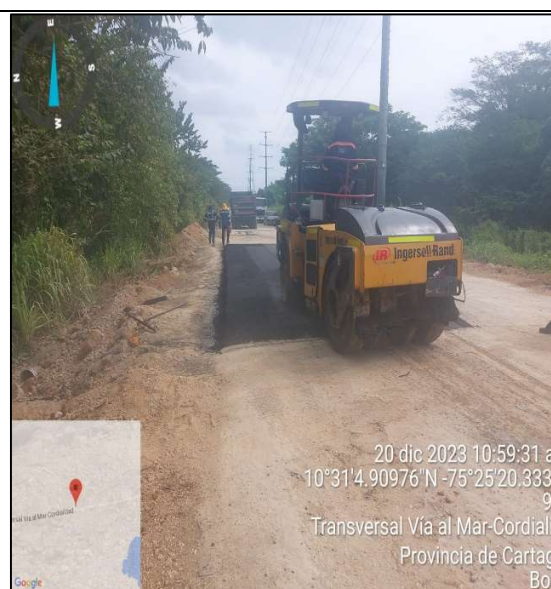
Compactaciones de asfalto mediante el uso de vibrocompactador de llantas en la variante ruta 90.
