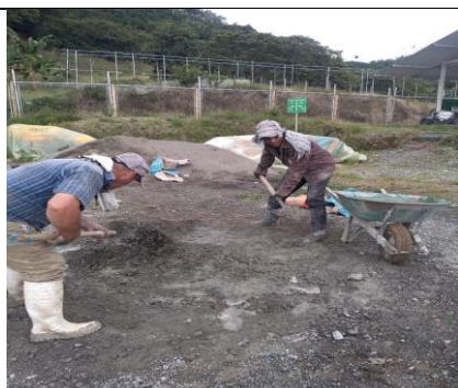
Apoyo en la construcción de muros donde están los equipos de la escuela de café
