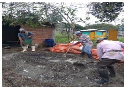
Apoyo en la construcción de la bodega del proyecto avícola
