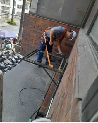
AIRE ACONDICIONADO # 1 (PISOTECHO INVERTER 60.000 BTU INSTALADO)
