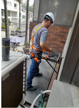
AIRE ACONDICIONADO # 1 (PISOTECHO INVERTER 60.000 BTU INSTALADO)
