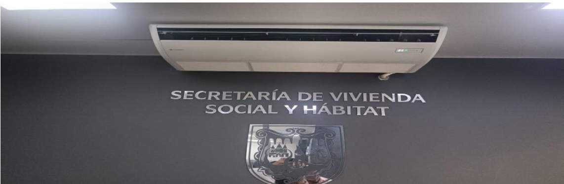
AIRE ACONDICIONADO #2 (PISOTECHO INVERTER 60.000 BTU INSTALADO)
