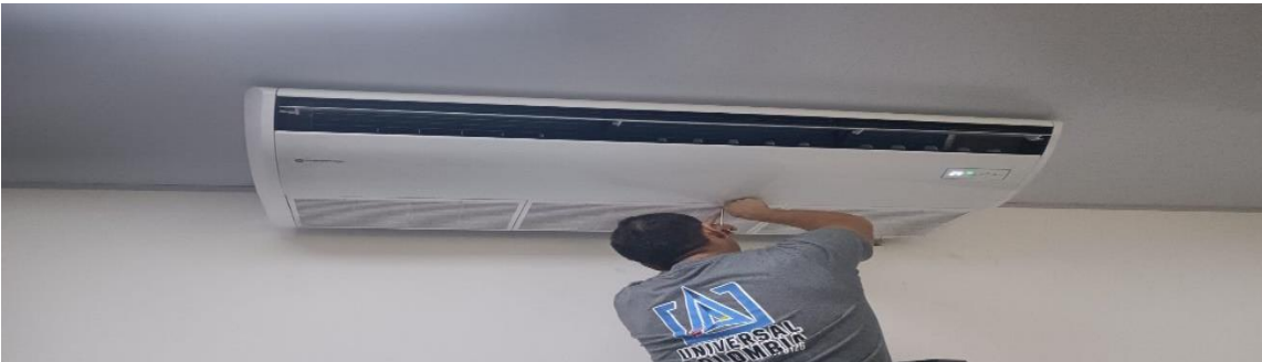
AIRE ACONDICIONADO #2 (PISOTECHO INVERTER 60.000 BTU INSTALADO)
