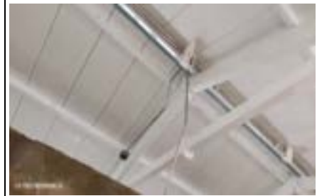
Se realiza aplicación de primera de pintura en habitaciones y pasillo
