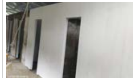
Se realiza aplicación de primera de pintura en habitaciones y pasillo
