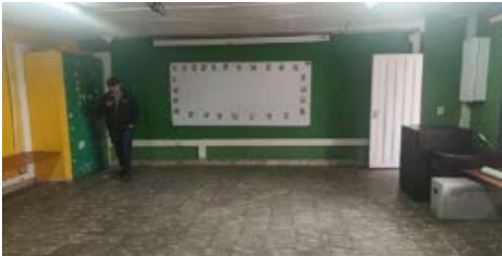
FOTO 1: MUROS Y PUERA PRINCIPAL
