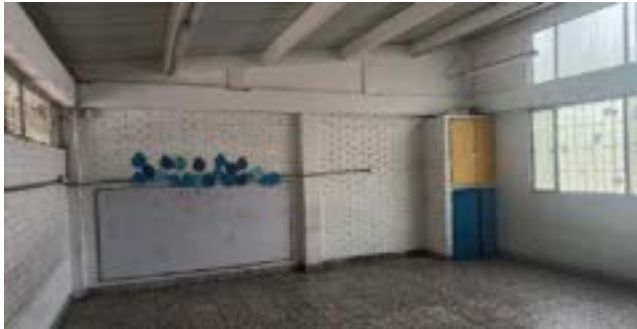
FOTO 1: VENTANAS Y DEPOSITO
