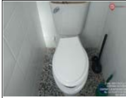
AVANCE: GIMNASIO DEL CAMPO JUAN DE LA CRUZ VARELA SEDE SAN JUAN
