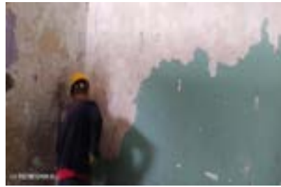
Se realiza aplicación de impermeabilizante en habitaciones docentes
