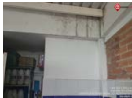
ESTADO INICIAL: GIMNASIO DEL CAMPO JUAN DE LA CRUZ VARELA SEDE SAN JUAN
