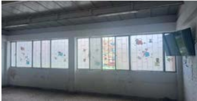
FOTO 1: VENTANAS Y APARATOS ELECTRICOS
