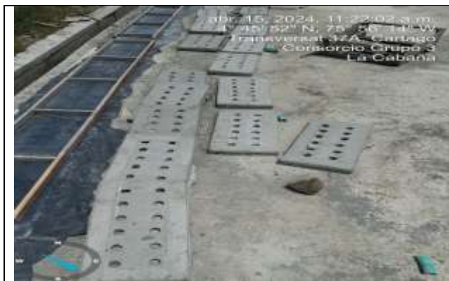
Construcción de tapas del canal perimetral
