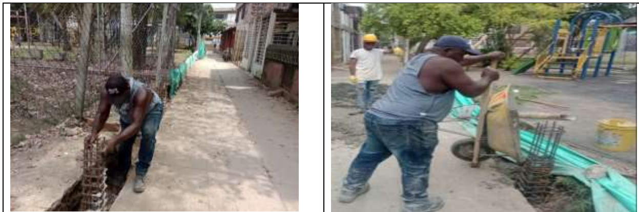
Fundición caissons
