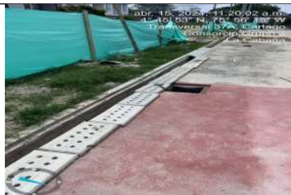
Construcción de tapas del canal perimetral
