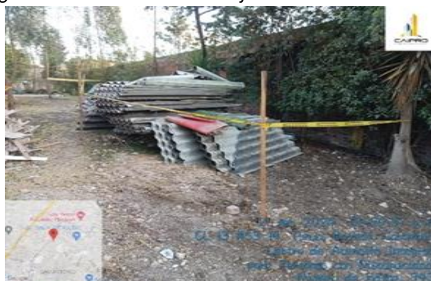
Figura 5. Señalización De Teja De Asbesto Cemento.
