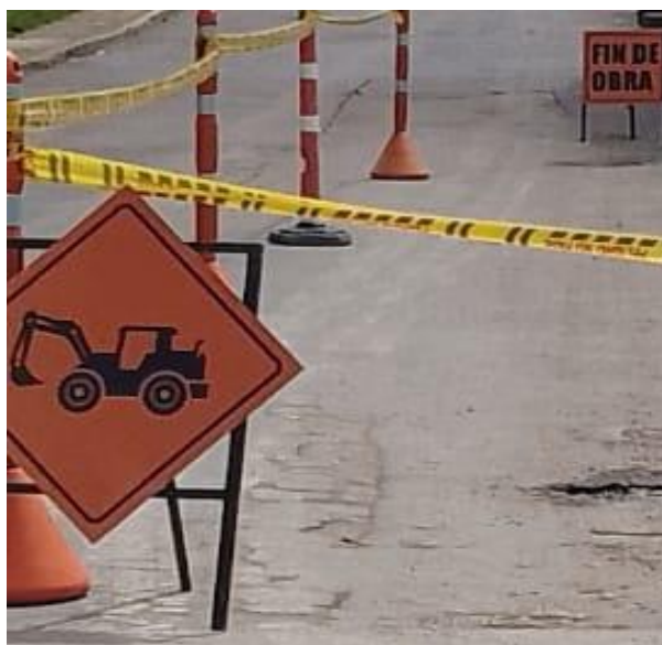
Figura 10. Señalización De Maquinaria Pesada Y Fin De Obra.
