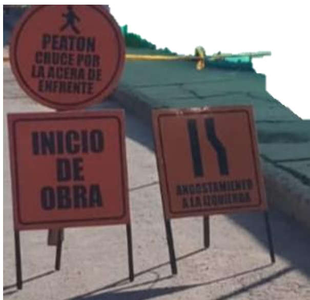
Figura 9. Señalización De Inicio De Obra, Peatón Cruce Por La Acera De Enfrente.
