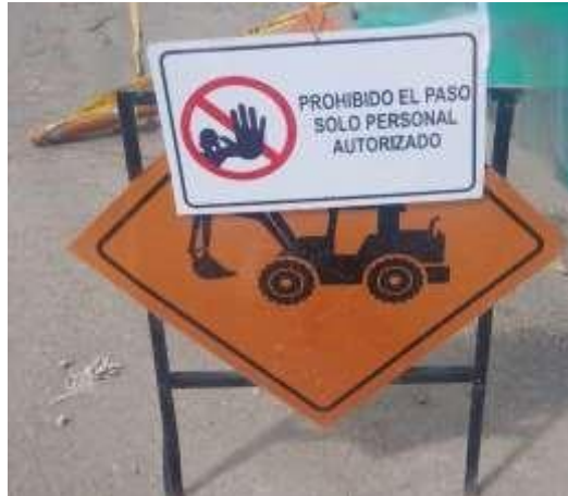
Figura 6. Señalización De Prohibido El Paso Y Señalización De Vehículos De Carga Pesada.
