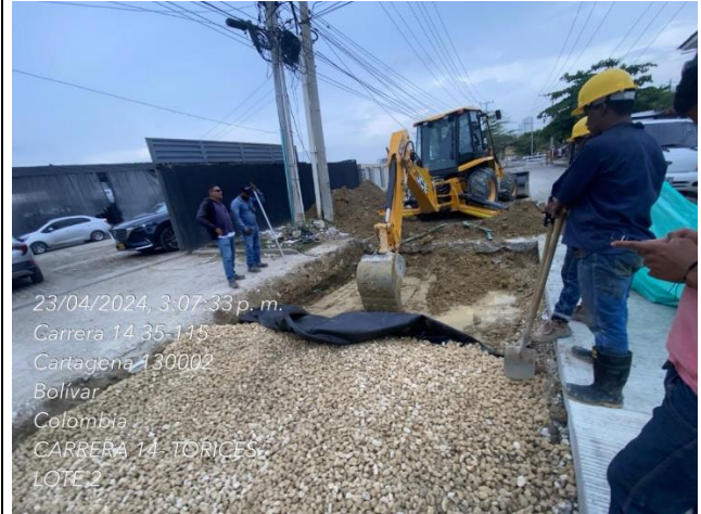
Relleno con piedra rajón y material triturado abs k0+200 calzada izquierda.
