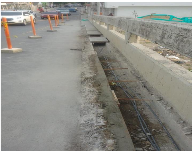
Demolición de andenes existentes Puente sentido Canapote- Crespo.
