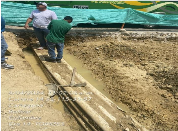
Tubería eléctrica abs k0+200 protección con suelo cemento y triturado.
