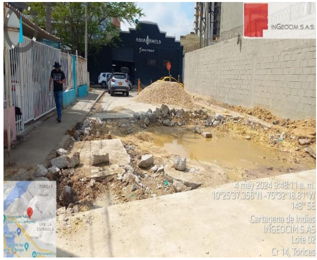
Demolición bocacalle 34ª.
