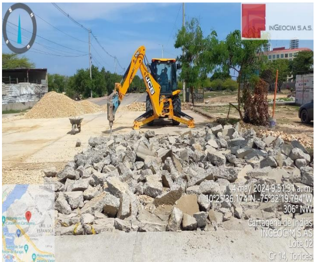
Demolición bocacalle 35 (ed. Inteligente)
