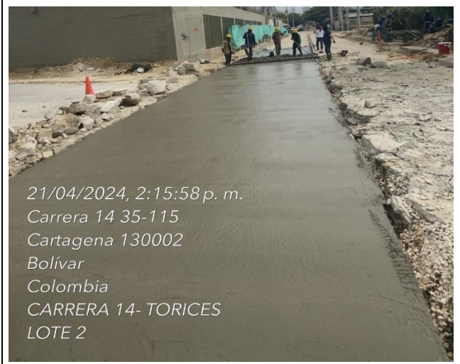
Vaciado de concreto MR-42 AC a 3 días entre abs k0+210 a k0+190 calzada derecha.
