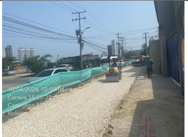
Relleno de material seleccionado triturado calzada derecha.
