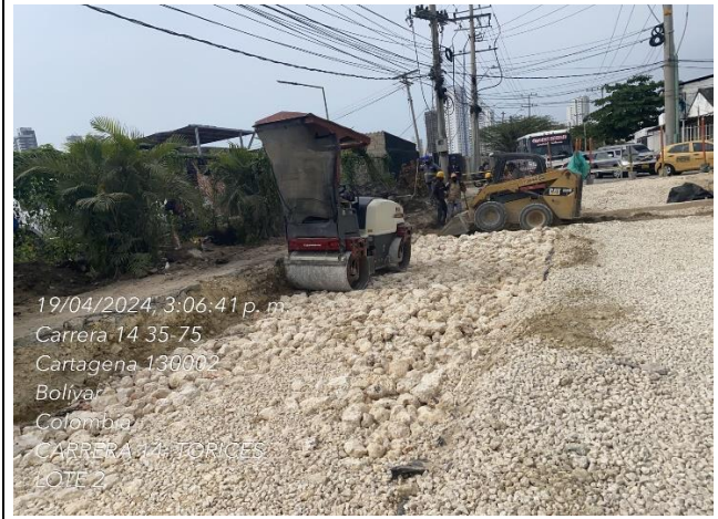
Relleno con piedra rajon y material triturado K0+202- K0+210
