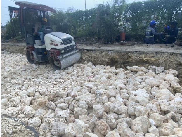
Relleno con piedra rajon y material triturado K0+202- K0+210
