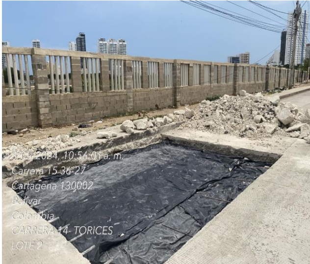
Instalación de plástico k0+281
