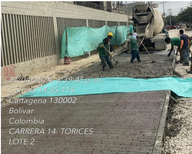
Vaciado de concreto MR-42 AC a 3 días entre abs k0+210 a k0+190 calzada derecha.
