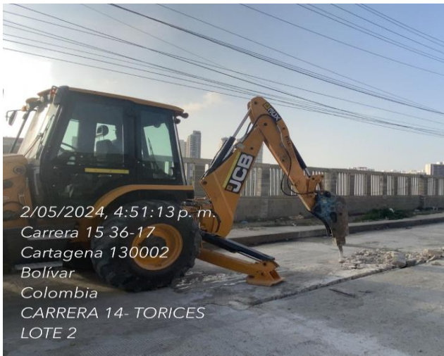
Demolición, excavación, relleno con material triturado K0+300 –K0+309
