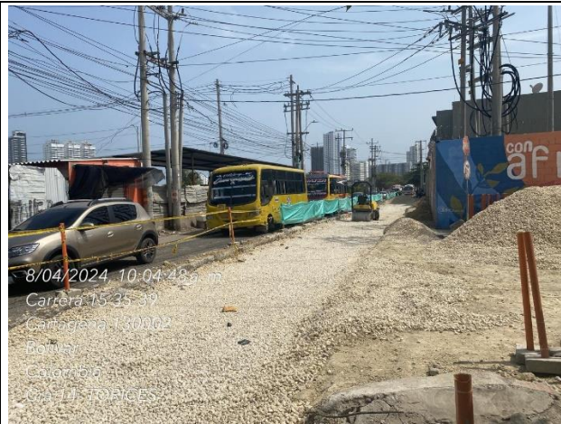
Relleno de material seleccionado triturado calzada derecha.
