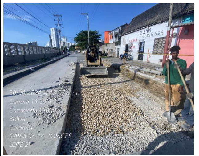
Demolición, excavación, relleno con material triturado K0+300 –K0+309
