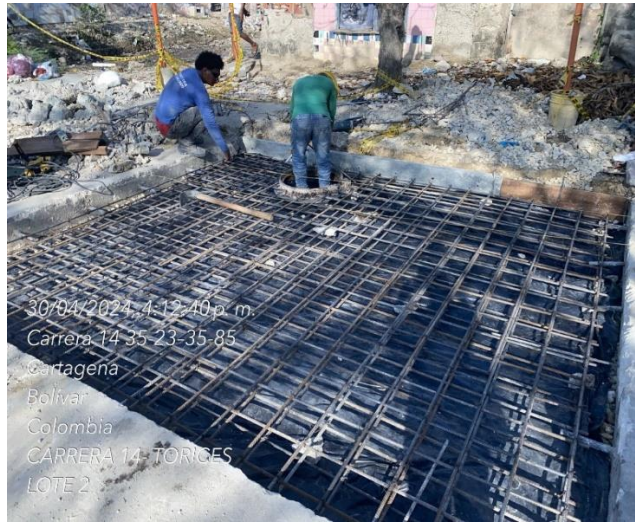
Refuerzo losa k0+281
