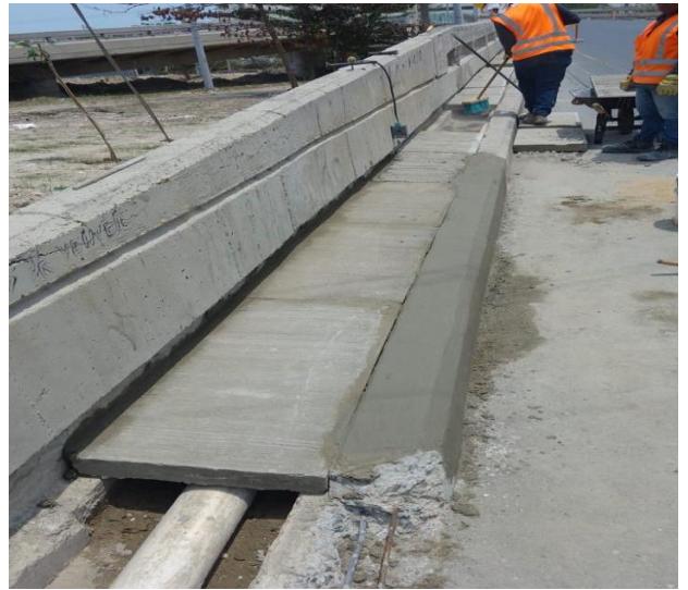
Andenes en concreto f'c: 3500 psi sentido Canapote- Crespo.
