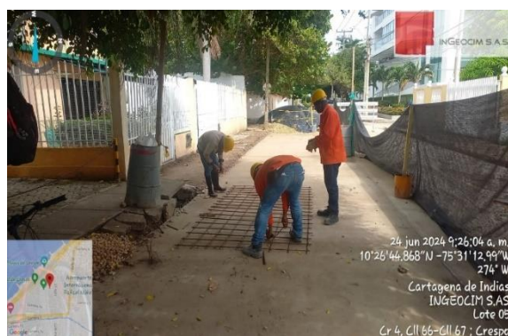
Sector Crespo, Carrera 4ta entre calles 66 y 67: Acero de refuerzo en placas especiales y otras estructuras.
