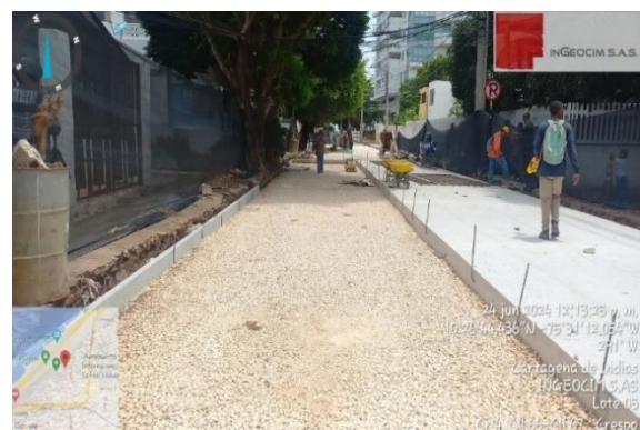
Sector Crespo, Carrera 4ta entre calles 66 y 67: Relleno con material seleccionado triturado 3/4\"/>
