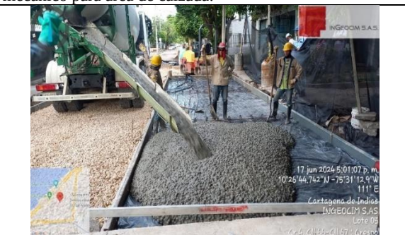
Sector Crespo, Carrera 4ta entre calles 66 y 67: Pavimento en concreto rígido MR 42 - normal, e=0,20 m incluye refuerzo y canastilla de 1/4", con pasadores de 1" L=0,35 m c/0,30m, barras de amarre de 1/2" L= 0,85m c/1,20m, antisol, plástico, rieles y mano de obra.
