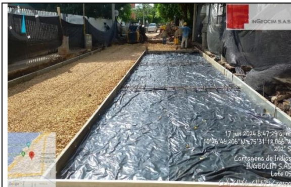
Sector Crespo, Carrera 4ta entre calles 66 y 67: Suministro y colocación de geotextil T-2400.
