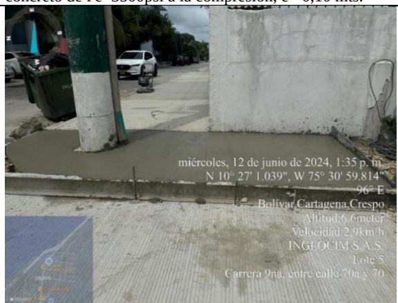
Sector Crespo, Carrera 5ta entre calles 69ª y 68: Andenes en concreto de f'c=3500\text{psi} a la compresión, e=0,10 mts.
