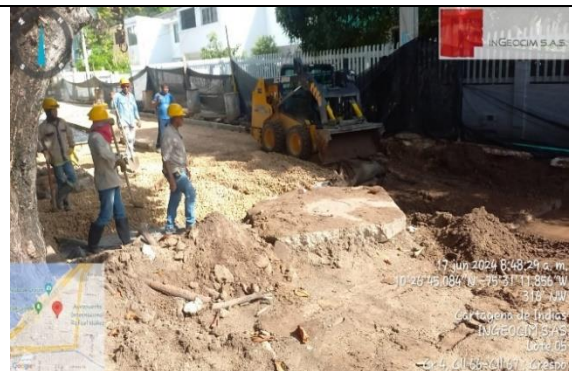
Sector Crespo, Carrera 4ta entre calles 66 y 67: Corte mecánico para área de calzada.
