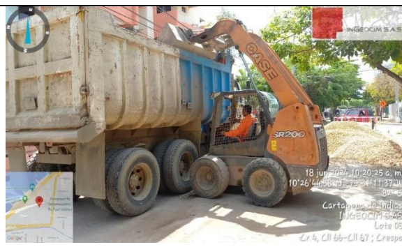
Sector Crespo, Carrera 4ta entre calles 66 y 67: Cargue, transporte y disposición final de material sobrante en sitio autorizado por la Autoridad Ambiental.
