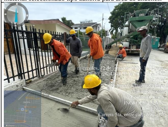
Sector Crespo, Carrera 5ta entre calles 68 y 67: Relleno con material seleccionado tipo zahorra para área de andenes.
