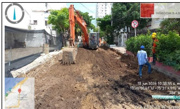
Sector Crespo, Carrera 6ta entre calles 70 y 67: Corte mecánico para área de calzada.
