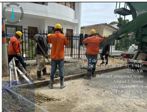
Sector Crespo, Carrera 5ta entre calles 69ª y 68: Andenes en concreto de f'c=3500\text{psi} a la compresión, e=0,10 mts.
