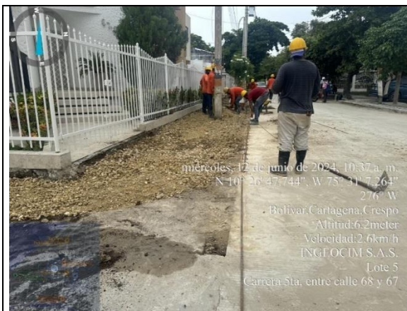
Sector Crespo, Carrera 5ta entre calles 68 y 67: Relleno con material seleccionado tipo zahorra para área de andenes.
