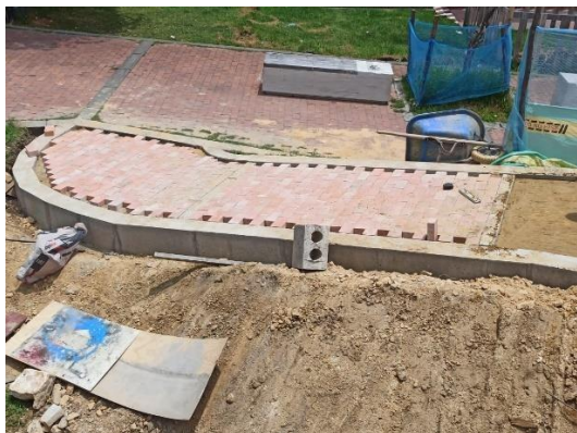
Instalación adoquín terracota
