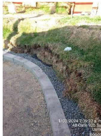
Lleno y conformación filtro graderías Lote A
