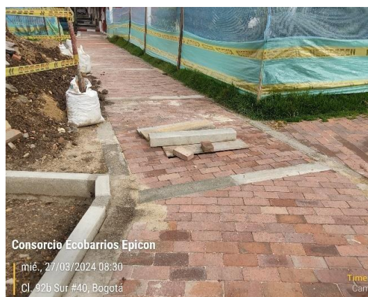
Restauración paños adoquín
