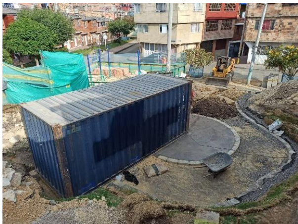
Lleno y conformación filtro graderías Lote A
