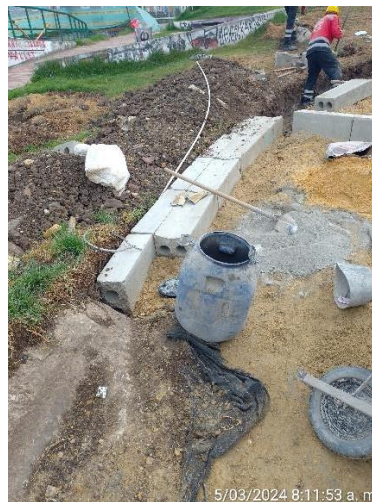
Instalación de cañuela en sendero peatonal
