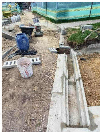
Instalación rejilla aguas lluvias
