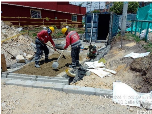
Conformación paños sendero peatonal
