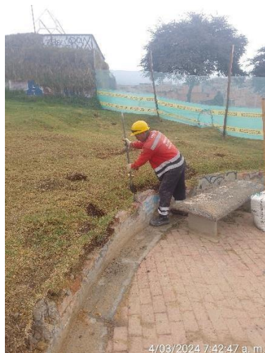
Excavación para dados cerramiento M-83
