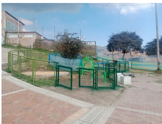
instalación cerramiento M-83
