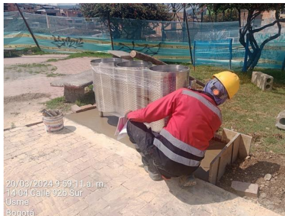
Instalación punto ecológico
