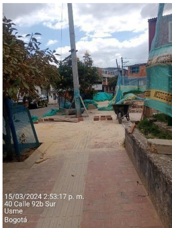
Excavación manual filtro
