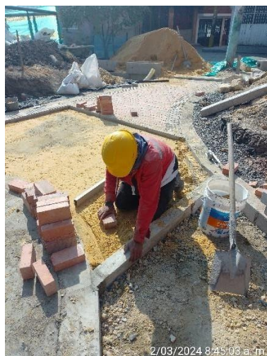
Instalación de adoquín
