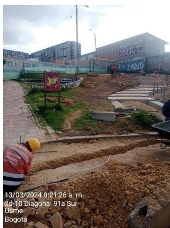
Excavación rejilla aguas lluvias
