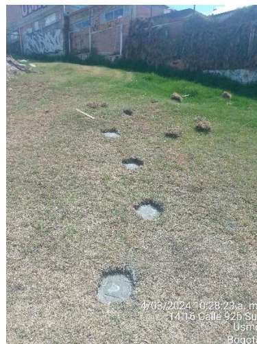
Dados en concreto para cerramiento M-83
