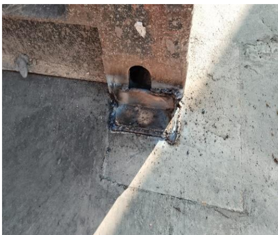
Soldadura plantinas container
