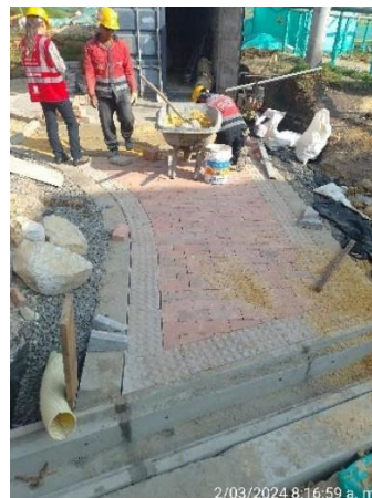
Instalación de adoquín
