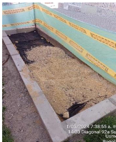
Instalación de geotextil y SBG-PEA
