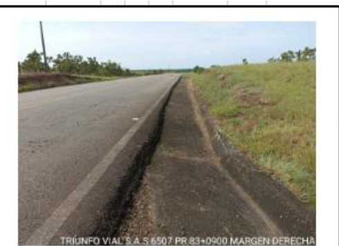
DESPUÉS -LIMPIEZA DE CUNETA, PR83+0900 / RUTA 6507
