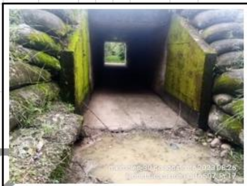
DESPUÉS, LIMPIEZA DE ALCANTARILLA PR17+0000 / RUTA 6507
