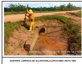
DURANTE - LIMPIEZA DE ALCANTARILLA, PR13+0500 / RUTA 7506
