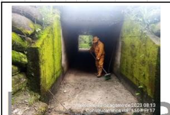
DURANTE, LIMPIEZA DE ALCANTARILLA PR17+0000 / RUTA 6507
