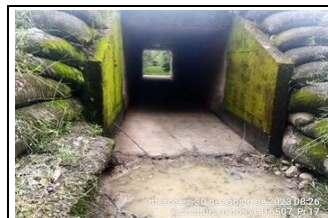
DESPUÉS, LIMPIEZA DE ALCANTARILLA PR17+0000 / RUTA 6507
