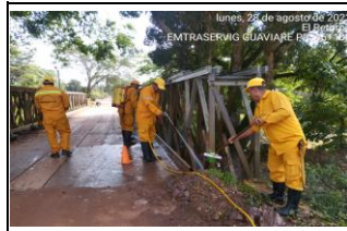
DURANTE - LIMPIEZA PUENTE CAÑO GRANDE PR46+0200 / RUTA 7506
