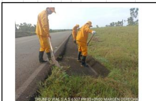
DURANTE - LIMPIEZA DE CUNETA, PR83+0900 / RUTA 6507
