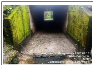
ANTES, LIMPIEZA DE ALCANTARILLA PR17+0000 / RUTA 6507
