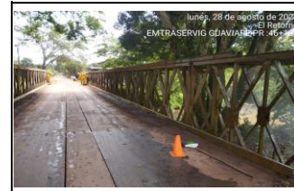
DESPUÉS - LIMPIEZA PUENTE CAÑO GRANDE PR46+0200 / RUTA 7506
