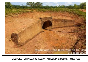
DESPUÉS - LIMPIEZA DE ALCANTARILLA, PR13+0500 / RUTA 7506
