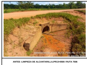
ANTES - LIMPIEZA DE ALCANTARILLA, PR13+0500 / RUTA 7506
