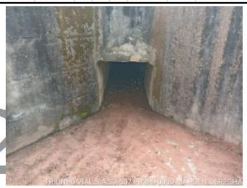
DESPUÉS -LIMPIEZA DE ALCANTARILLA, PR84+0000 / RUTA 6507
