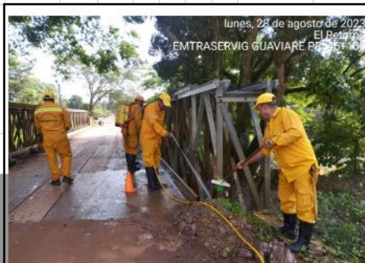
DURANTE - LIMPIEZA PUENTE CAÑO GRANDE PR46+0200 / RUTA7506
