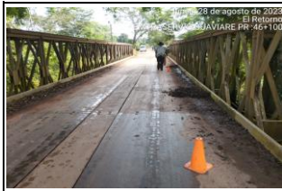
ANTES - LIMPIEZA PUENTE CAÑO GRANDE PR46+0200 / RUTA 7506
