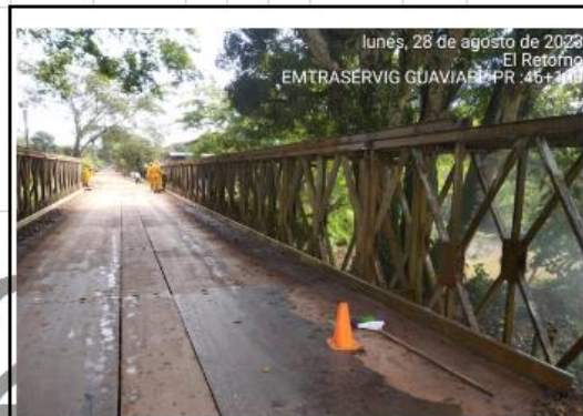
DESPUÉS - LIMPIEZA PUENTE CAÑO GRANDE PR46+0200 / RUTA7506
