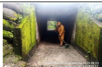
DURANTE, LIMPIEZA DE ALCANTARILLA PR17+0000 / RUTA 6507
