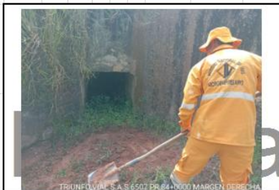
DURANTE -LIMPIEZA DE ALCANTARILLA, PR84+0000 / RUTA 6507
