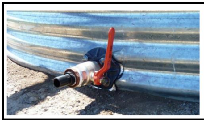
Brida de salida de agua
