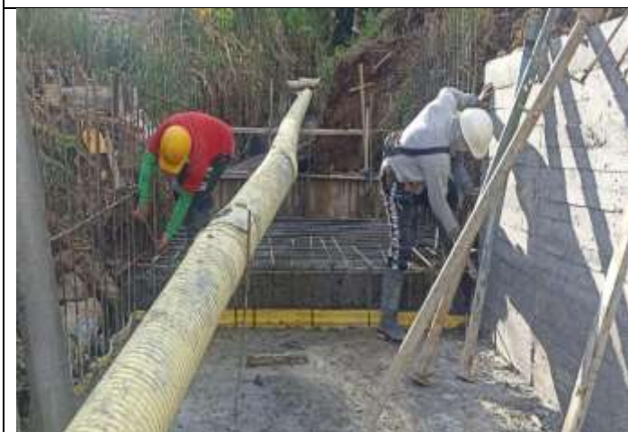
SUMINISTRO Y COLOCACION DE CONCRETO CICLOPEO DE 145 kg/cm 2 , espesor 0,20 m
