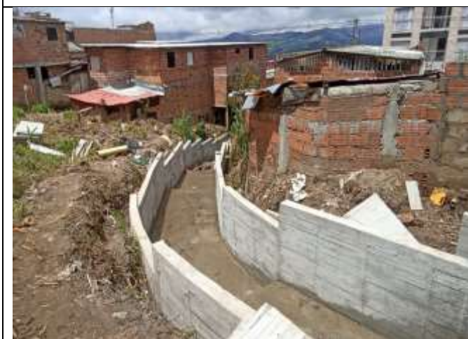
SUMINISTRO Y COLOCACION DE CONCRETO CICLOPEO DE 145 kg/cm 2 , espesor 0,20 m
