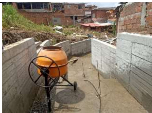
SUMINISTRO Y COLOCACION DE CONCRETO CICLOPEO DE 145 kg/cm 2 , espesor 0,20 m
