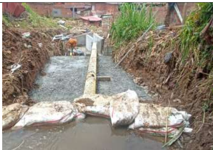
CONSTRUCCIÓN DE CANAL EN CONCRETO DE 21 MPA, con un ANCHO DE 2,8 m y un ALTO DE paredes de 1,5m, con espesor de 20 cm y INSTALACION DE CINTA PVC DE =22 CM EN JUNTAS DE CONSTRUCCION.
