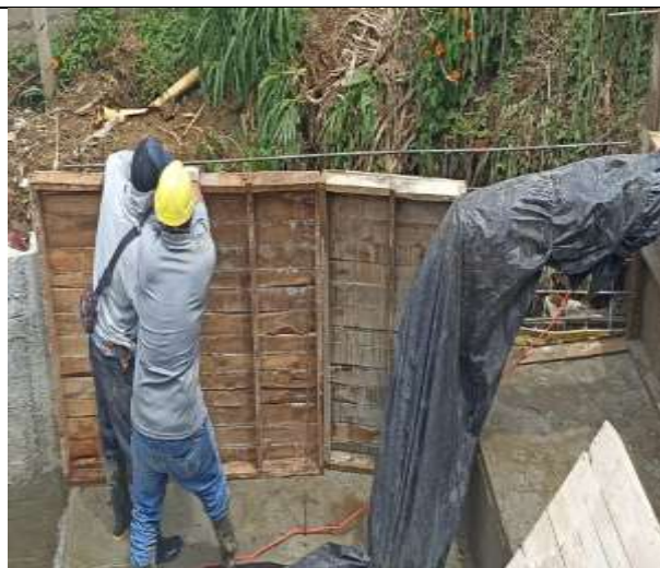
SUMINISTRO Y COLOCACION DE ACERO DE REFUERZO 4.200 kg/cm 2 (60.000 psi)
