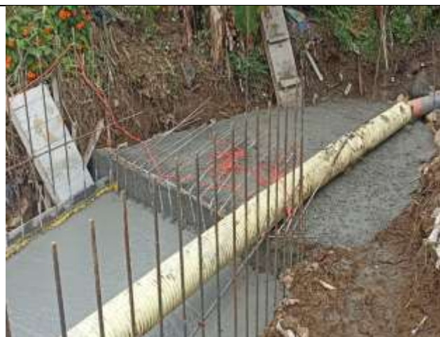
CONSTRUCCIÓN DE CANAL EN CONCRETO DE 21 MPA, con un ANCHO DE 2,8 m y un ALTO DE paredes de 1,5m, con espesor de 20 cm y INSTALACION DE CINTA PVC DE =22 CM EN JUNTAS DE CONSTRUCCION.
