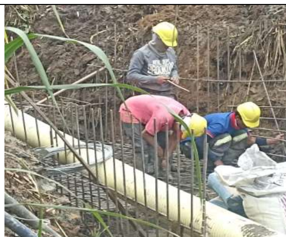
SUMINISTRO Y COLOCACION DE ACERO DE REFUERZO 4.200 kg/cm 2 (60.000 psi)
