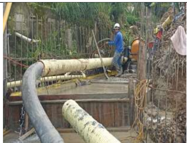
SUMINISTRO Y COLOCACIÓN DE SOLADO DE LIMPIEZA Y NIVELADO DE FONDOS
