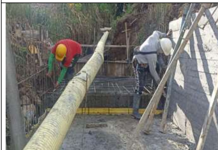
SUMINISTRO Y COLOCACION DE ACERO DE REFUERZO 4.200 kg/cm 2 (60.000 psi)
