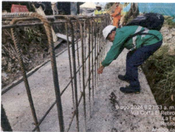
Foto N°11. Chequeo de la distancia de separación de acero en vástago de muro N°5
