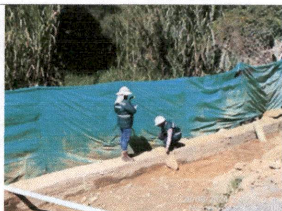
Foto N°42. Instalación de filtro en módulo de cierre muro de contención N°1
