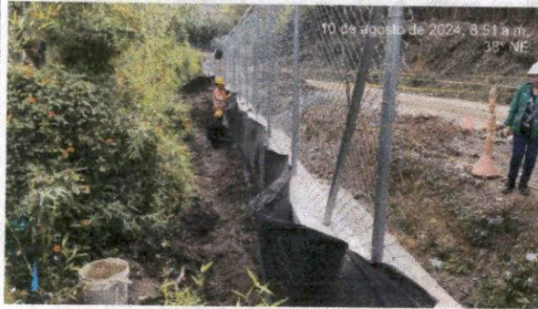
Foto N°13. Se continua con la construcción de filtro en muro de contención N°7
