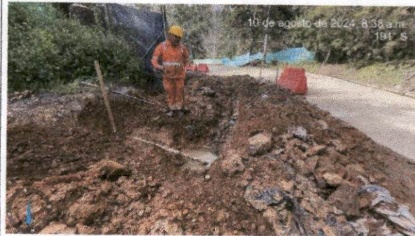
Foto N°14. Excavaciones manuales para la instalación de tubería sanitaria K2+280
