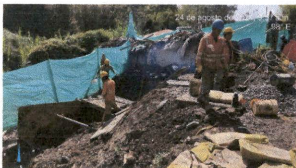
Foto N°27. Construcción de ciclópeo K1+720 muro de contención N°4
