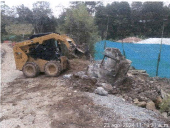
Foto N°35. Demolición de caja de aguas lluvias sector caballeriza K1+710
