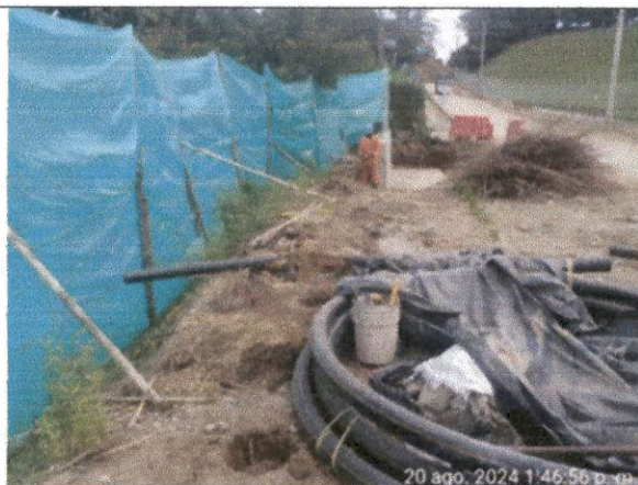
Foto N°25. Marcación y excavación manual de micropilotes viga de confinamiento N°4
