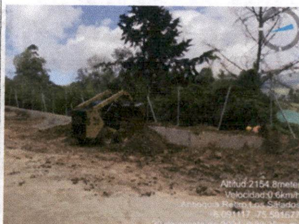
Foto N°32. Se realiza disposición del material de lleno en la parte posterior del muro de contención N°7
