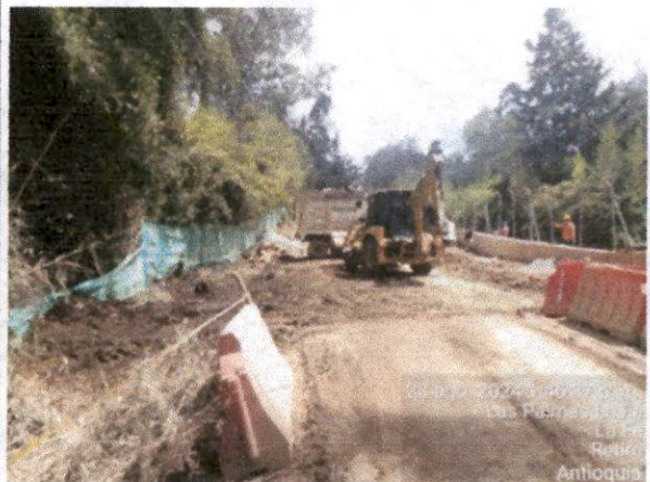
Foto N°36. Retiro de material de excavaciones K2+180
