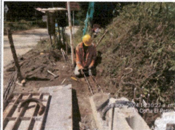
Foto N°50. Instalación de acero de refuerzo en viga de cerramiento, margen izquierda K1+300
