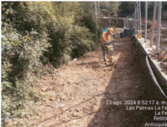
Foto N°33. Compactación del material de lleno en la parte posterior del muro de contención N°7
