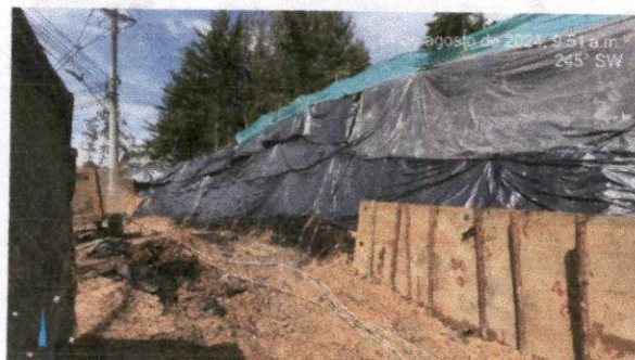
Foto N°29. Recubrimiento con plástico, entibado y retiro de pilotes debido al deslizamiento de material en el talud muro de contención N°5
