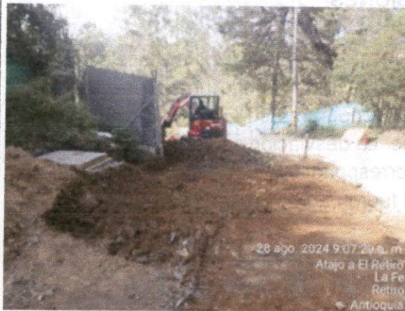
Foto N°53. Retiro de material no apto para llenos y levantamiento topográfico para llenos de estructura en sector ciclorruta K2+260 – K2+290
