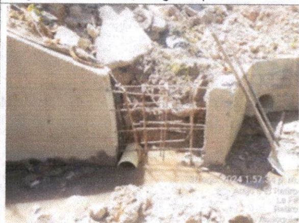
Foto N°50. Instalación de acero de refuerzo en viga de cerramiento, margen izquierda K1+300
