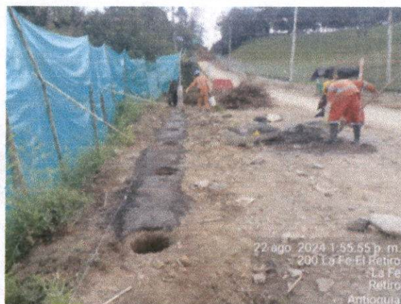
Foto N°26. Instalación de solado de limpieza para viga de confinamiento K1+610 viga de confinamiento N°4
