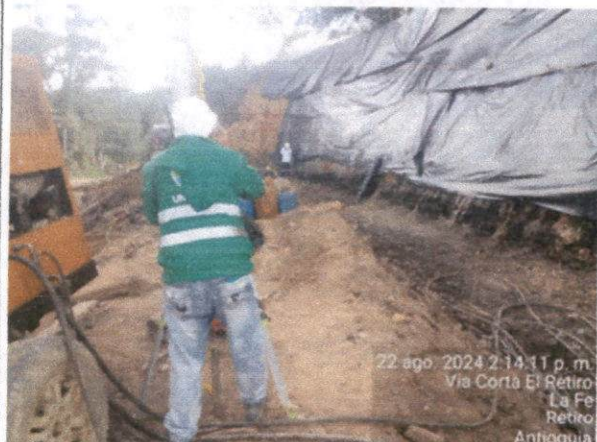
Foto N°31. Levantamiento topográfico de la excavación y construcción del muro de contención muro de contención N°5
