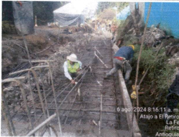
Foto N°9. Instalación de acero de refuerzo en zapatas de los módulos muro de contención N°5
