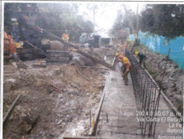
Foto N°10. Vaciado de concreto en vástago y zapata de los módulos muro de contención N°5
