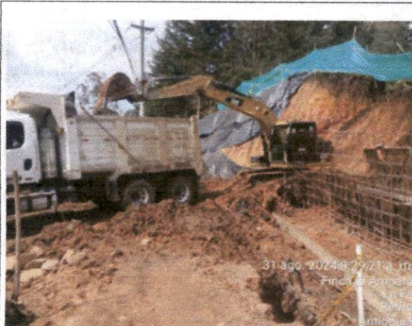
Foto N°49. Retiro de material resultante de deslizamiento muro de contención N°5
