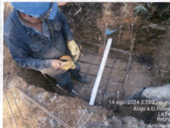
Foto N°20. Instalación de tubería sanitaria y construcción de caja para aguas residuales K2+290
