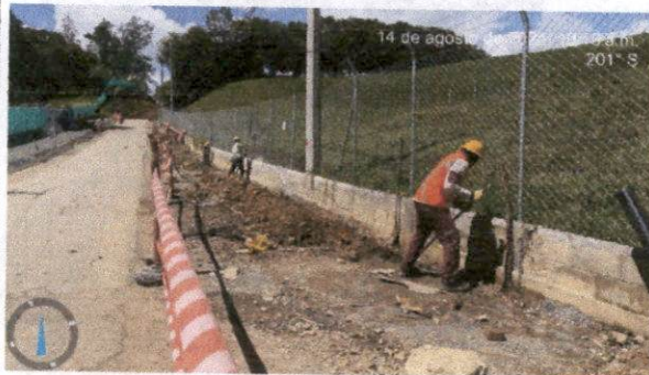
Foto N°21. Instalación de tubería de gas por parte de epm
