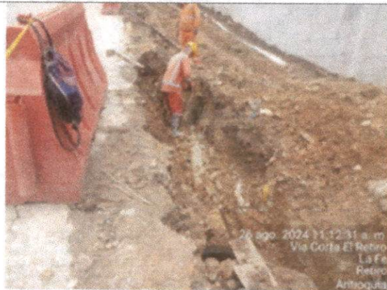
Foto N°49. Retiro de material resultante de deslizamiento muro de contención N°5
