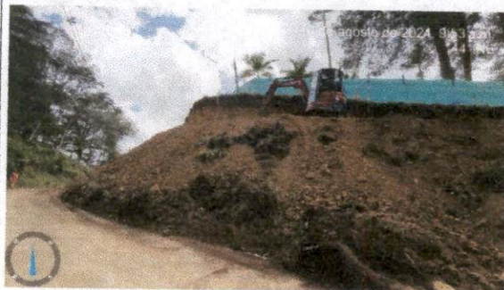
Foto N°5. Excavación y perfilamiento de terreno para implantación de muro N°3
