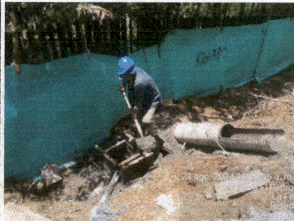
Foto N°38. Construcción de caja para empalme de poste de energía K2+330
