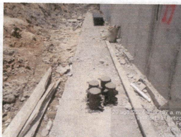
Foto N°30. Toma de muestra de cilindros del vástago módulo 17 muro de contención N°5
