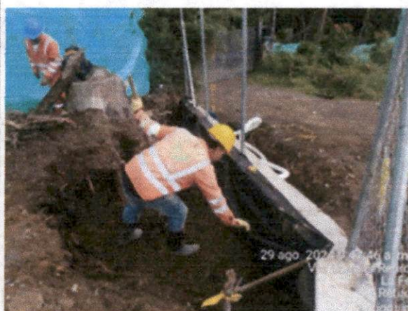
Foto N°42. Instalación de filtro en módulo de cierre muro de contención N°1
