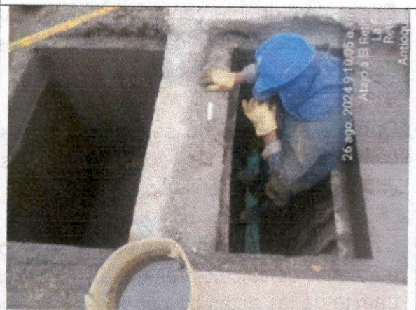
Foto N°54. Chequeo y marcación topográfica de sumidero sobre ciclorruta K2+280 - K2+360
