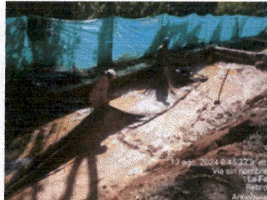
Foto N°18. Retiro de material saturado K1+740 muro de contención N°4
