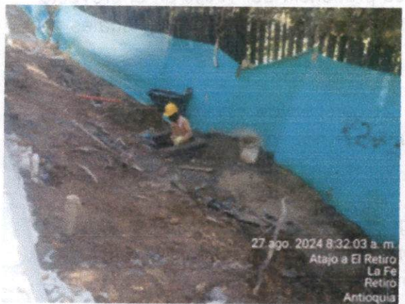
Foto N°55. Limpieza de caja empalme poste de energía K2+330
