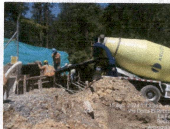
Foto N°16. Encofrado, vaciado de concreto y desencofrado de vástago en módulo de cierre muro de contención N°1
