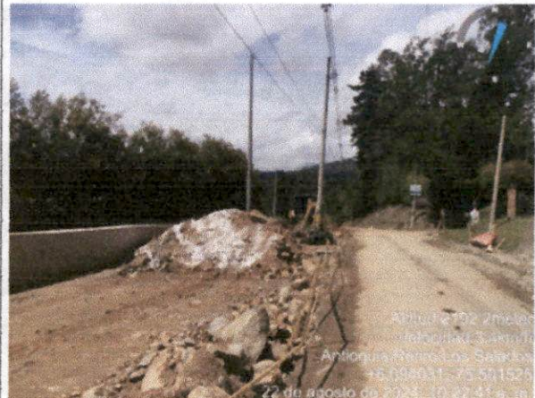
Foto N°34. Se realiza mejoramiento con Cal al material de afirmado dispuesto en la ciclorruta de muro de contención N°11
