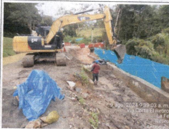
Foto N°5. Excavación y retiro de material K1+740 muro de contención N°4
