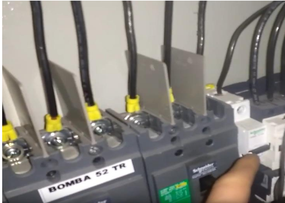
MARCADO DE CADA BREAKER ACUERDO MUESTRA, CONEXIONADO CON CONECTORES ACUERDO MUESTRA.
