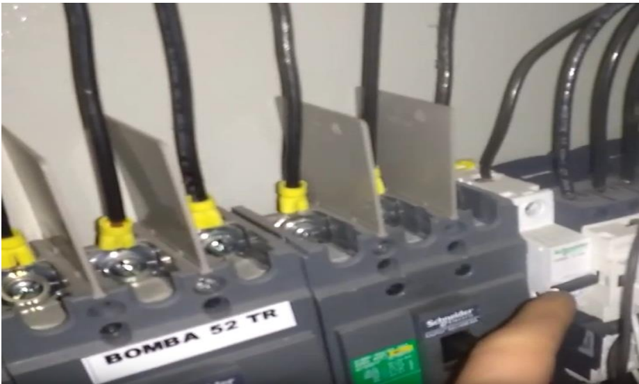
MARCADO DE CADA BREAKER ACUERDO MUESTRA, CONEXIONADO CON CONECTORES ACUERDO MUESTRA.
