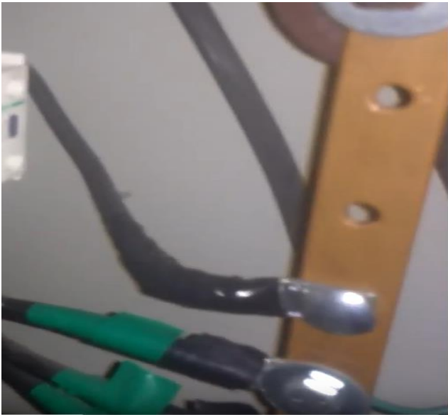
BARRAJE DE TIERRA CENTRAL ABAJO, CONEXIONADO CON TORNILLERÍA, CONECTORES.
