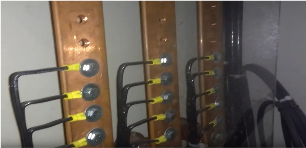
CONEXIÓN DE SALIDA, AJUJADO, ACRILICO, BARRAJE, TORNILLERÍA Y CONECTORES.
