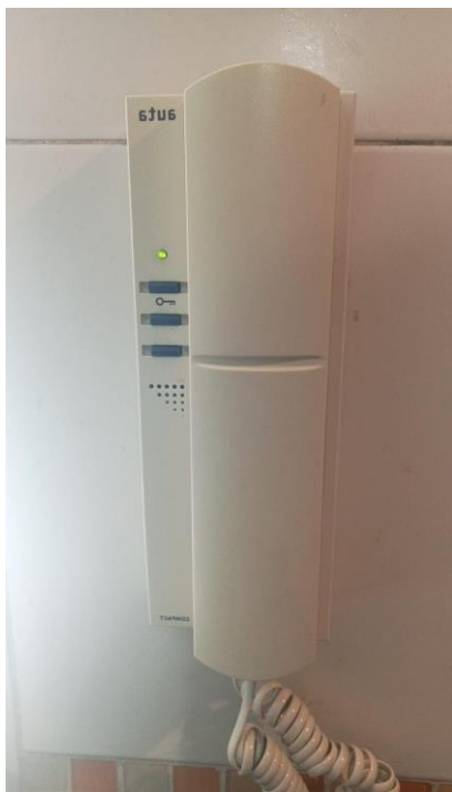
APARTAMENTO 503- TORRE B
