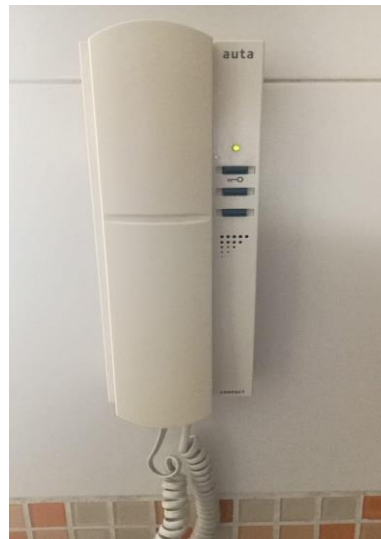
APARTAMENTO 103 – TORRE B
