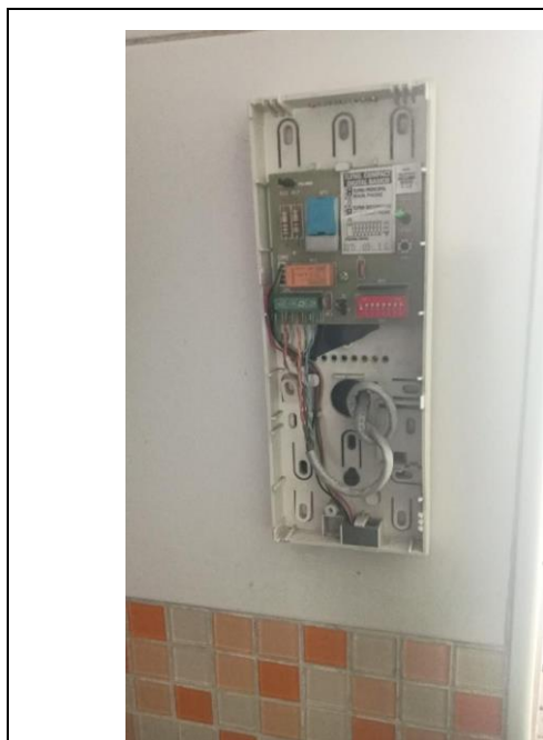
APTO 401 – TORRE A -EDIFICIO COLIBRI
