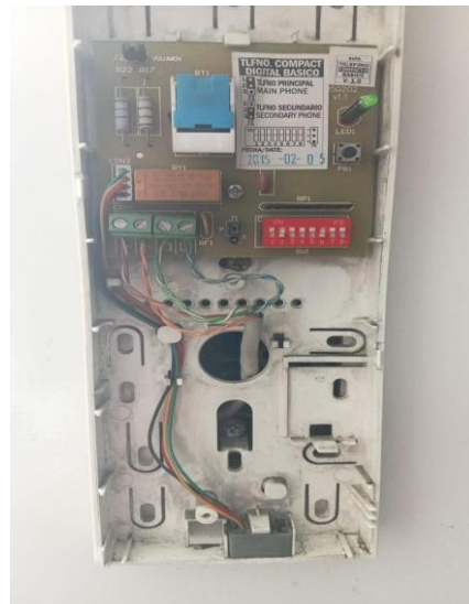
APARTAMENTO 503- TORRE B
