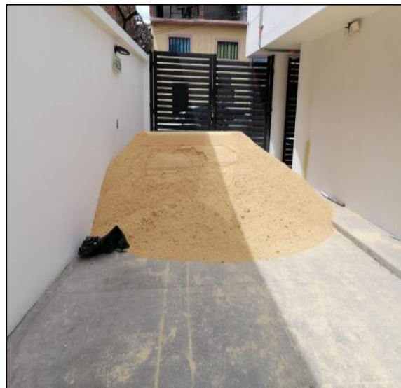
Arena Para Mortero De Re Nivelación Placas De Terrazas
