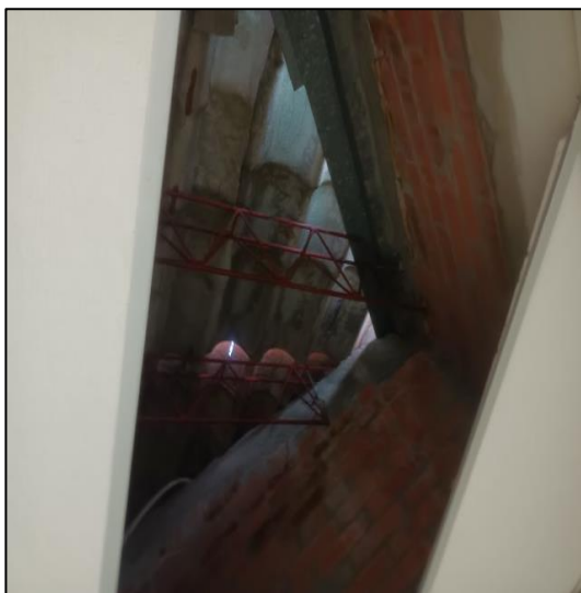
Cubierta En Teja Tipo Española, Cerchas En Varilla De 1/2"
