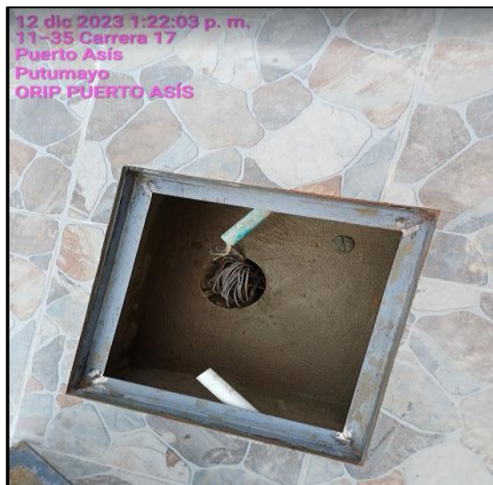
Adecuación Para instalación De Electrobomba De Aljibe
