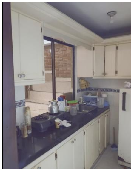
Cocineta, Muebles De Madera Mantenimiento General
