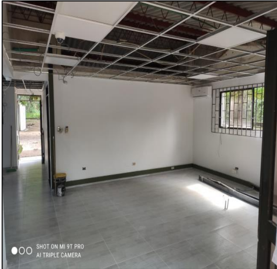
Instalación De Aires Acondicionados
