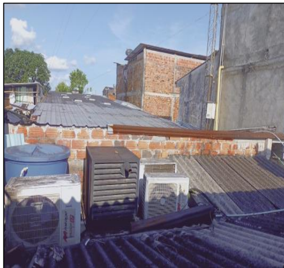
Cubierta Existente, Parte Interna Del Predio, Aires Acondicionados
