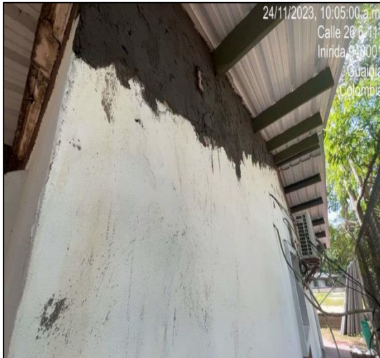
Pañete Sobre Muro Exterior
