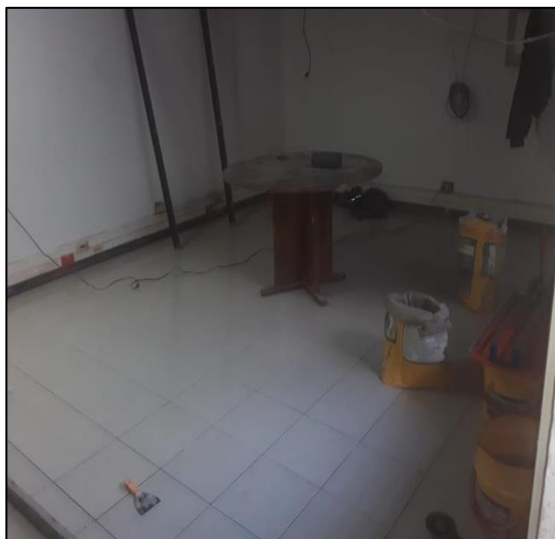
Instalación De Piso Área De Abogados
