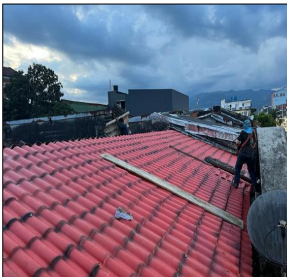
instalación De Cubierta
