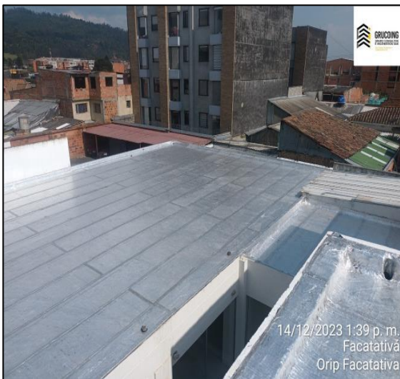
Aplicación De Manto Asfaltico
