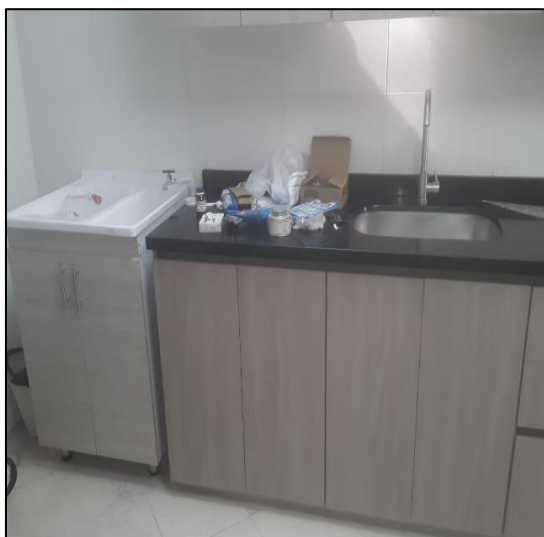
Instalación De Muebles De Cocina Y Lavadero
