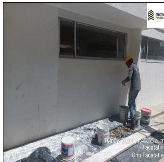
Aplicación De Graniplast En Acceso Vehicular - Fachada Interna
