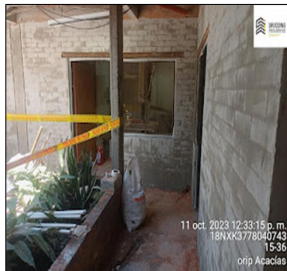
Revoque En Muros Mampostería En Ladrillo, Señalización
