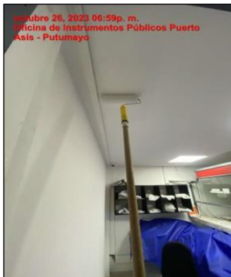
Aplicación De Pintura Interiores
