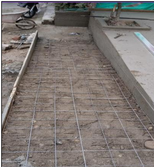
Instalación De Malla Electro Soldada Para Rampa
