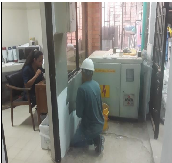
Ampliación De Estuco En Materas De Patio Central
