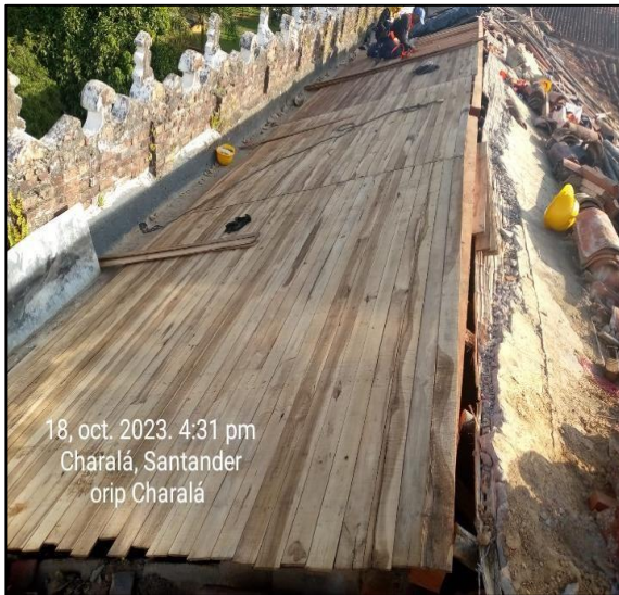
Cambio De Esterilla De Guadua Por Listón Machihembrado
