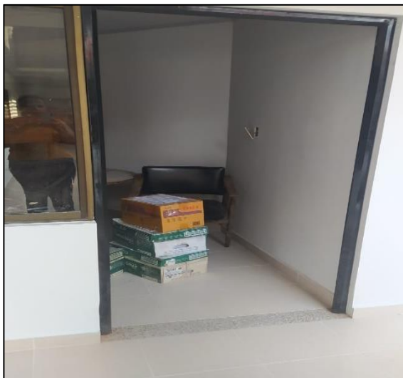
Instalación Marcos Para Puertas
