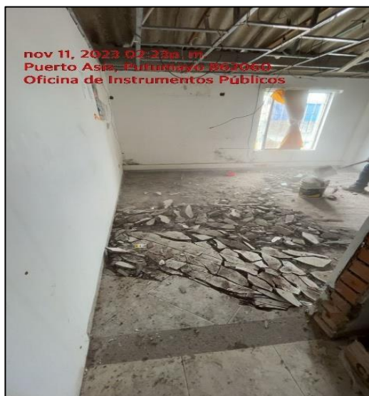
Demolición De Enchape En Oficina Registrador
