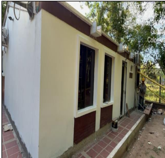
Aplicación De Ultima Mano De Pintura Exterior
