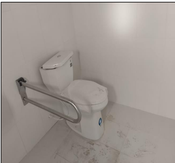
Instalación Soporte Baño Para Discapacitados.
