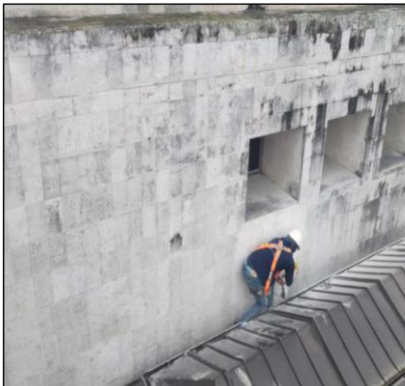
Limpieza De Fachada
