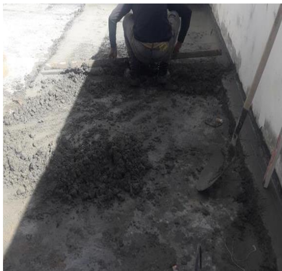
Alistamiento De Pisos Con Mortero
