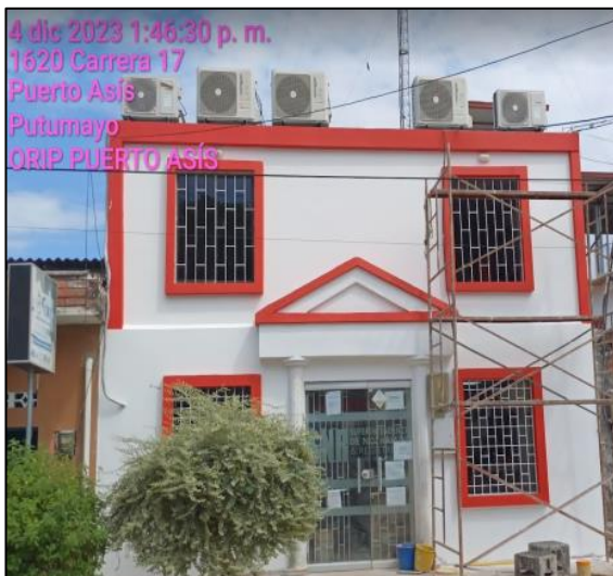
Pintura En Fachada Principal
