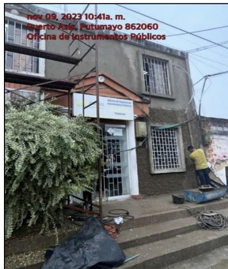
Pañete Fachada Principal
