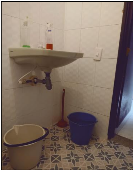
Baño 1er Piso, Baño Atención Al Publico
