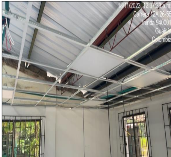
Desmante De Canal Para Red De Voz Y Datos
