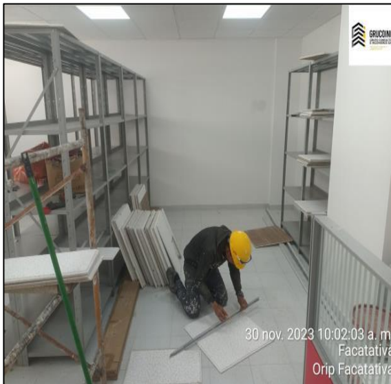
Preparación De Láminas Para Instalación De Cielo Raso En Fibra Mineral
