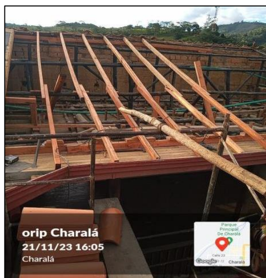
Estructura De Cubierta En Madera
