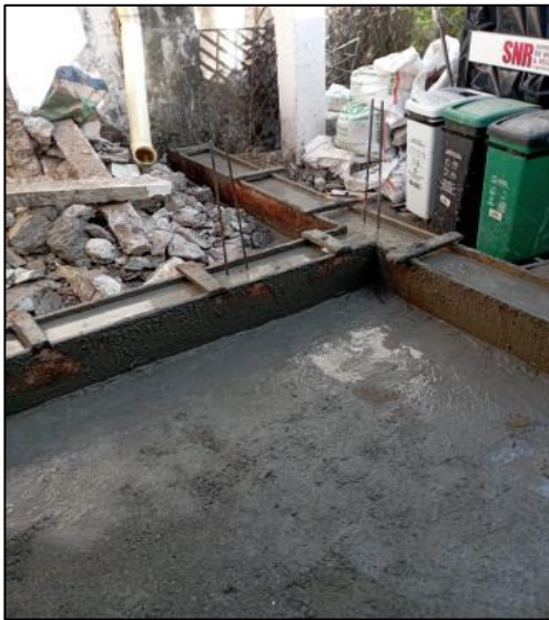
Fundida De Vigas Para Cimentación
