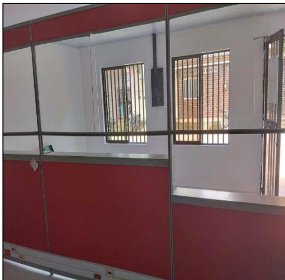
Cerramiento Para Control De Polvo Debido A Las Obras
