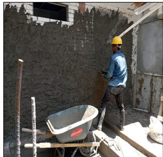
Pañete - Frisado De Muros
