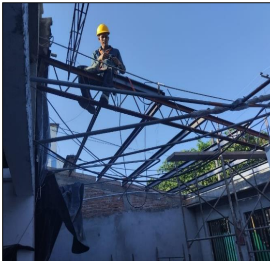
Desmonte De Cubierta
