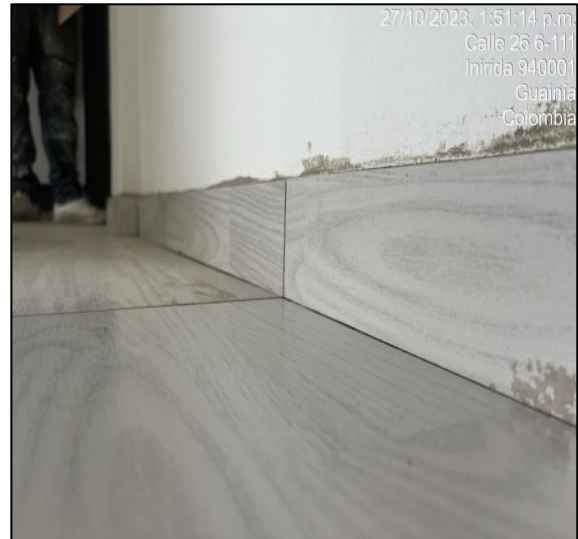
Instalación De Guarda Escobas
