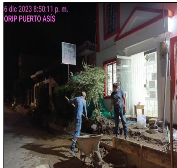
Proceso De Armado Rampa De Acceso - Acceso Principal
