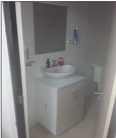
Instalación De Mueble Baño
