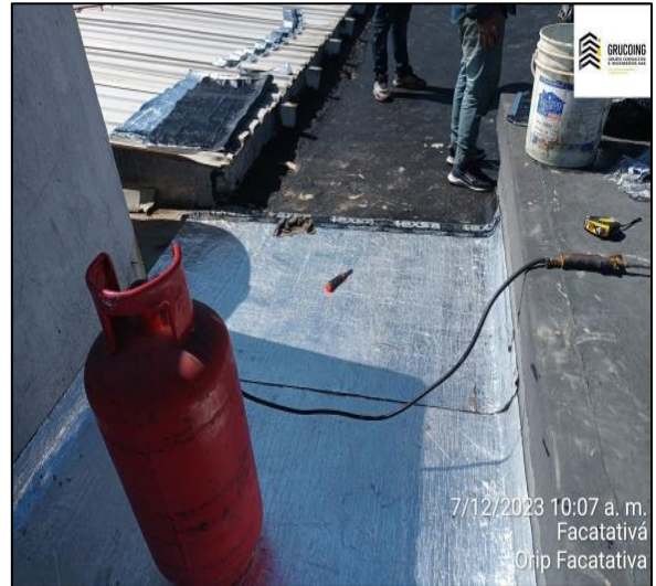
Instalación De Manto Asfaltico
