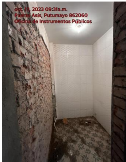
Demolición De Enchape En Baño Auxiliar 1er Piso
