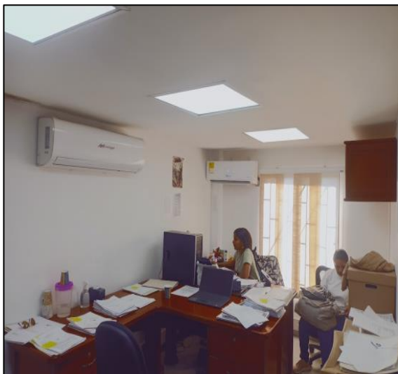
Oficina Administrativa 2do Piso, Muros Pañetes Y Pintura Vinilo, Cielo Raso En Drywall
