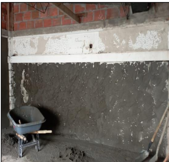
Pañete - Frisado De Muros
