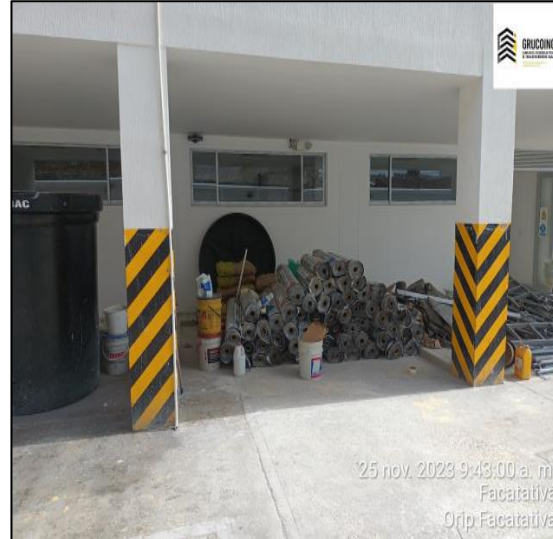
Techo En Zona De Parqueo Con 2da Mano De Pintura, Material De Manto Para Aplicación En Terrazas
