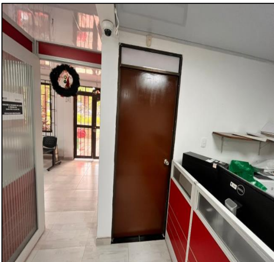
Pintura Y Montaje De Marco Puerta Oficina Registrador
