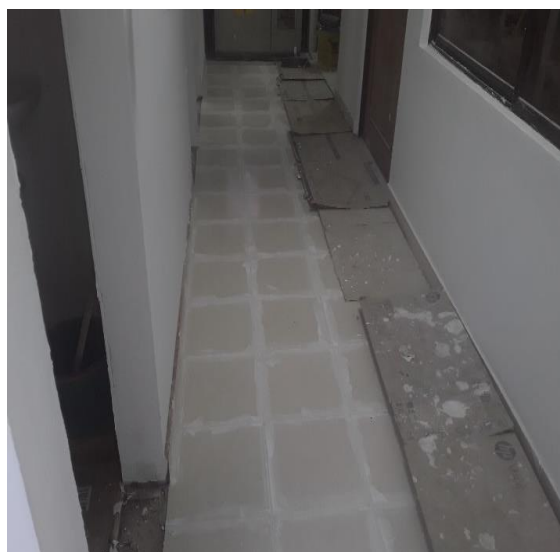
Instalación De Baldosín Y Emboquillado
