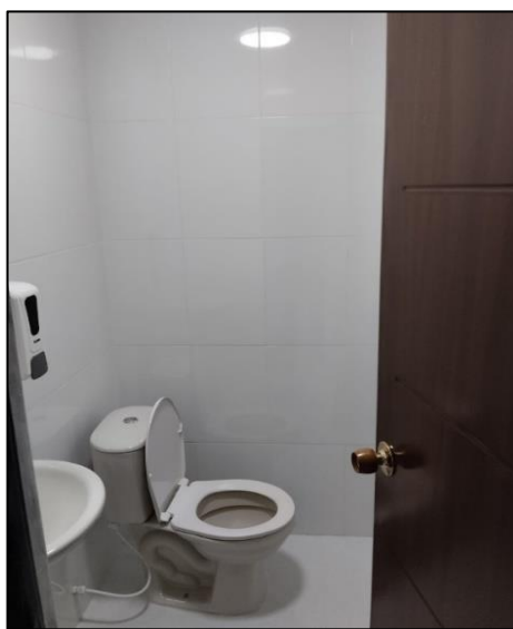
instalación De Puerta De Baño
