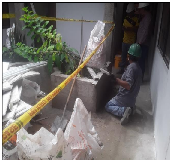
Aplicación De Estuco Sobre Muros En Hall
