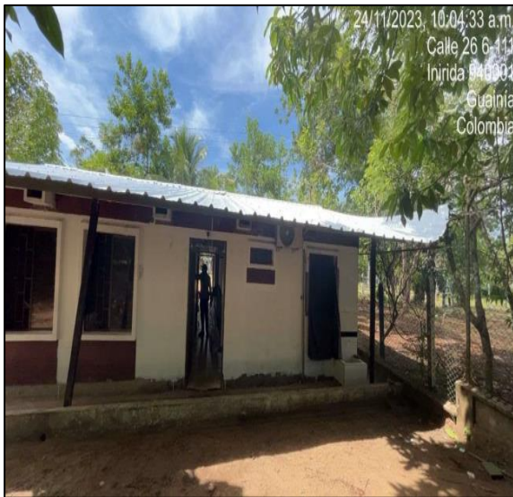
Instalación De Cubierta
