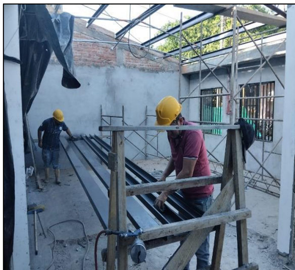
Instalación Perfilería Cubierta
