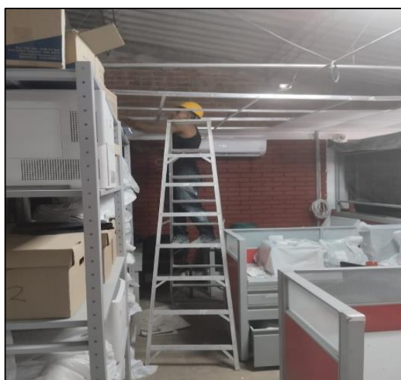
Desmonte De Cielo Raso
