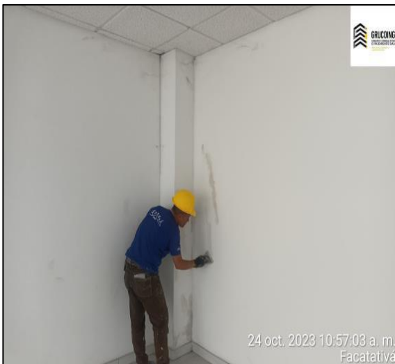
Raspado Y Sellado De Fisuras Con Estuco Plástico En Muros
