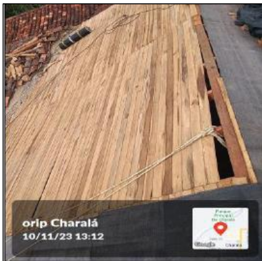
Estructura En Madera Para Teja En Barro
