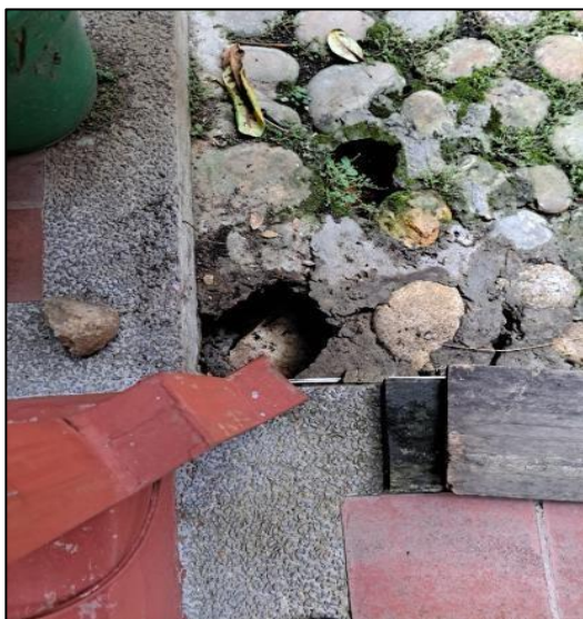
Bajantes Existentes A Patio
