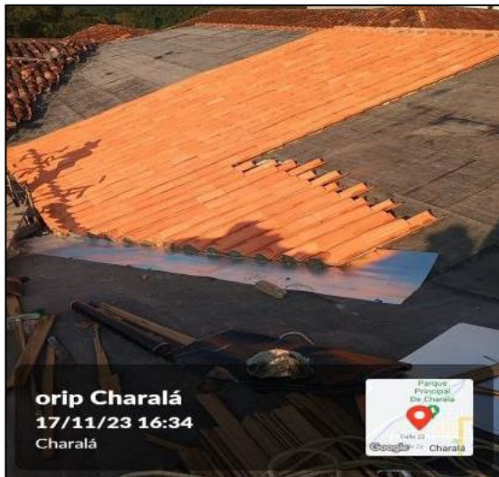
instalación De Teja De Barro
