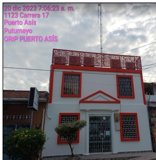
Instalación De Lámina Micro Perforada En Parte Superior De La Fachada Principal.
