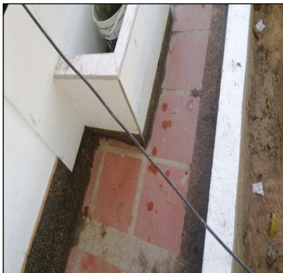
Pintura Exterior Y Media Cañas
