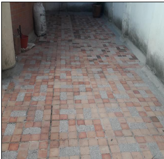
Limpieza De Piso En Cafetería
