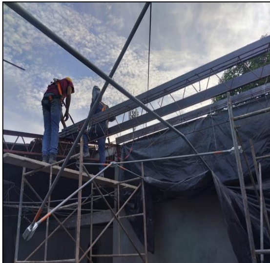
Instalación De Perfilería Para Cubierta
