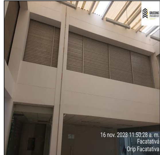
Aplicación De 2da Mano Pintura En Muros, Vacío Zona De Atención Al Publico
