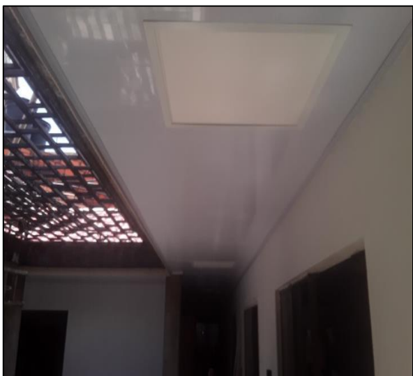
Instalación De Cielo Raso Y Iluminarias
