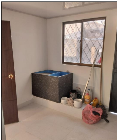
instalación De Lavadero Prefabricado
