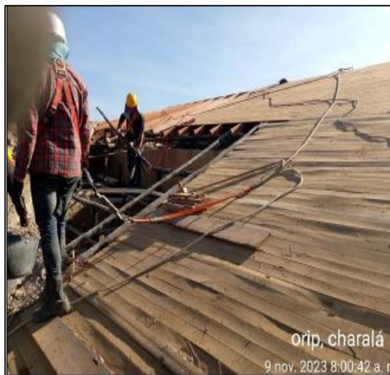
Estructura En Madera Para Teja En Barro
