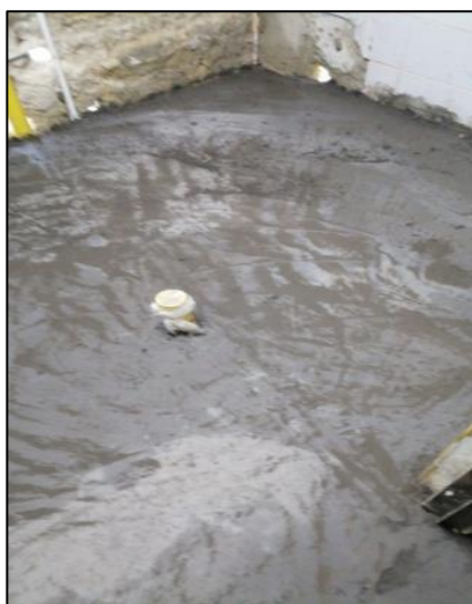
Alistado Piso Cocina
