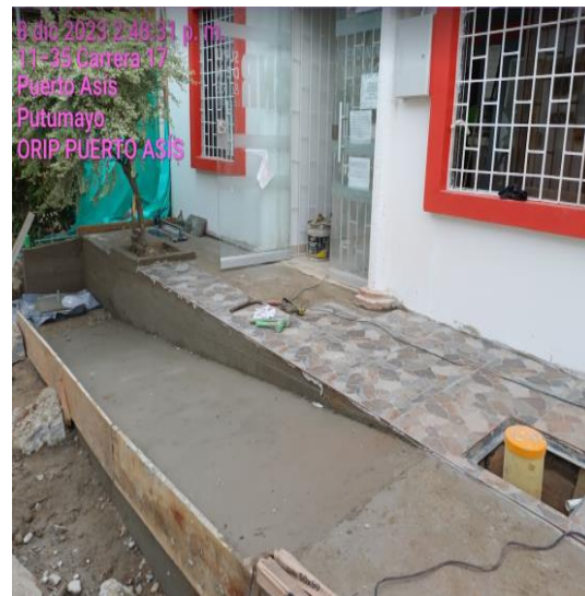
Fundida De Rampa En Concreto
