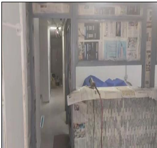
Resane Muros Con Estuco Plástico
