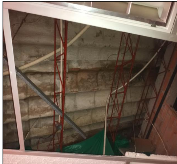
Cubierta Tipo Española, Cercha Metálica
