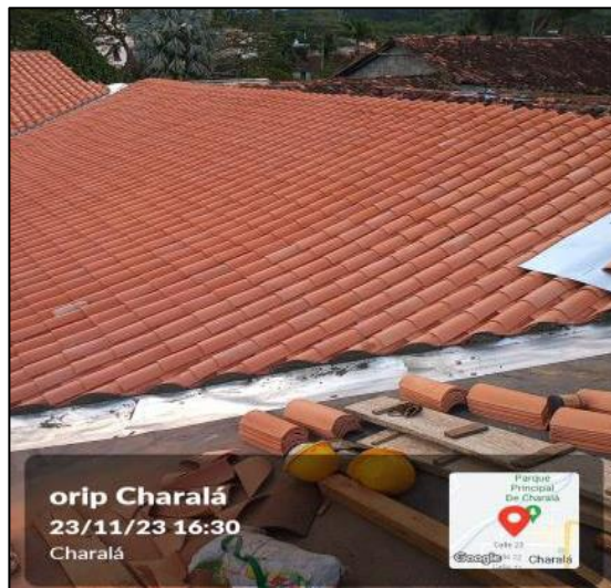
Instalación De Teja De Barro
