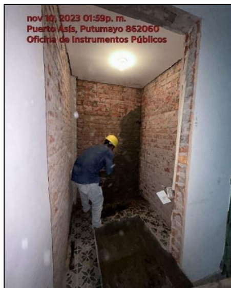
Demolición De Enchape Para Baño Discapacitado
