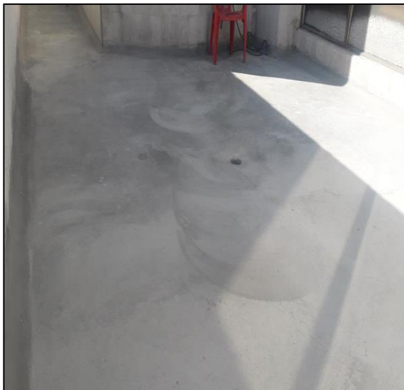
Finalización De Piso En Terraza
