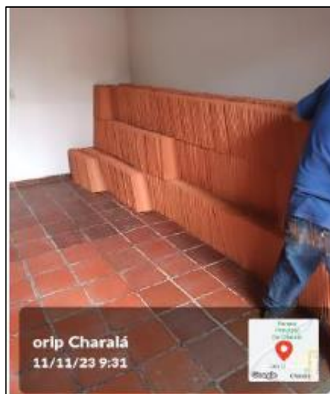
Acopio De Material – Teja De Barro
