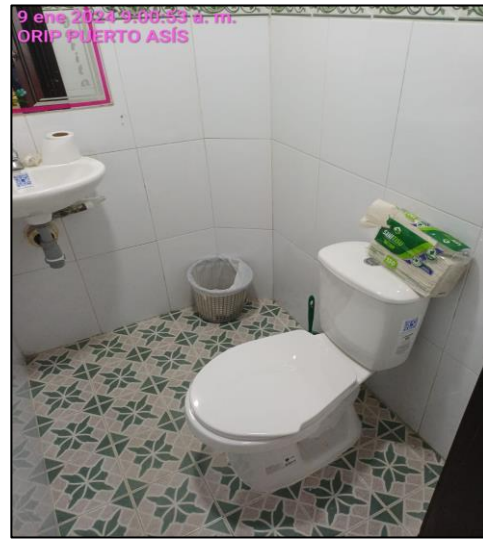
Revisión De Aparatos Sanitarios, Baño 1er Piso Auxiliar
