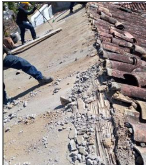
Demolición De Alistado En Esterilla De Guadua
