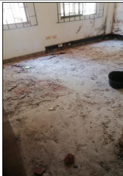
Demolición De Piso En Oficina Registrador
