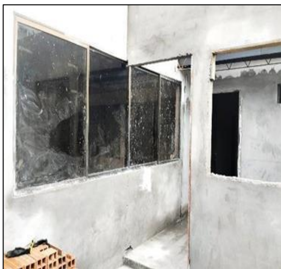
Pañetes Muros Exterior Baño Discapacitado
