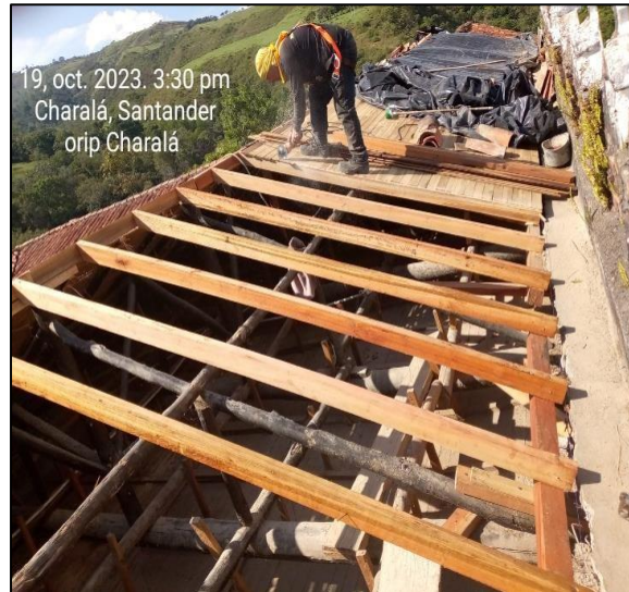
Estructura En Madera Para Teja De Barro Natural
