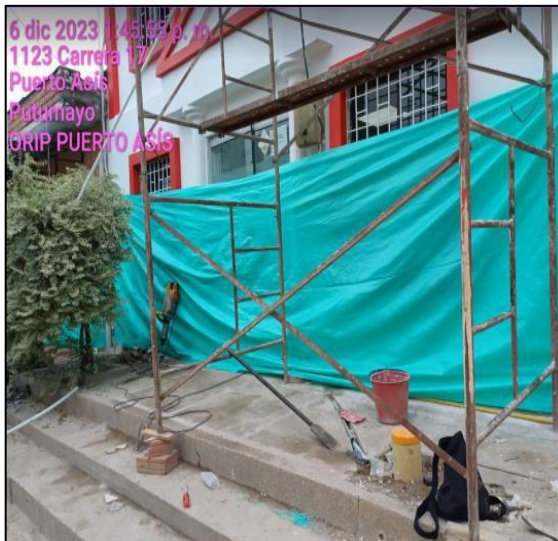
Instalación De Poli Sombra Verde - Acceso Principal
