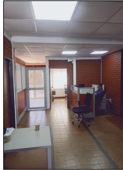
Cielo Raso Área Hall, Principal, Pisos En Tableta Y Muros En Ladrillo A La Vista Pintados En Vinilo
