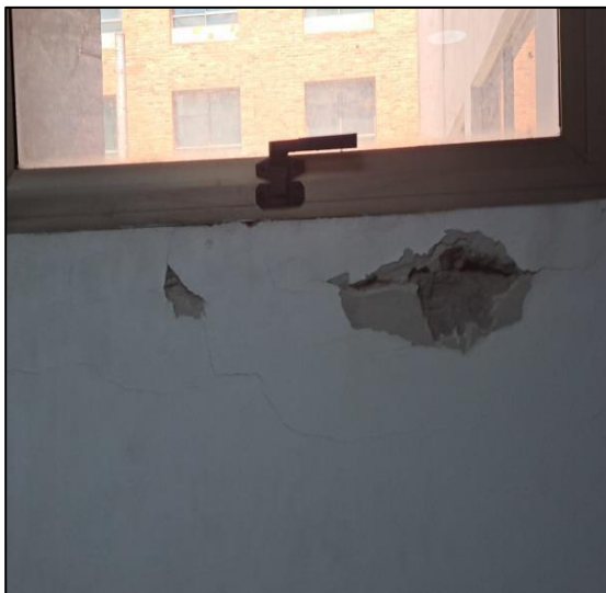
Resanes De Muros
