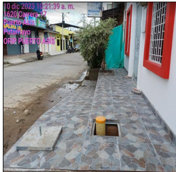
instalación De Enchape Piso Anden Y Rampa
