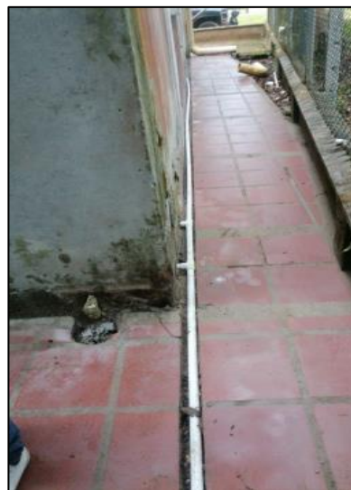
Regata Para Instalación De Tubería Hidráulica
