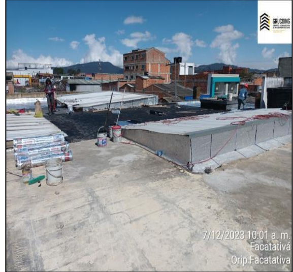
Re Nivelación Placa De Terraza Con Mortero
