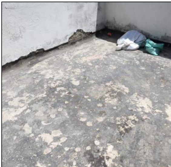
Demolición De Pisos En Cubiertas
