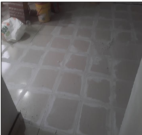
Instalación De Baldosín Y Emboquillado
