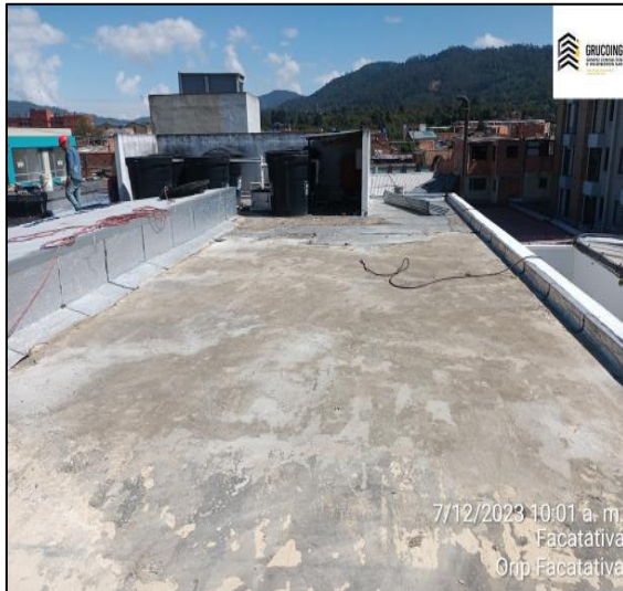
Re Nivelación Placa De Terraza Con Mortero
