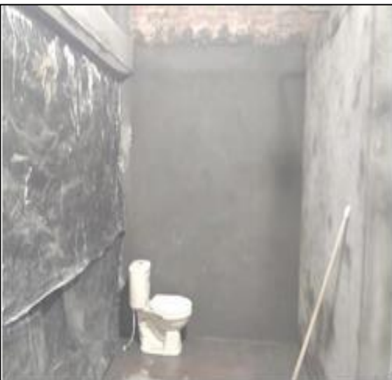
Cerramiento Para Control De Polvo Debido A Las Obras
