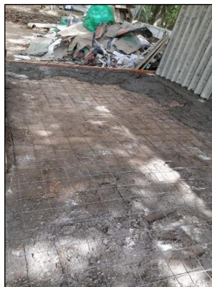
Instalación Malla Para Placa De Contrapiso Parqueadero
