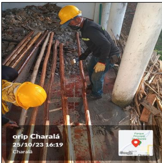
Inmunización Estructura En Madera Para Teja De Barro Natural
