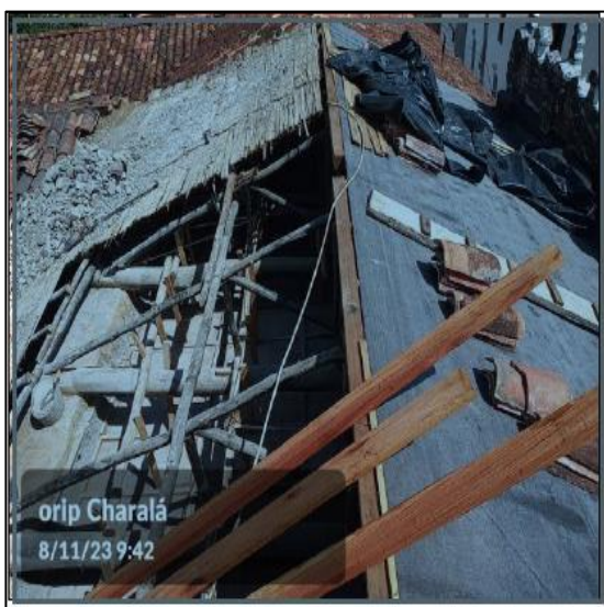
Desmante De Cubierta En Teja De Barro
