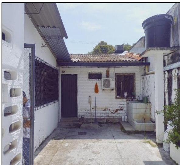
Patio Interno, Muros Pintados En Vinilo, Cubierta General En Asbesto Cemento
