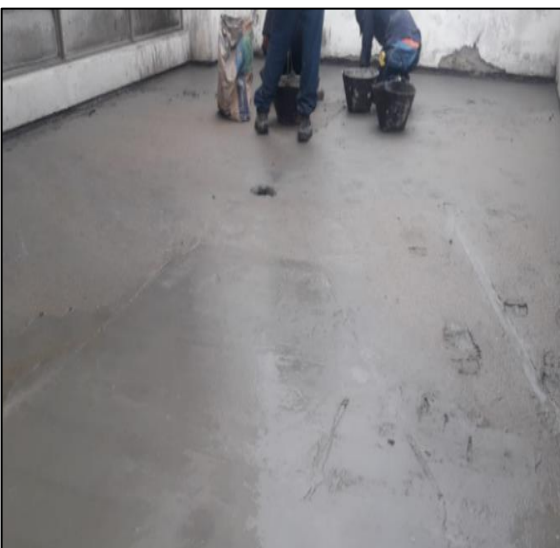
Mortero De Nivelación Terraza
