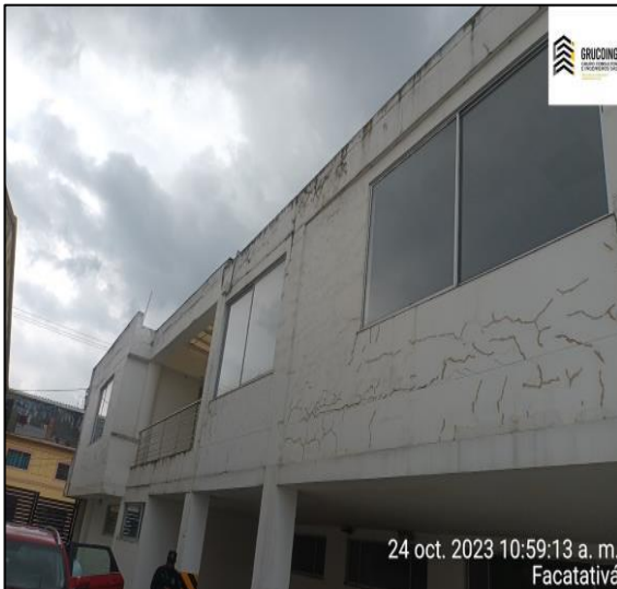
Limpieza De Brosas En Fachada, Raspado Y Limpieza De Fisuras
