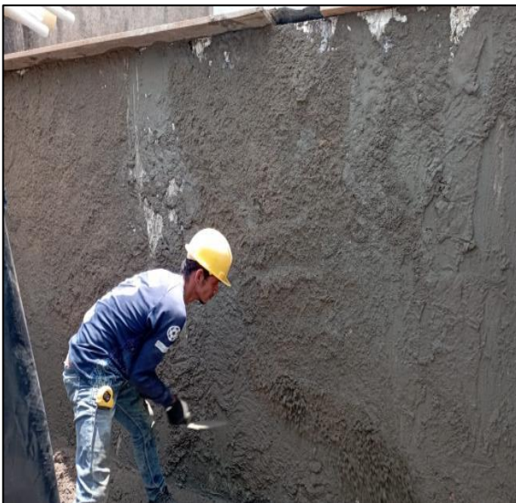
Pañete Impermeabilizado En Patio
