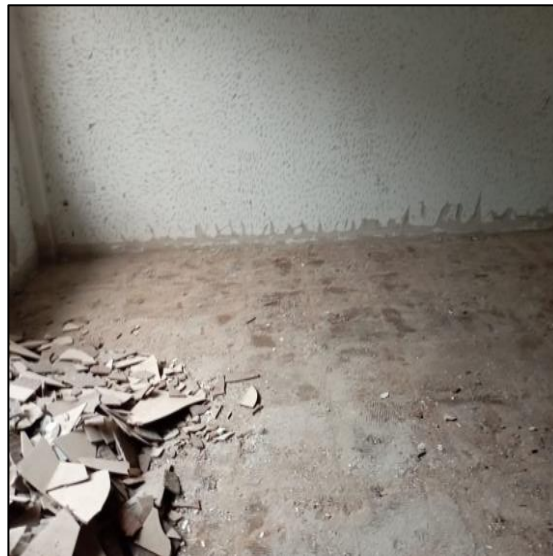
Picado De Muros Y Pisos
