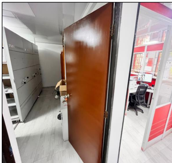
Mantenimiento Puerta De Acceso A Archivo Rodante
