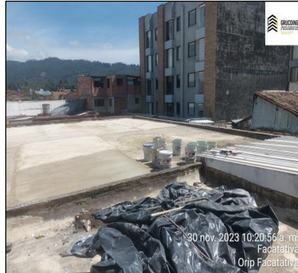
Re Nivelación Placa De Terraza Con Mortero
