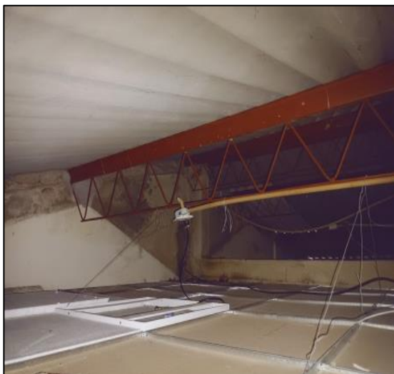
Cubierta General En Asbesto Cemento, Cerchas Metálicas En Varilla De 1/2" Y Perfilería De 8 X 4
