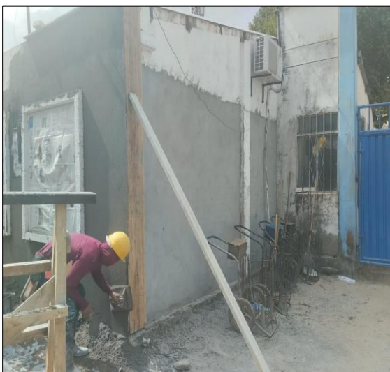
Pañete Impermeabilizado De Culata Y Parte Del Parqueadero De Aguas Del Caguán
