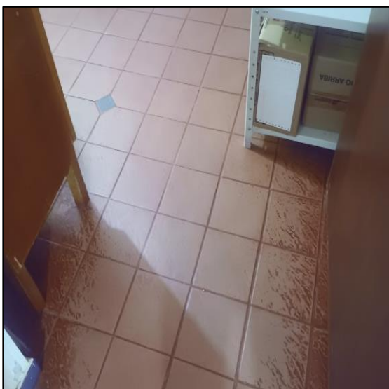
Piso En Enchape De 15 X 15 Cms, Cubierto Con Cera Emulsión
