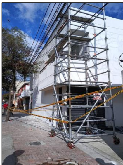
Aplicación De Pintura En Graniplats En Fachada Exterior
