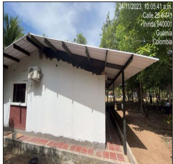
Instalación De Cubierta
