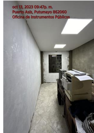
Estuco Oficina Administrativa #1
