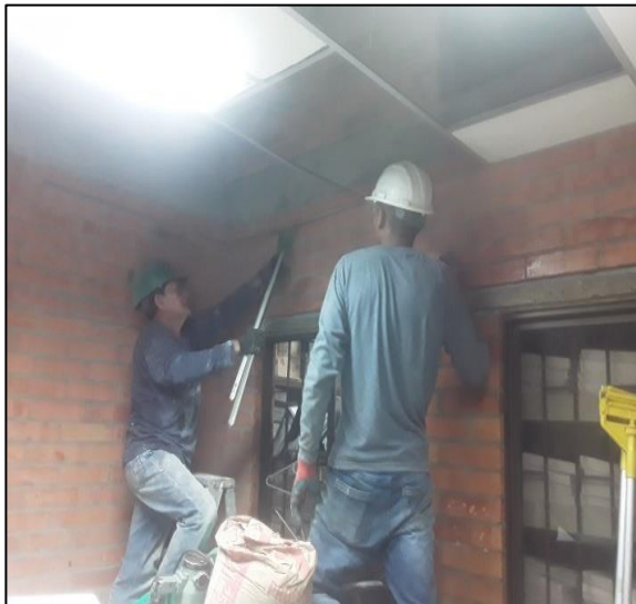
Desmonte De Cielo Raso En Área De Archivo
