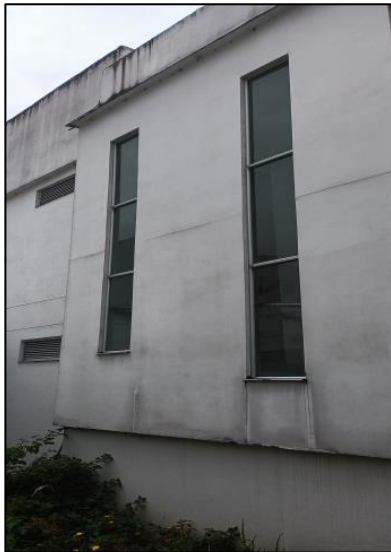
Fachada Interna En Superboard
