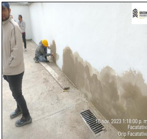
Resane De Muro Interno En Área De Parqueadero Interno
