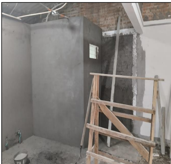
Primera Mano De Estuco En Patio Y Baños.
