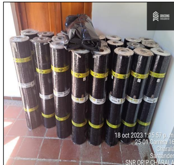
Manto De Asfaltico
