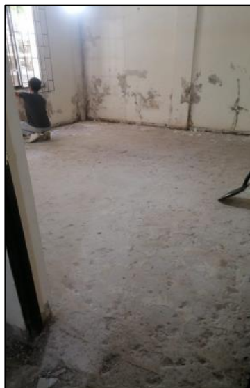
Demolición De Piso En Oficina Registrador
