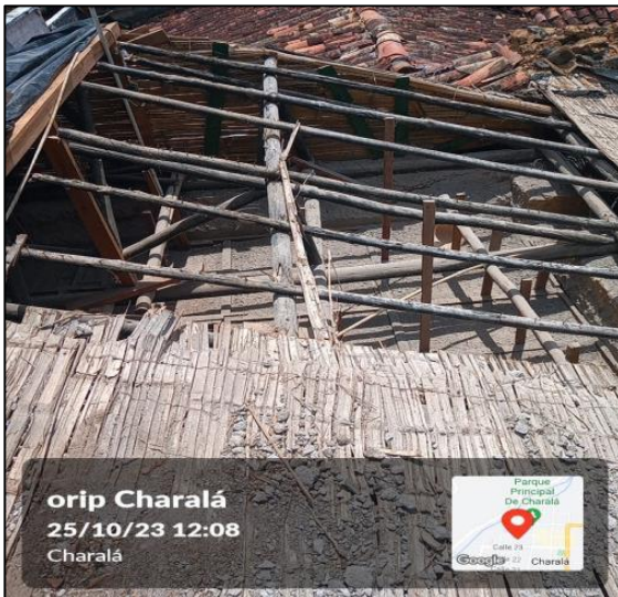
Desmante De Cubierta En Teja De Barro
