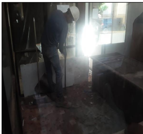
Demolición Y Nivelación De Piso
