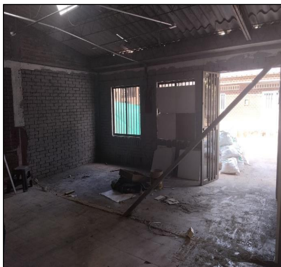
Desmonte De Oficina Abierta
