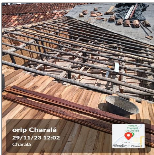
Esterilla En Machimbre Bajo Entramado
