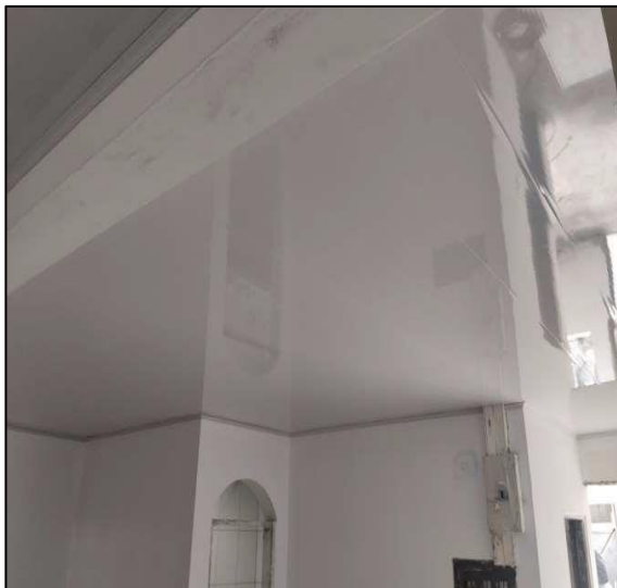
Instalación Cielo Raso Zona De Abogados
