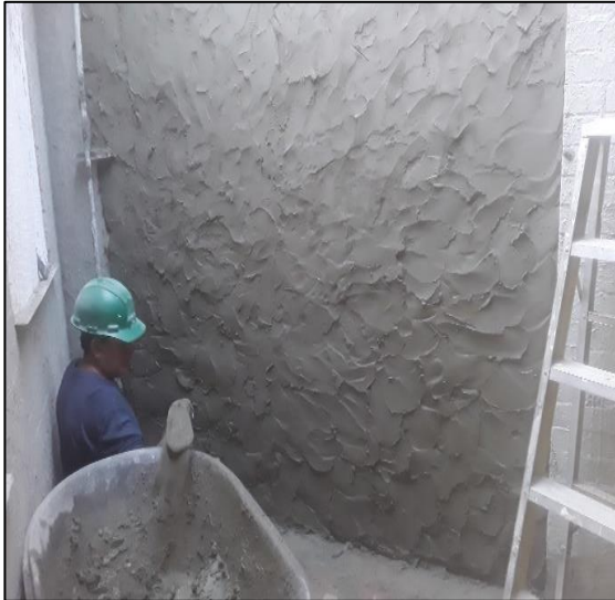
Pañete En Muro Área Administrativa
