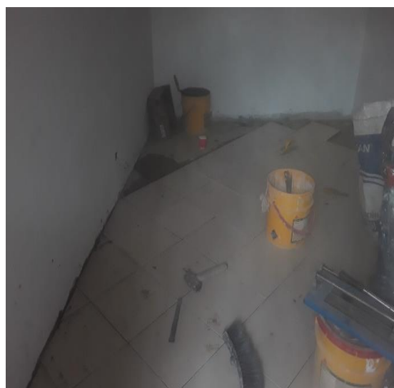
Instalación De Piso En Área De Bodega
