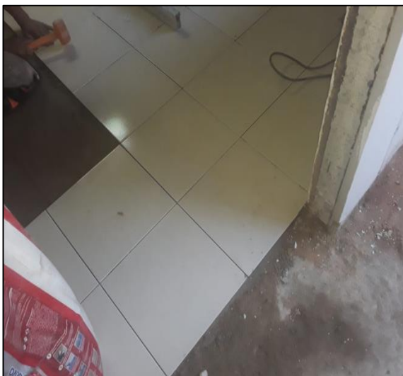
Instalación De Baldosín
