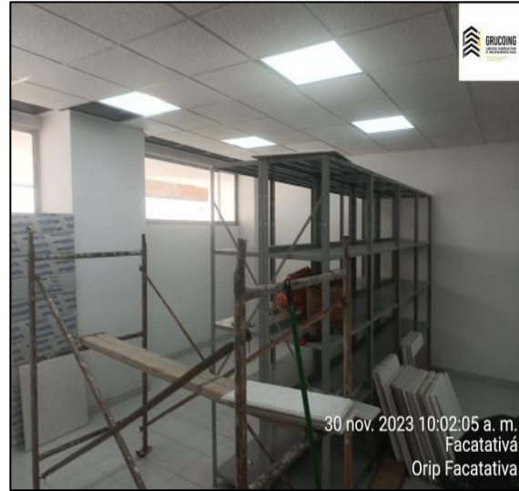
Instalación De Cielo Raso En Área De Archivo Fijo
