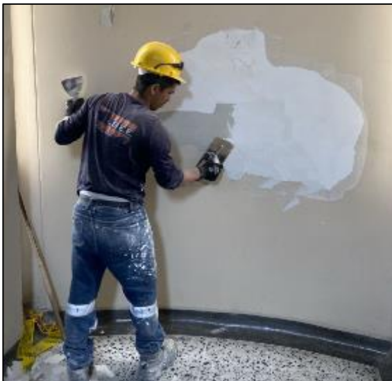
Resane Muros Con Estuco Plástico
