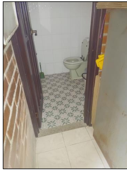
Baño 1er Piso, Baño Atención Al Publico
