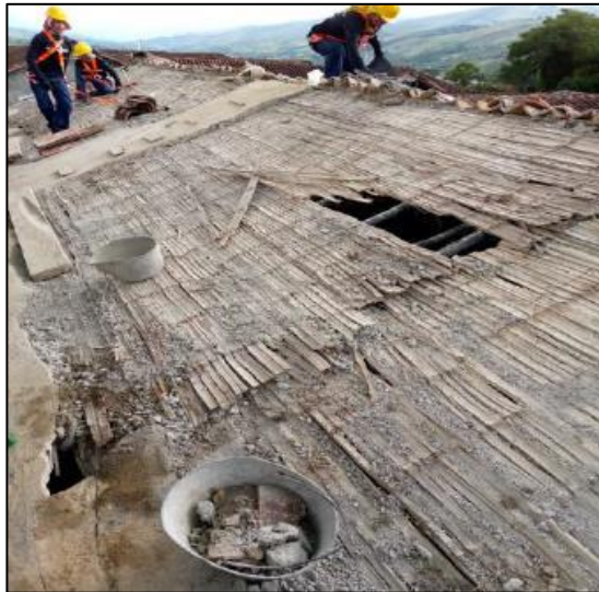
Demolición De Alistado En Esterilla De Guadua
