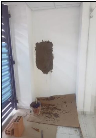
Colocación De Pañete En Nicho Donde Se Encontraban Contadores Eléctricos
