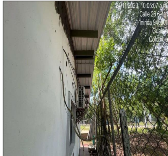
Instalación De Cubierta
