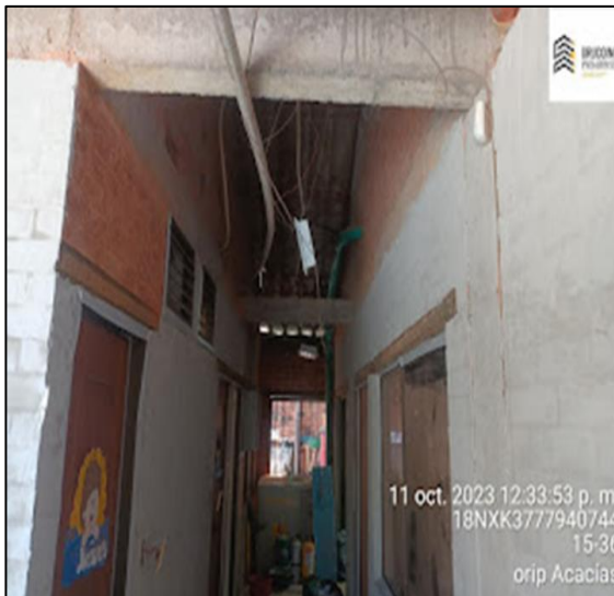
Desmonte De Cielo Raso Y Estructura En Circulación, Revoque De Muros
