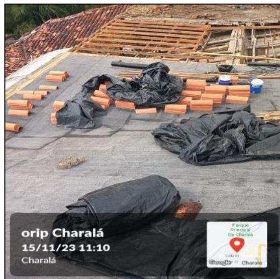
Estructura De Cubierta En Madera
