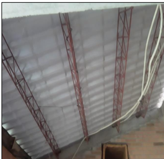
Instalación De Cubierta
