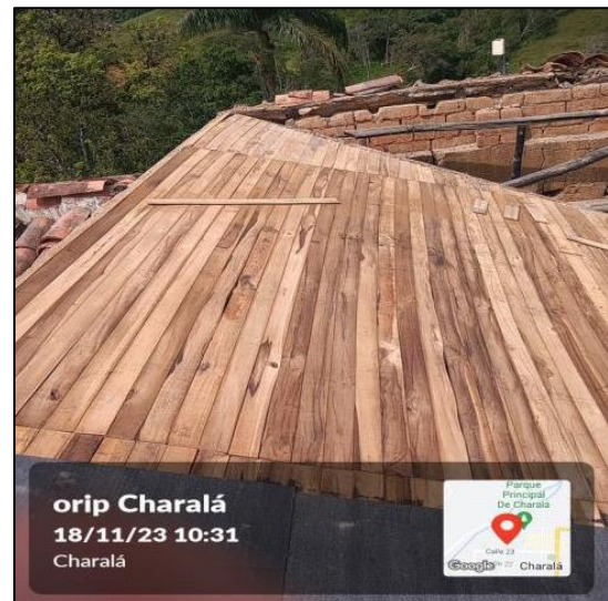
Esterilla En Machimbre Bajo Entramado
