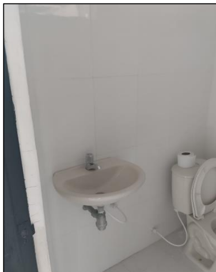
Instalación Aparatos Sanitarios
