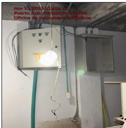
Desinstalación De Caja De Breakers Vieja E Instalación De Caja Nueva
