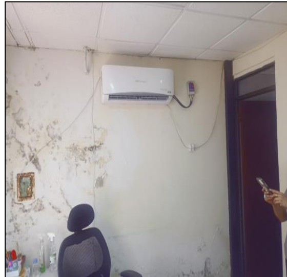
Muro Con Humedad - Oficina De Registrador
