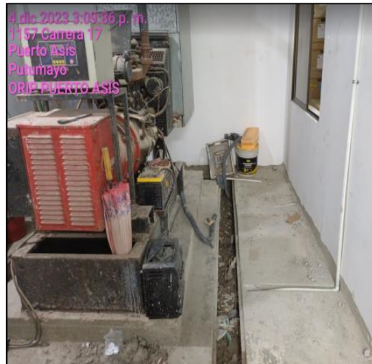
Retiro De Material Sobrante En Cuarto De Planta Eléctrica
