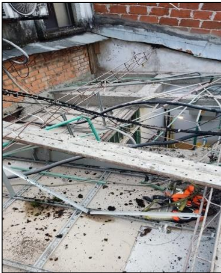
Desmonte De Cubierta 1er Piso
