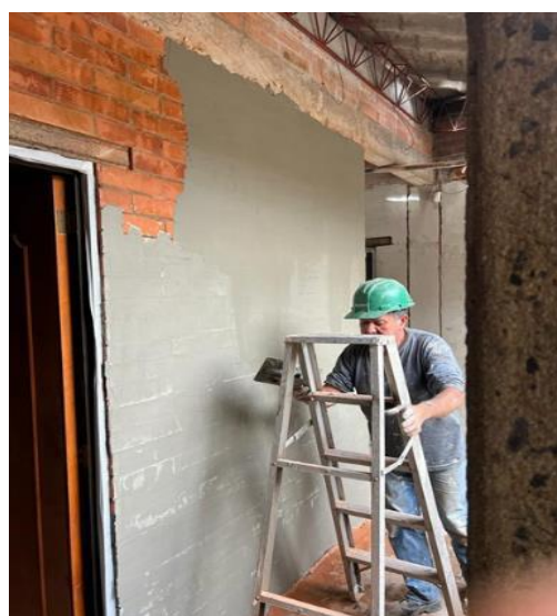
Aplicación De Revoque En Muros
