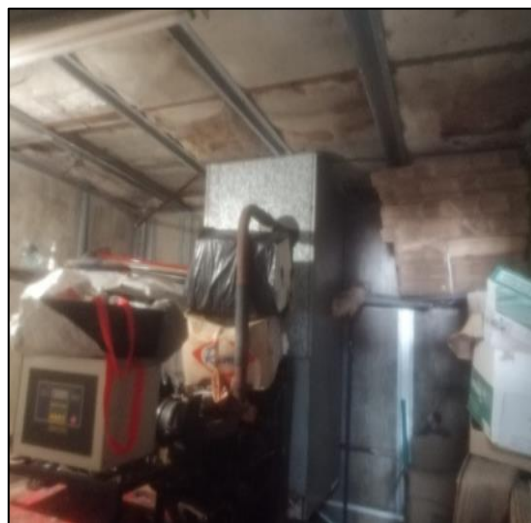
Desmante De Paneles De Cielo Raso En Cuarto De Planta Eléctrica
