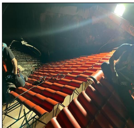
instalación De Cubierta
