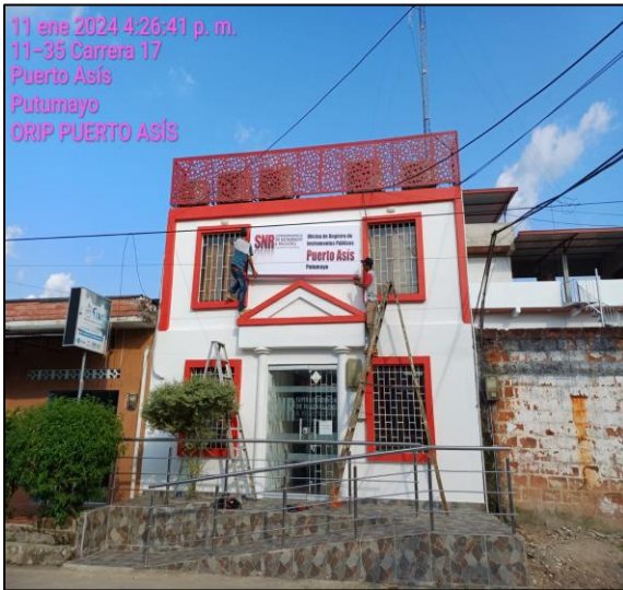
Instalación Aviso De Registro Y Notariado
