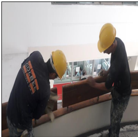
Limpieza De Pasamanos En Madera
