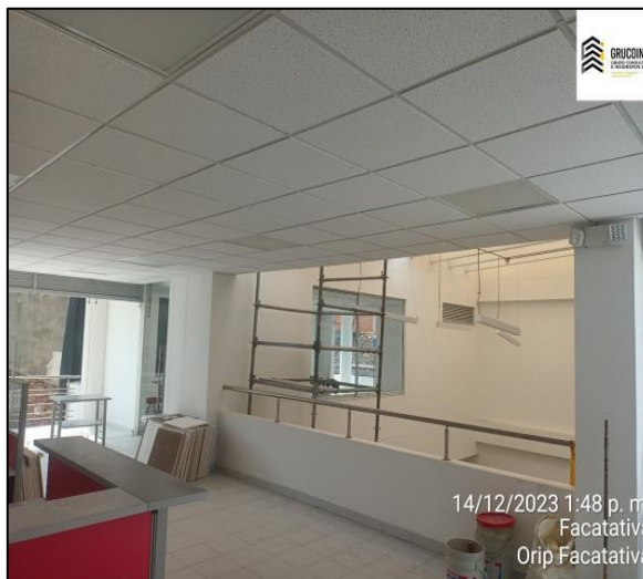
Finalización De Instalación Cielo Raso En 2do Piso
