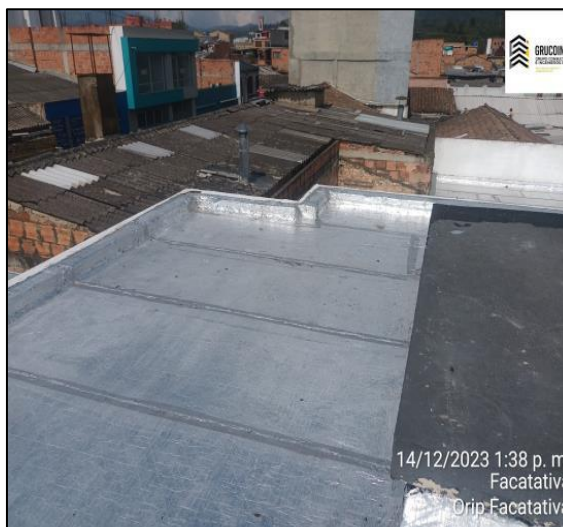
Aplicación De Manto Asfaltico
