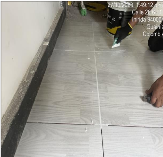
Instalación De Cerámica Para Pisos
