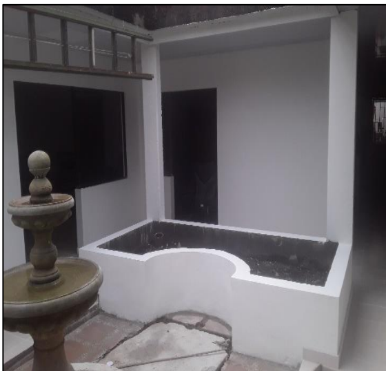
Terminados Área Central De Oficina
