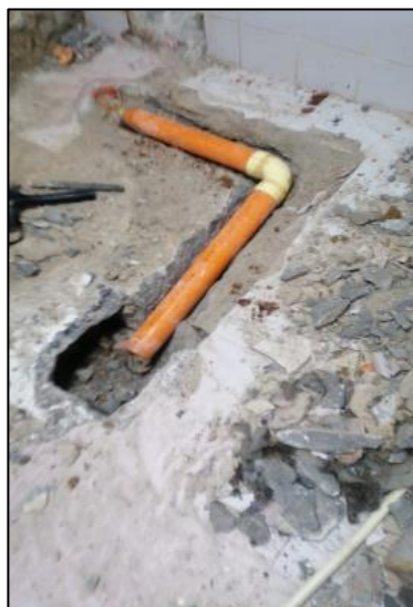
Excavación E Instalación De Tubería Sifón
