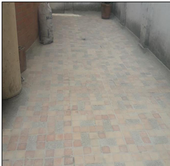
Limpieza De Piso En Cafetería
