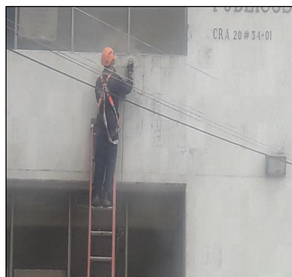
Limpieza De Fachada
