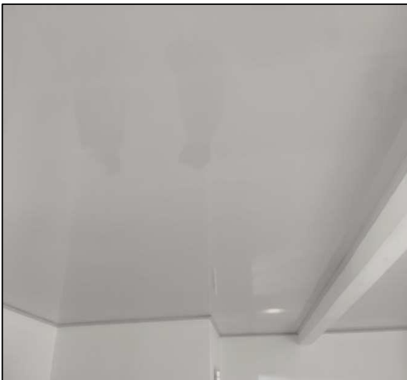
Instalación Cielo Raso Zona De Abogados
