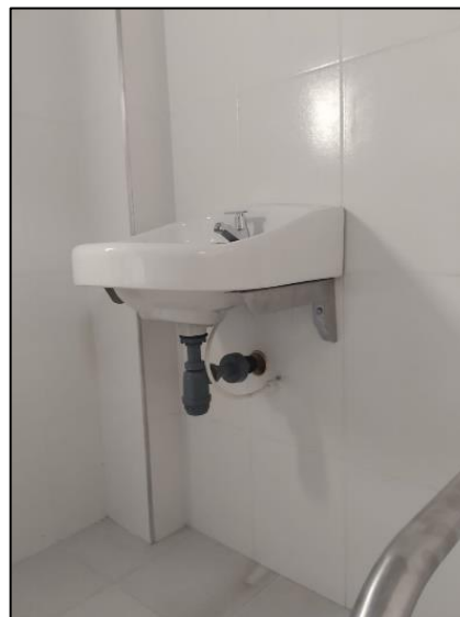
Instalación Enchapes Y Lavamanos Baño Discapacitado
