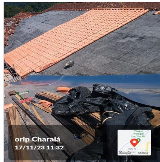
Instalación De Teja En Barro
