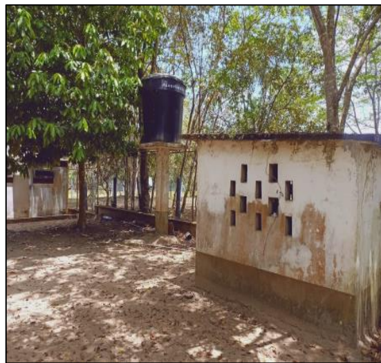
Cuarto Para Planta Eléctrica Y Ménsula Para Tanque Elevado
