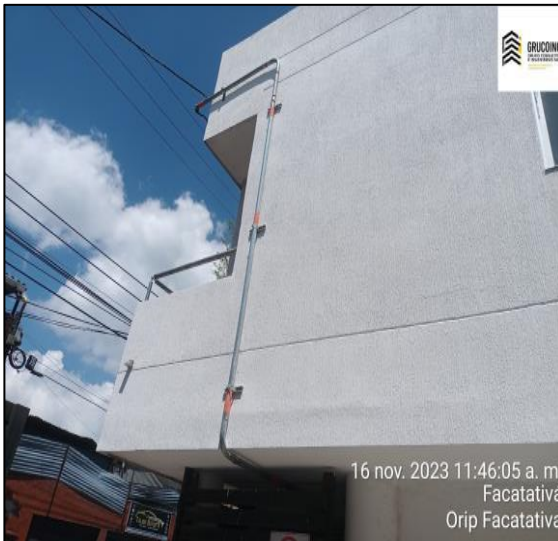
Graniplast Aplicado Fachada Externa
