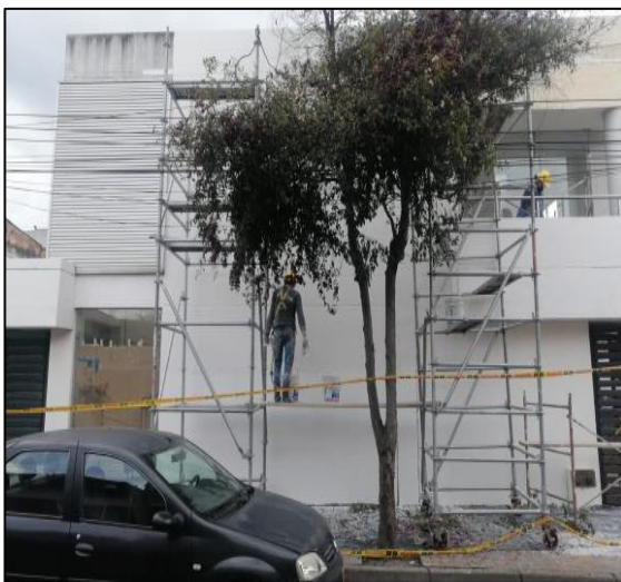
Aplicación De Graniplast En Fachada Exterior
