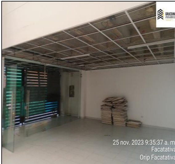
Desmante De Cielo Raso Y Re Nivelación De Estructura
