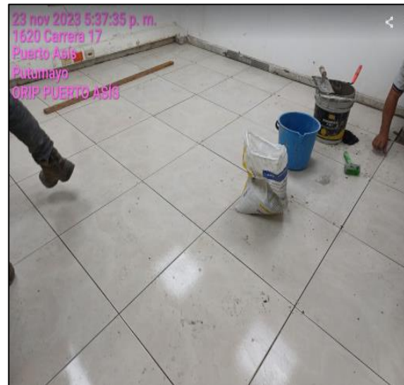
Apertura Para Adecuación De Aljibe
