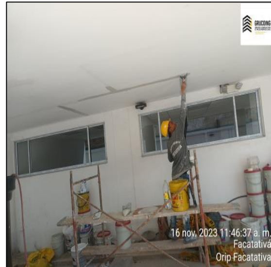
Sellado Y Masillado De Fisuras Y Dilataciones En Cielo Raso. Zona Parqueos
