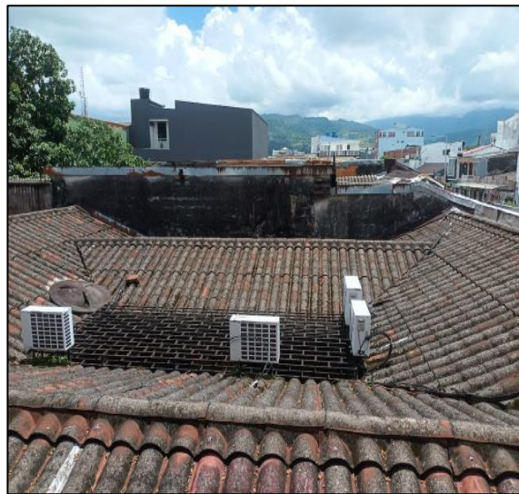
Cubierta Tipo Española Existente, Cerramiento En Reja Tipo Banco - Patio Central
