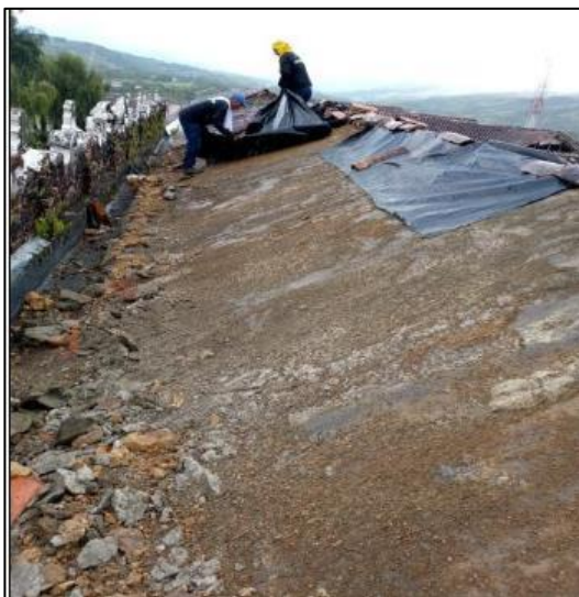
Instalación De Plástico Para Protección De Lluvias
