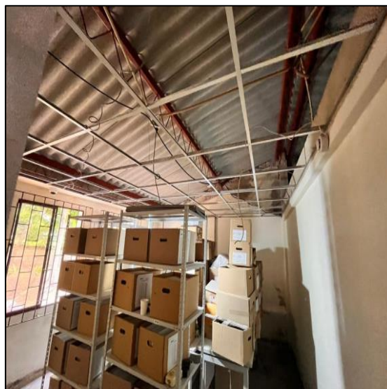
Desmonte De Cielo Raso
