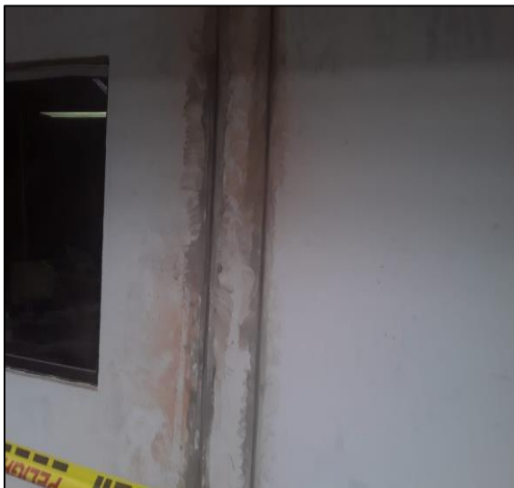
Aplicación De Yeso En Dilataciones De Estructura Contra Mampostería
