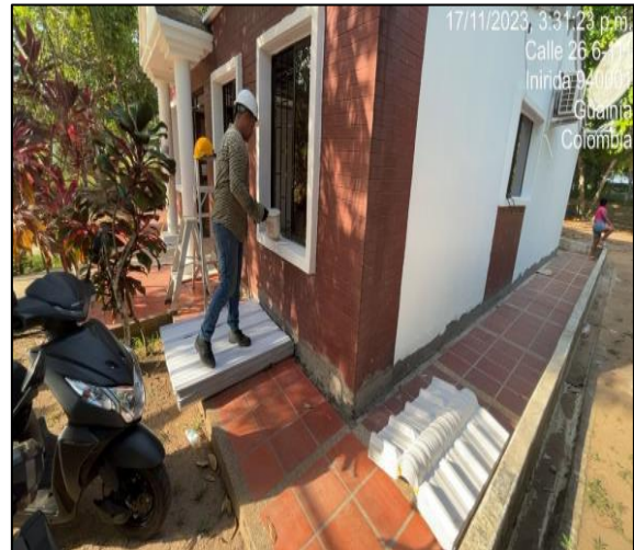
Aplicación De Ultima Mano De Pintura Exterior
