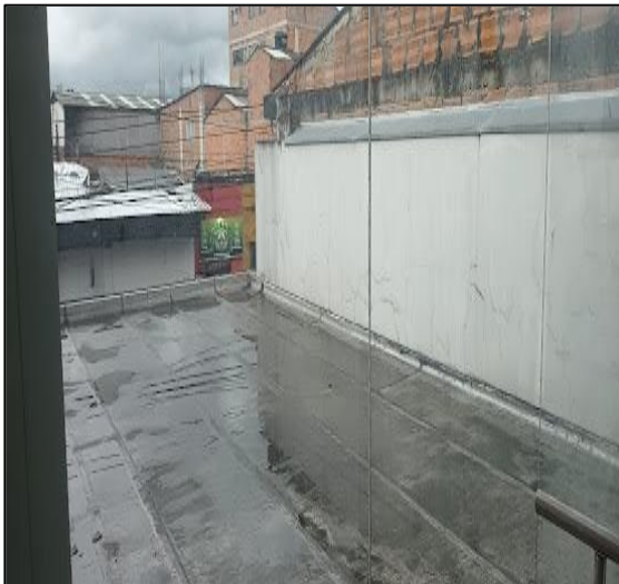
Manto Impermeabilizante Sobre Placa A Primer Piso
