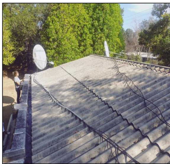
Cubierta En Asbesto Cemento, Cableado Eléctrico Y Satelital Sobre Cubierta
