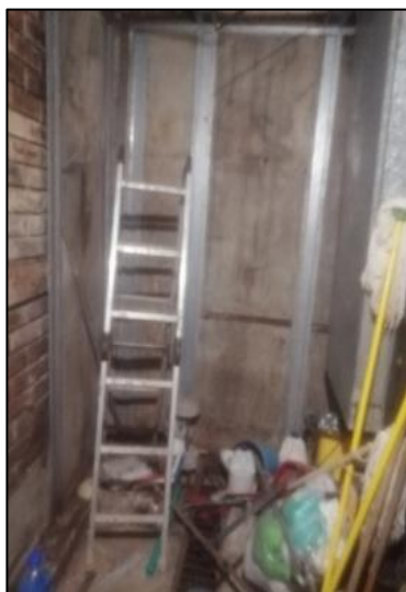
Limpieza De Cuarto De Planta Eléctrica
