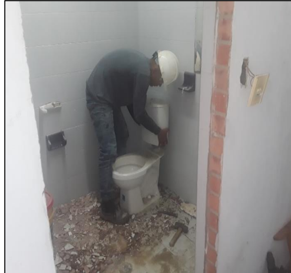
Desmonte De Aparatos Sanitarios En Baño Auxiliar
