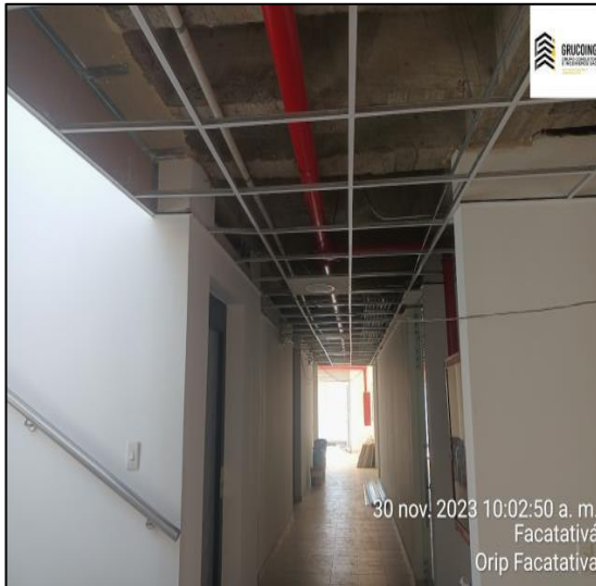
Desmonte De Cielo Raso Hall.
