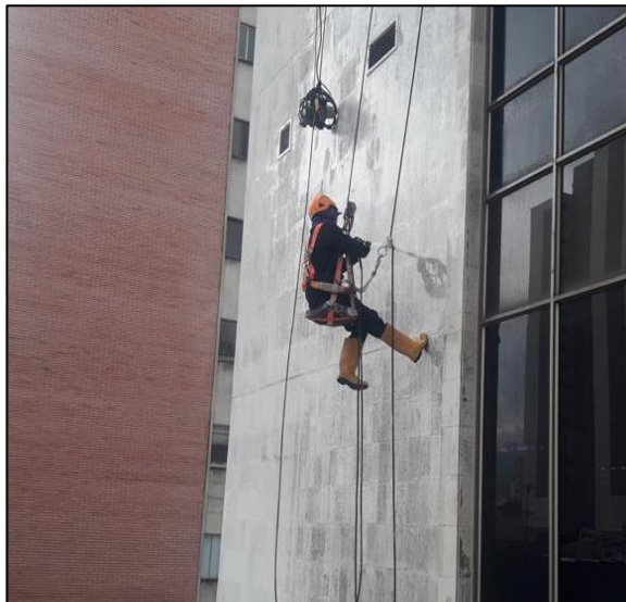
Limpieza De Fachadas
