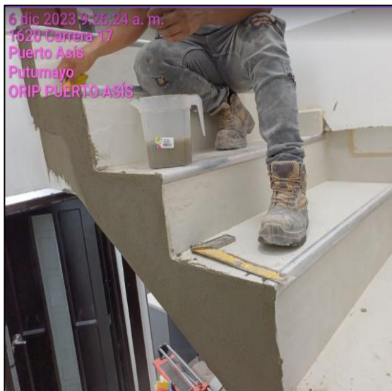
Instalación De Enchape Escalera
