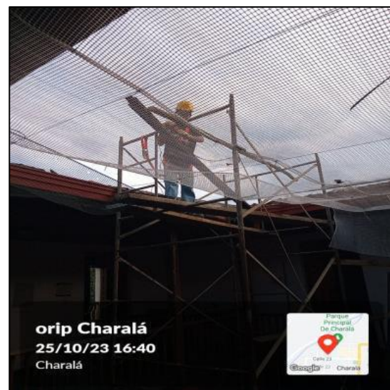
Protección De Mobiliario Durante La Obra
