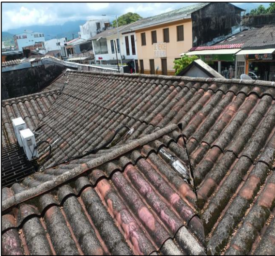
Cubierta Existente – Teja Tipo Española
