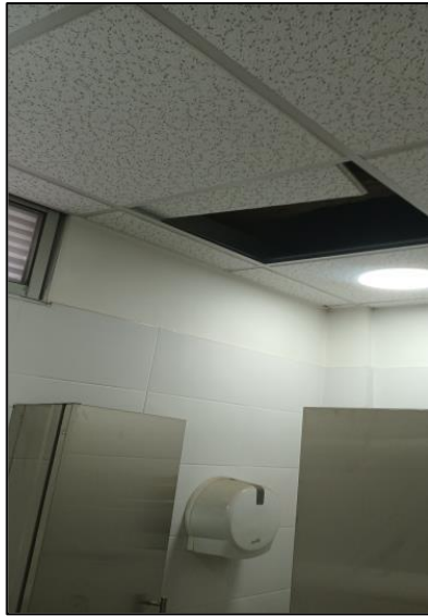
Área De Baños
