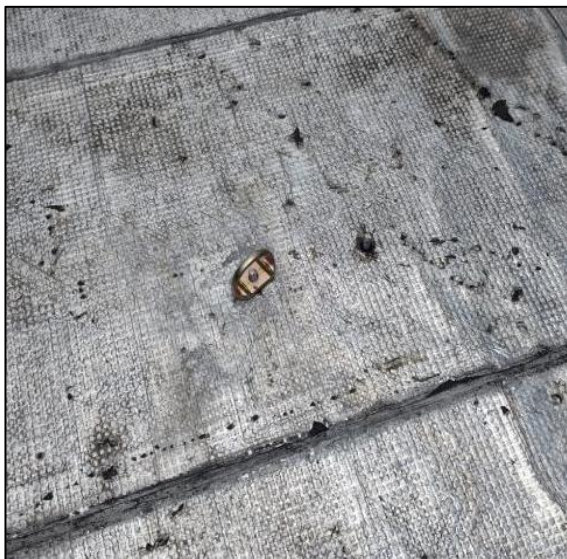
Anclajes De Cubierta
