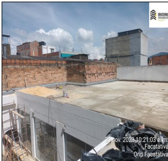
Re Nivelación Placa De Terraza Con Mortero
