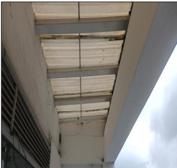
Área De Cubierta Existente
