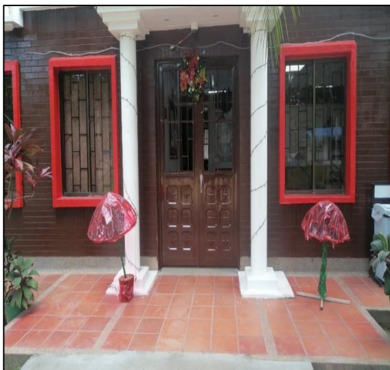
Cambio Puertas De Acceso Principal
