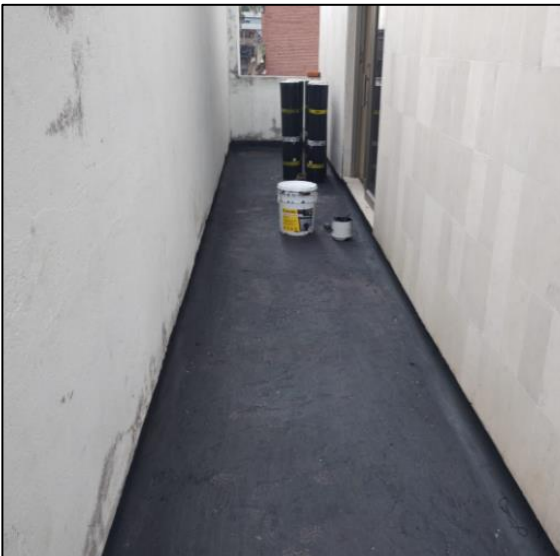
Alistamiento De Placa Para Impermeabilización
