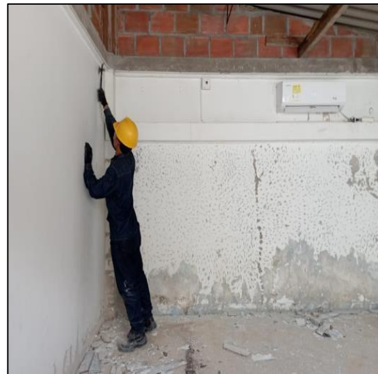
Preparación De Superficie En Muros Para Pañetes
