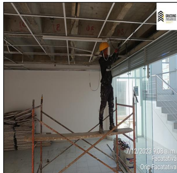
Instalación De Cielo Raso En Área De Atención Al Publico
