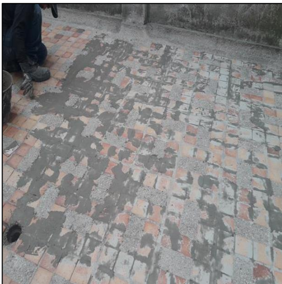
Brechado De Juntas Piso Cafetería
