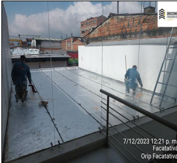
Aplicación De Pintura Bituminosa
