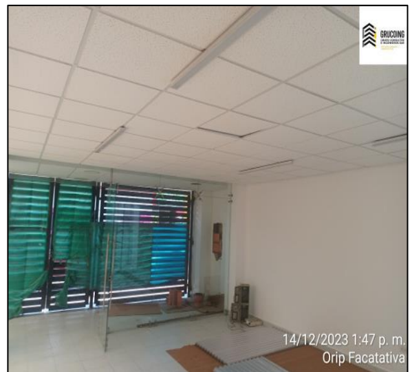
Culminación De Cielo Raso En Área De Atención Al Público
