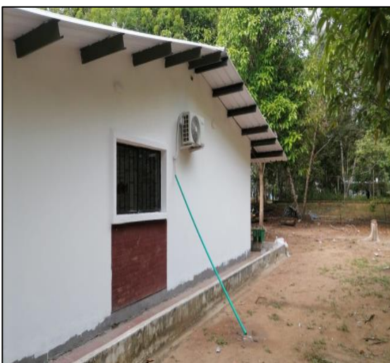
Pintura En Fachada Exterior
