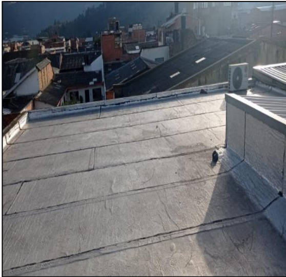
Alistamiento De Placa Para Impermeabilización
