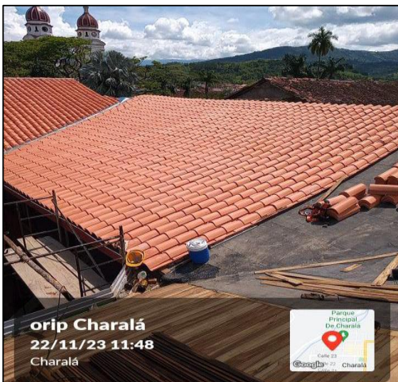
Instalación De Teja De Barro
