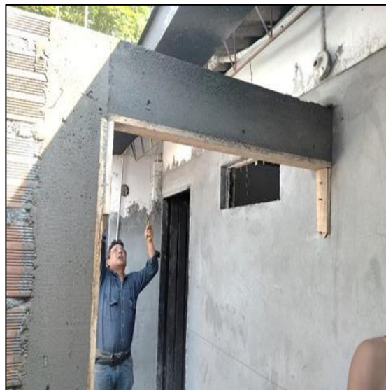
Dintel En Concreto Para Baño De Discapacitados
