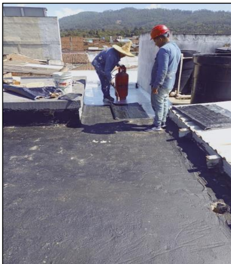
Aplicación De Manto Asfaltico
