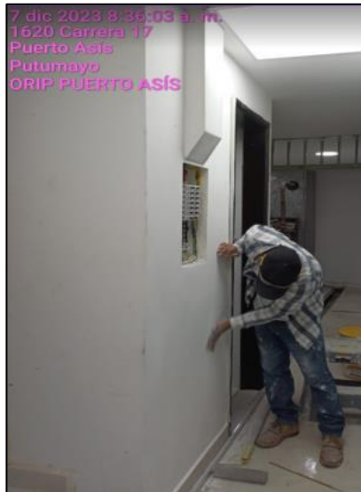
Lijado De Paredes
