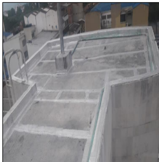
Impermeabilización De La Cubierta
