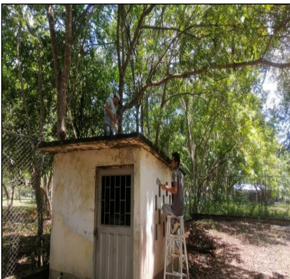
Limpieza Y Escarificación Muros Cuarto Planta Eléctrica
