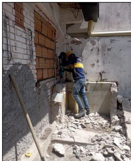
Demolición De Lavadero Existente, Llenado De Vano Existente En Bloque
