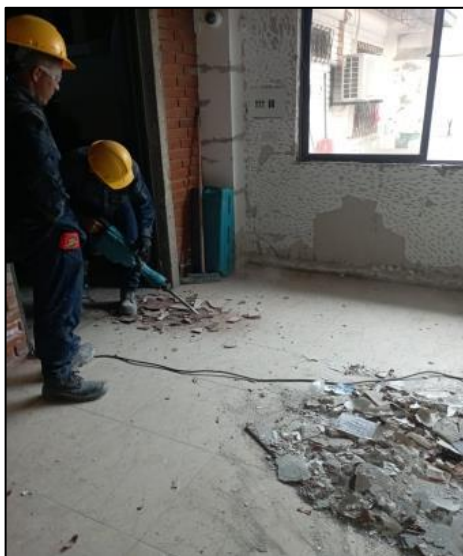
Demolición De Piso Existente
