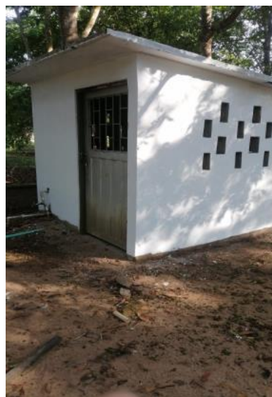
Pintura En Koraza Cuarto Planta Eléctrica
