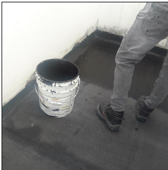
Impermeabilización
