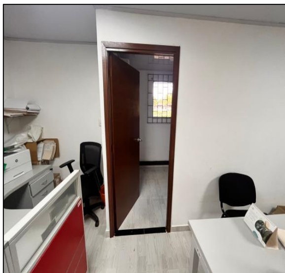
Mantenimiento De Puerta Cuarto Rack
