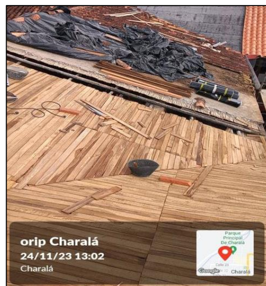
Instalación De Machimbre Para Cubierta
