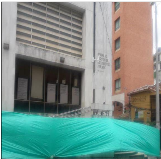
Cerramiento En Poli sombra – Lavado De Fachada
