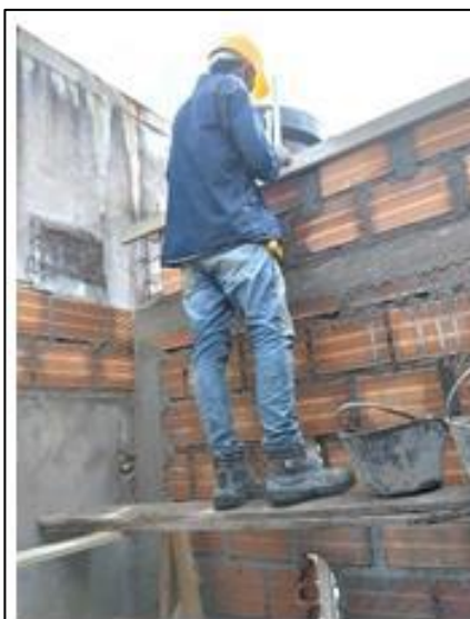
Izado De Muros En Bloque
