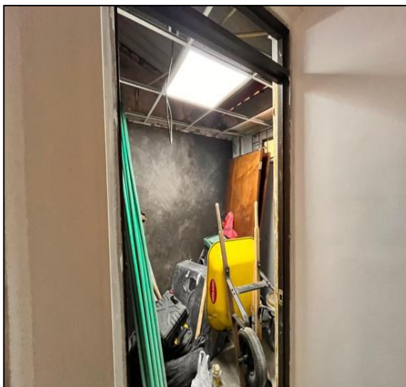
Pañete Sobre Muros
