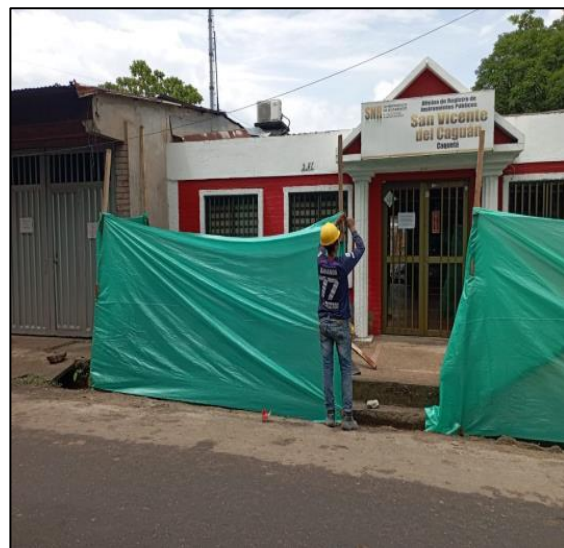
Cerramiento Provisional En Polisombra
