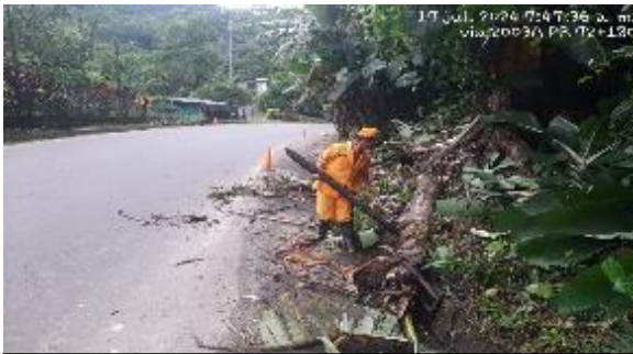
Corte y retiro de arboles PR72+0180, Cooperativa la Paz, vía 2003A
