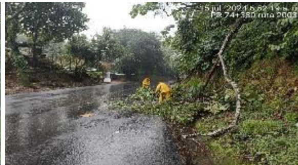
Corte y retiro de árboles PR74+0380, Cooperativa la Paz. vía 2003 a .
