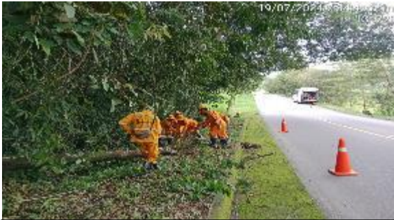
Corte y retiro de árboles PR13+0720, Cooperativa la Amistad, vía 6503
