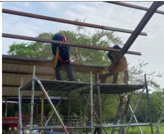
Limpieza de tubería, retiro de material corrosivo con grata.
