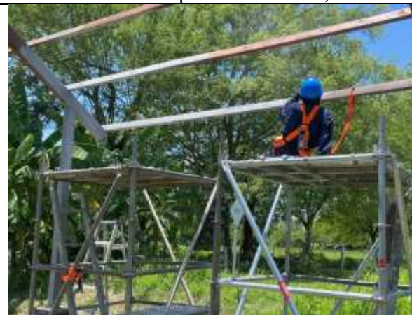
Aplicacion de anticorrosivo.
