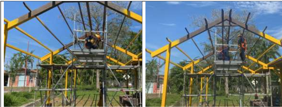
Apliacion pintura lamina llena 3 manos amarillo.
