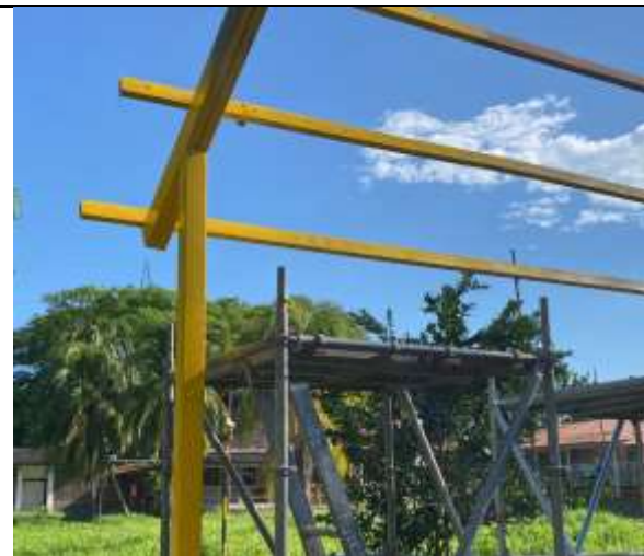
Aplicacion de anticorrosivo.
