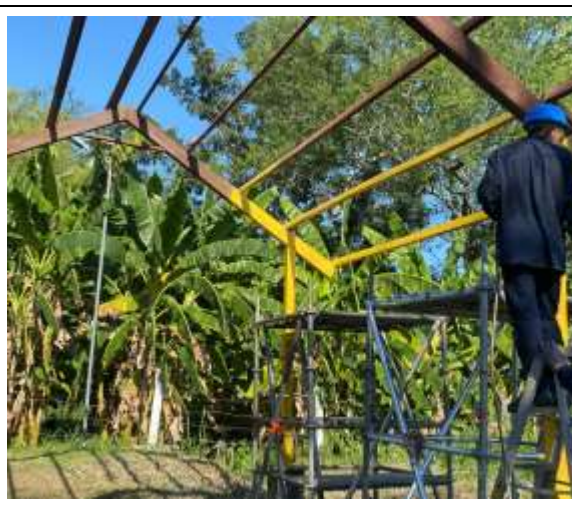
Reemplazo de piezas de estructura metalica.
