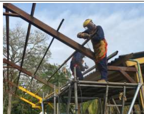
Limpieza de tubería, retiro de material corrosivo con grata.
