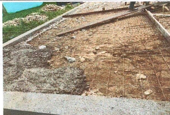
INICIO DE VACIADO DE MEZCLA
