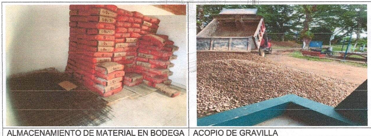
ALMACENAMIENTO DE MATERIAL EN BODEGA
