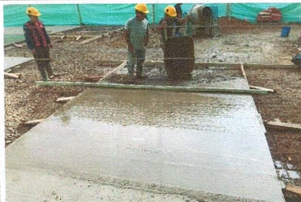
FUNDICIÓN DE PLACAS
