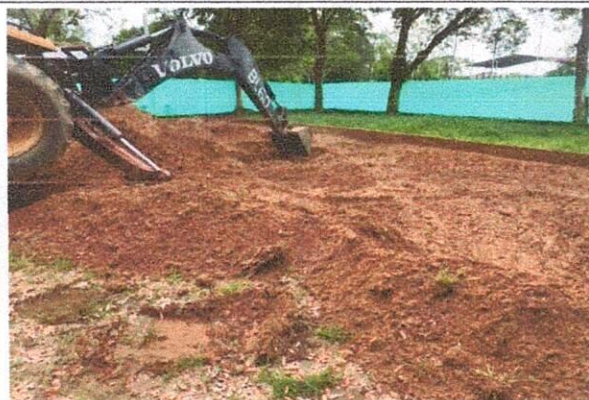
DESCAPOTE Y EXCAVACIÓN
