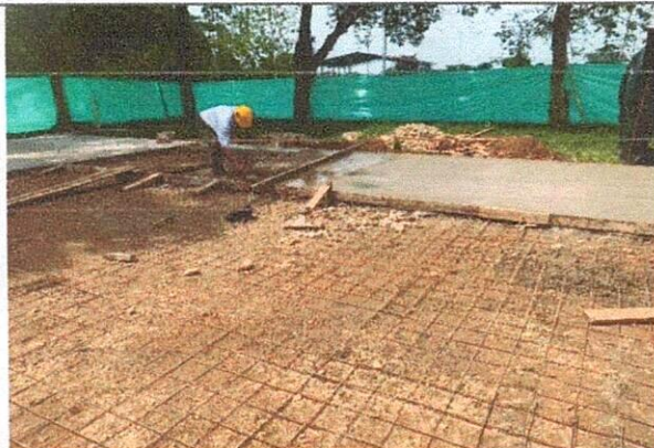
FUNDICIÓN DE PLACAS
