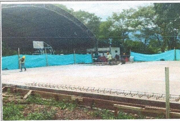
PLACAS EN CONCRETO, LIMPIEZA
