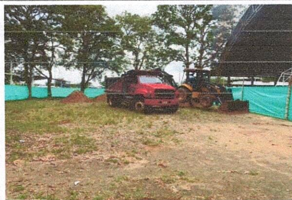
DESCAPOTE Y EXCAVACIÓN DEL TERRENO
