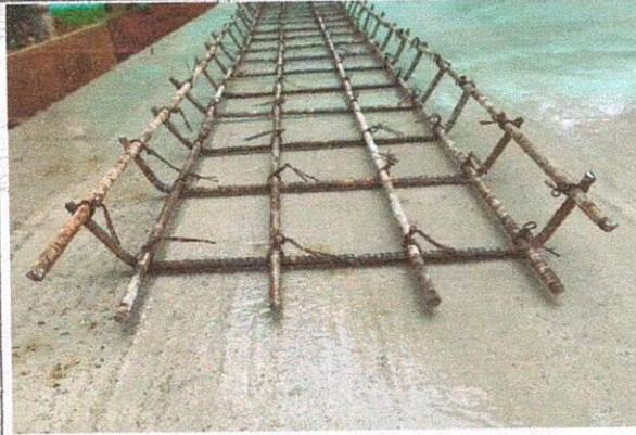
REFUERZO DE ACERO PARA CAÑUELAS
