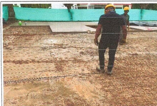
INSTALACIÓN DE MALLA ELECTROSOLDADA
