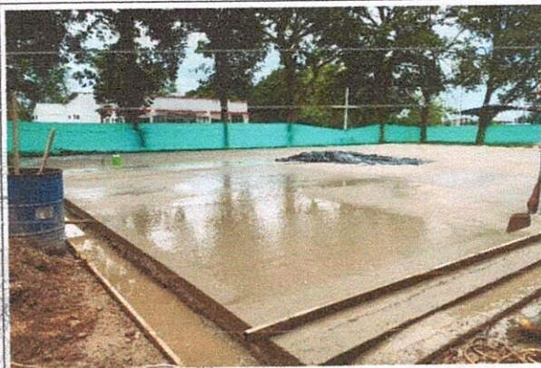
TERMINACIÓN DE PLACAS EN CONCRETO
