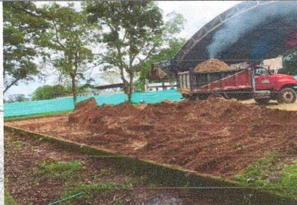
DESCAPOTE Y EXCAVACIÓN DEL TERRENO
