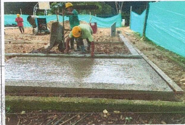
FUNDICIÓN DE PLACAS
