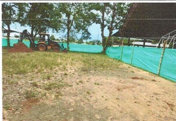
CERRAMIENTO EN LONA VERDE
