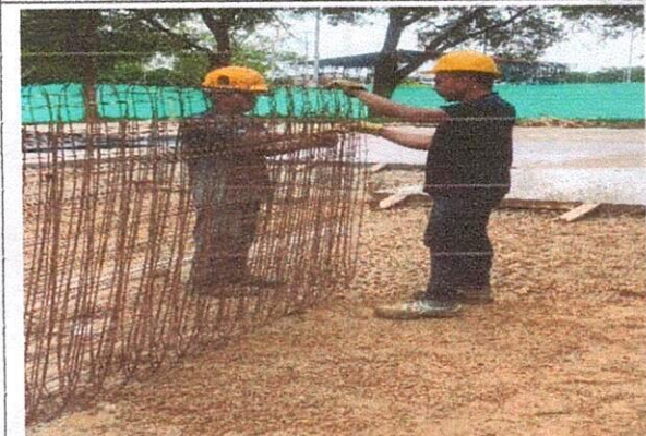
INSTALACIÓN DE MALLA ELECTROSOLDADA
