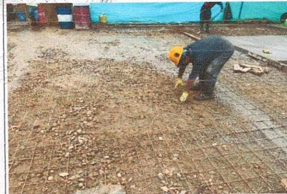
INSTALACIÓN DE MALLA ELECTROSOLDADA
