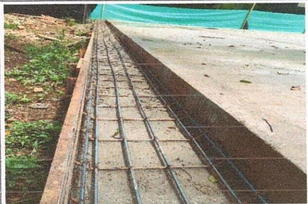
INSTALACIÓN DE REFUERZO EN ACERO DE CAÑUELAS
