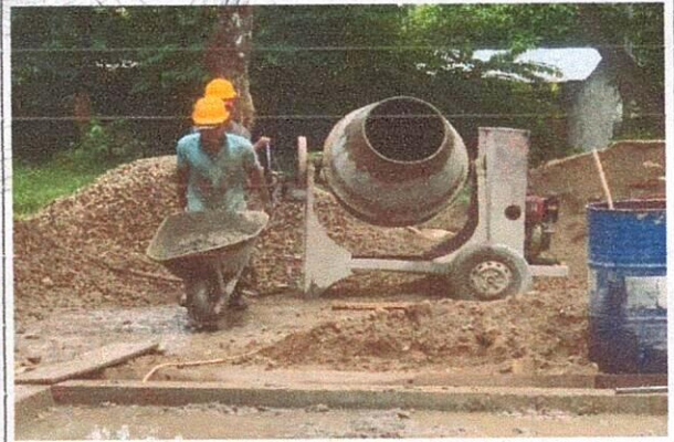
CARGA DE LA MEZCLA
