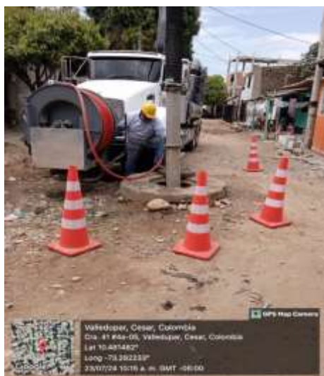
CARRERA 40B # 3C - 49 INTERVENCIÓN: NUEVO AMANECER
