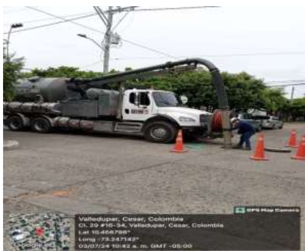
CALLE 29 CARRERA 16 INTERVENCIÓN: SECTOR DE MAYALES
