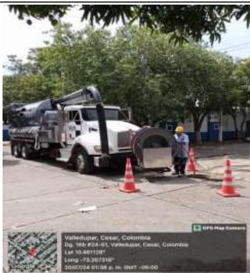
DIAGONAL 16B CON CARRERA 24 INTERVENCIÓN: EL CERRITO
