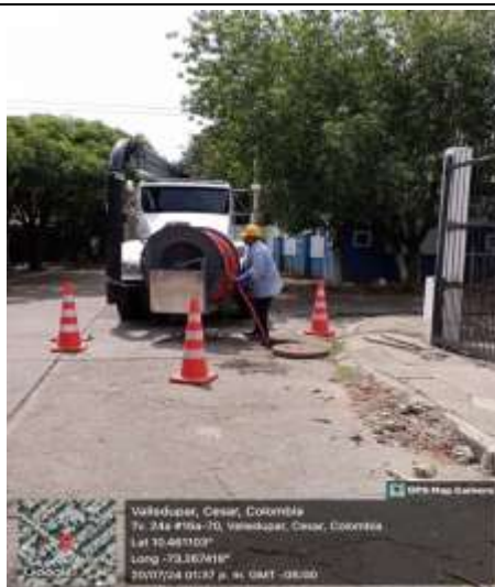
DIAGONAL 16B CON CARRERA 24 INTERVENCIÓN: EL CERRITO
