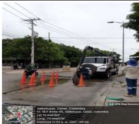
CALLE 18F #33ª INTERVENCIÓN: AVENIDA 450 AÑOS
