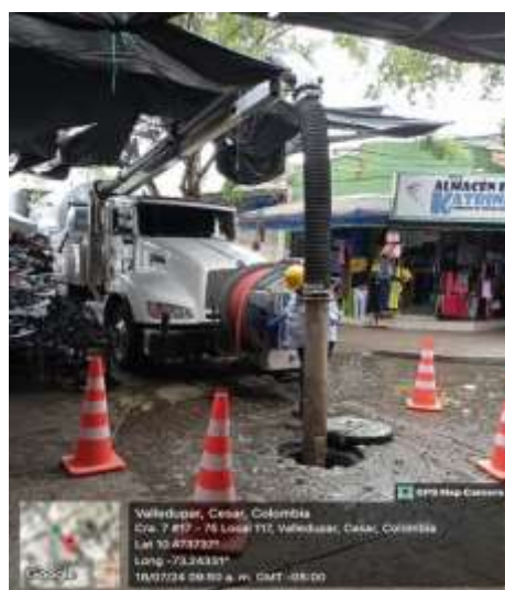
CARRERA 7 # 17-75 INTERVENCIÓN: SECTOR LA GALERIA
