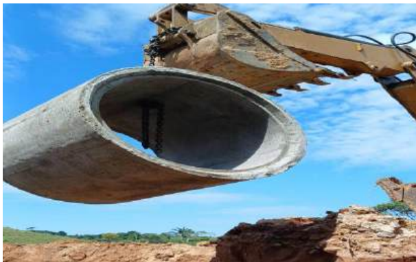
FOTOGRAFÍA 7 (Instalación de 6 tubos de 36")
