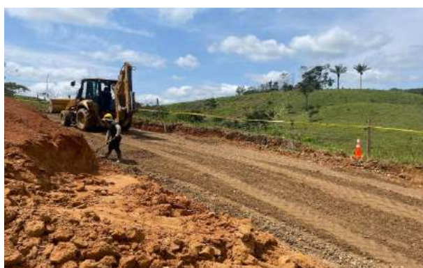
Imagen No. 22: Instalación de sub-base granular.
