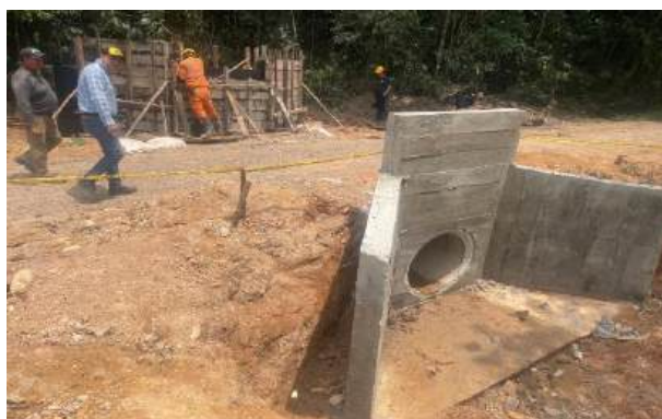
Imagen No. 18: Fundida de poceta en concreto de 3000 PSI.
