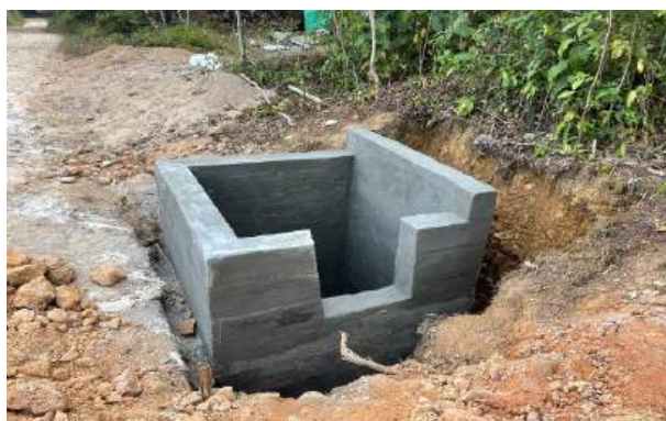
Imagen No. 16: Fundida de poceta en concreto de 3000 PSI.
