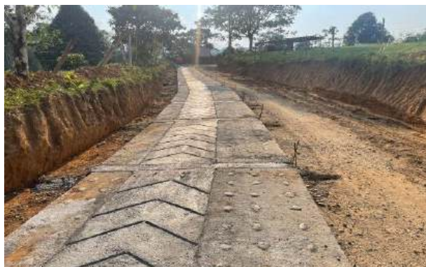
Imagen No. 9: Fundida de huella en concreto 3000 PSI.
