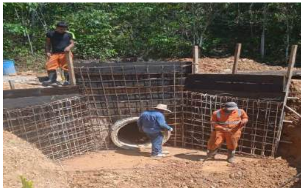
Imagen No. 14: Instalación de acero de refuerzo.
