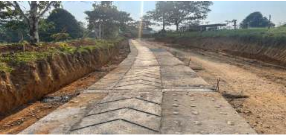
FUNDIDA IN SITU DE CONCRETO 3000 PSI EN HUELLA Y VIGA
