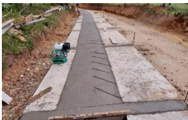
FOTOGRAFÍA 24 (Fundida de huella y viga riostra en concreto 3000 PSI)
