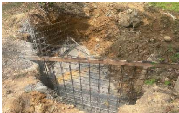
Imagen No. 12: Instalación de acero de refuerzo.
