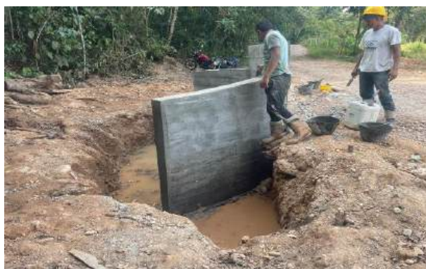
Imagen No. 19: Fundida de aletas en concreto de 3000 PSI.
