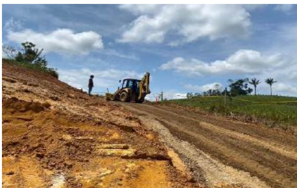
FOTOGRAFÍA 11 (Instalación sub-base granular)
