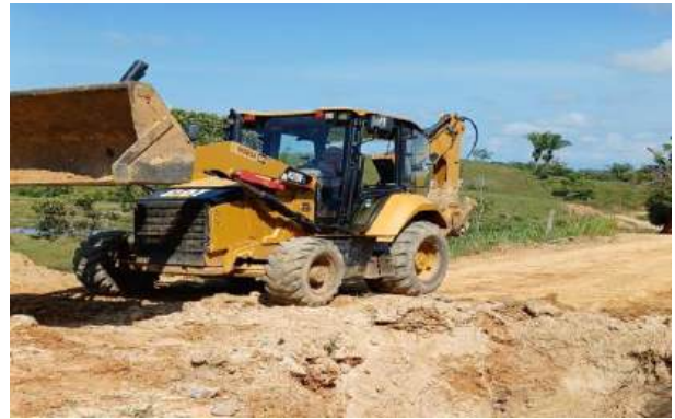
FOTOGRAFÍA 2 (Excavaciones mecánicas para tubería)
