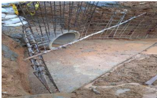
Imagen No. 15: Instalación de acero de refuerzo.
