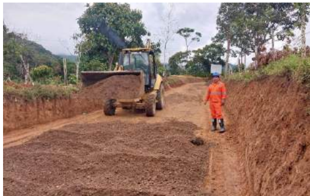
Imagen No. 3: Instalación de sub-base granular.
