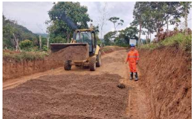
FOTOGRAFÍA 6 (Instalación de sub-base granular)
