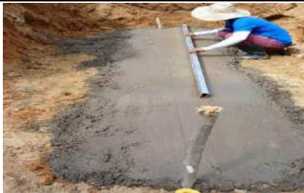
INSTALACIÓN DE SOLADO DE LIMPIEZA E INSTALACIÓN DE TUBERÍA DE CONCRETO DE 36"
