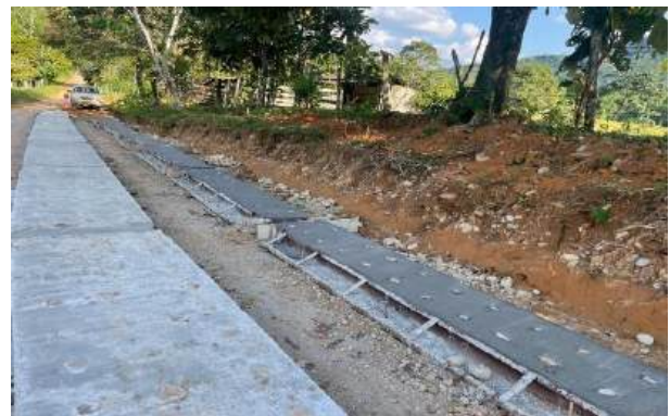
Imagen No. 6: Fundida de concreto ciclópeo en sobreebancho.
