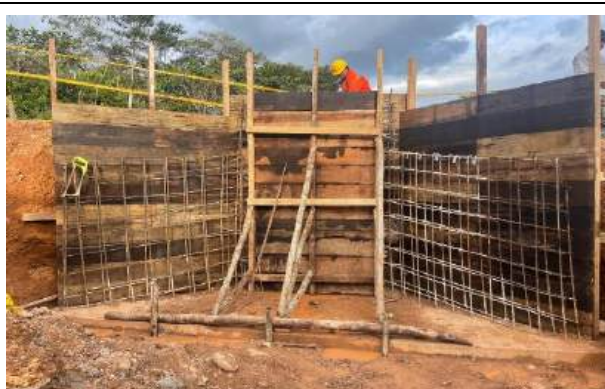
FOTOGRAFÍA 2 (Instalación de acero de refuerzo)
