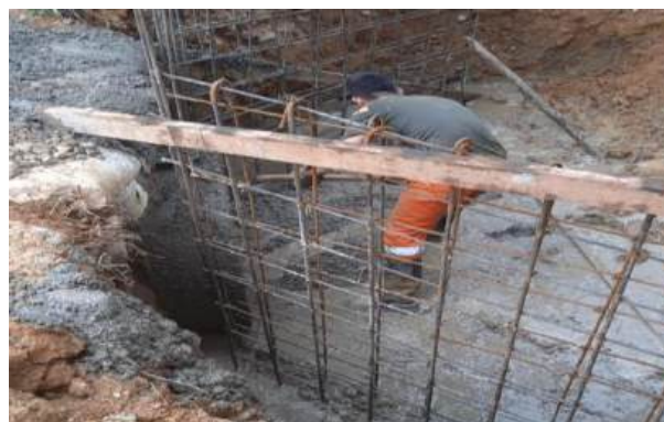
Imagen No. 13: Instalación de acero de refuerzo.
