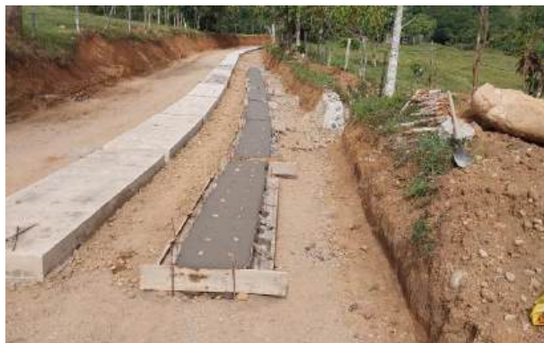
Imagen No. 5: Fundida de concreto ciclópeo en franja central.
