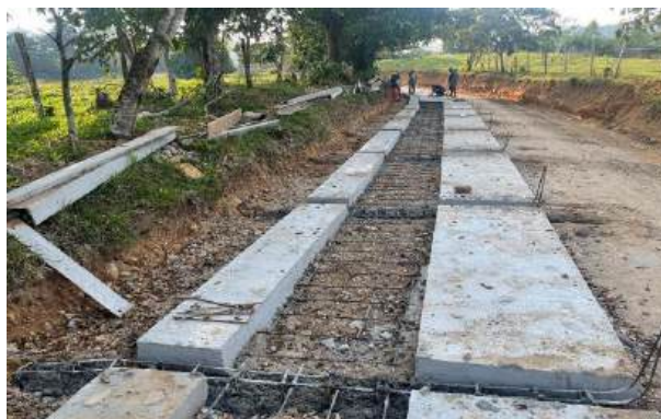
FOTOGRAFÍA 20 (Instalación de acero de refuerzo de viga riostra)
