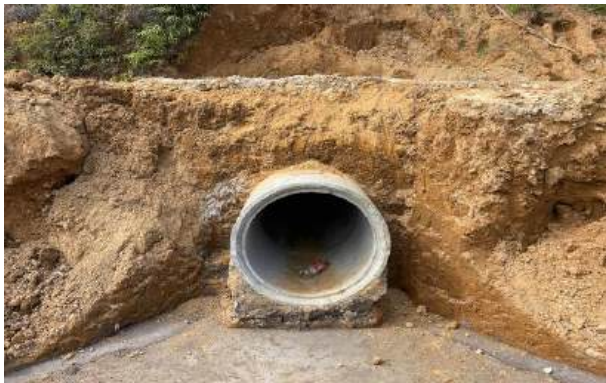
FOTOGRAFÍA 9 (Atraque de tubería en concreto y relleno con material seleccionado)
