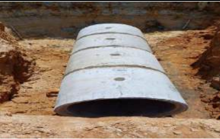
INSTALACIÓN DE SOLADO DE LIMPIEZA E INSTALACIÓN DE TUBERÍA DE CONCRETO DE 36"
