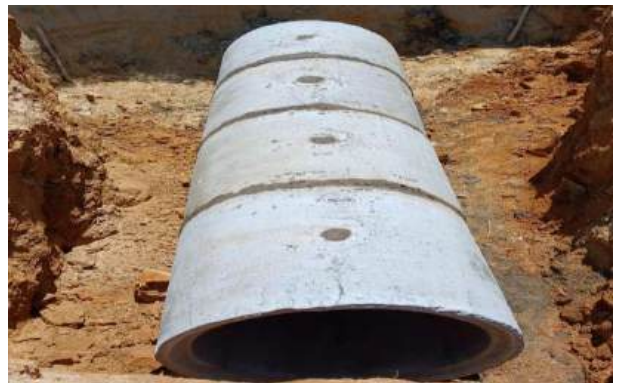
FOTOGRAFÍA 6 (Instalación de 6 tubos de 36")
