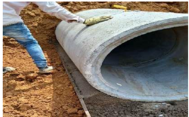
FOTOGRAFÍA 8 (Atraque de tubería en concreto)
