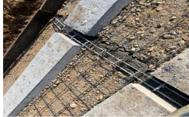
Imagen No. 8: Instalación de acero de refuerzo para viga riostra.
