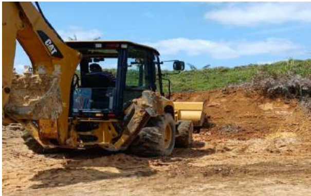
FOTOGRAFÍA 3 (Corte de talud)
