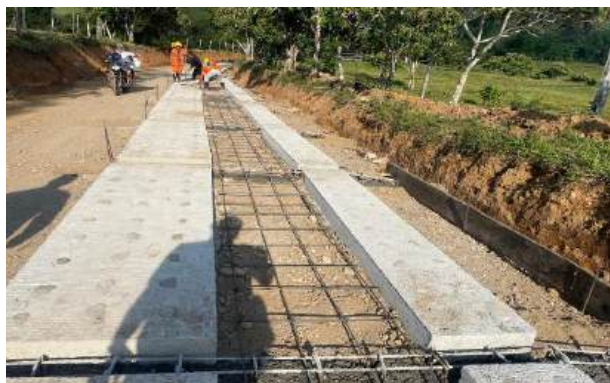
FOTOGRAFÍA 19 (Instalación de acero de refuerzo de huella)
