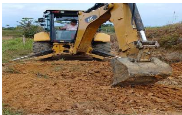
Imagen No. 20: Corte de talud.
