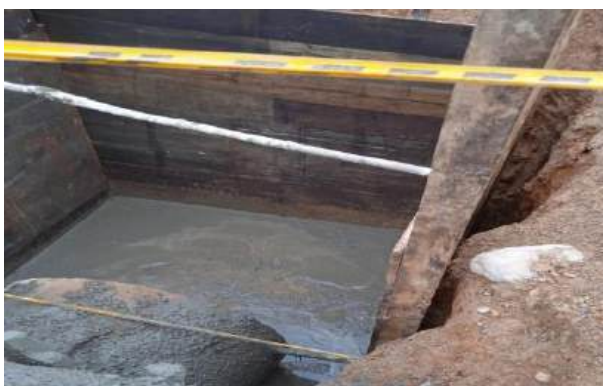
FOTOGRAFÍA 10 (Instalación solado de limpieza en poceta)
