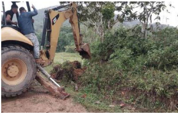
FOTOGRAFÍA 1 (Corte de Talud)
