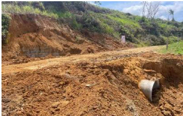
Imagen No. 29: Relleno con material seleccionado.
