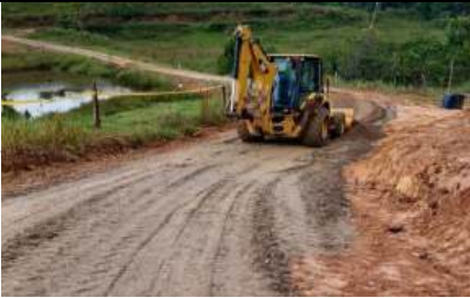
CORTE DE TALUD PARA CONFORMACIÓN Y NIVELACIÓN DE SUBRASANTE
