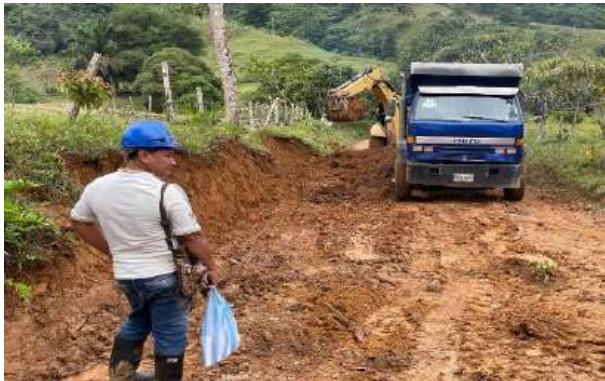
FOTOGRAFÍA 3 (Corte de Talud)
