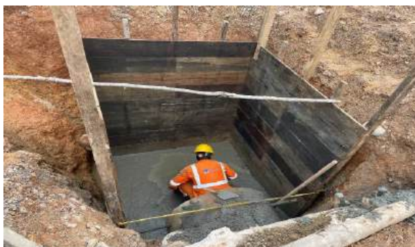
Imagen No. 11: Solado de limpieza para placa de poceta.
