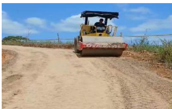
Imagen No. 23: Compactación de sub-base granular.
