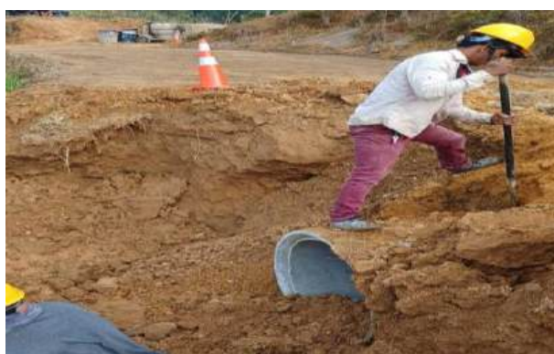
Imagen No. 24: Excavaciones manuales para descole.
