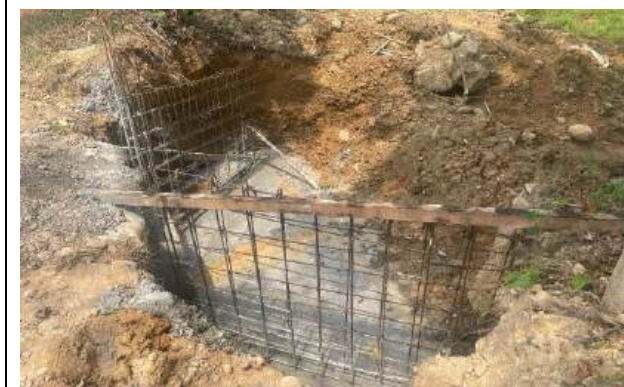
FOTOGRAFÍA 5 (Instalación de acero de refuerzo)
