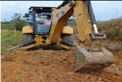
CORTE DE TALUD PARA CONFORMACIÓN Y NIVELACIÓN DE SUBRASANTE
