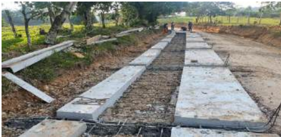
INSTALACIÓN DE ACERO DE REFUERZO EN VIGA RIOSTRA Y HUELLA
