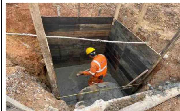
FOTOGRAFÍA 11 (Instalación solado de limpieza en poceta)
