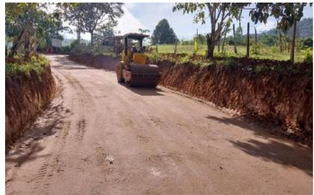
Imagen No. 4: Compactación de sub-base granular.
