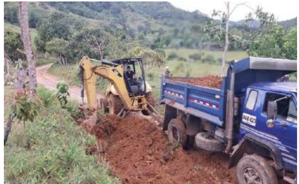
FOTOGRAFÍA 4 (Corte de Talud)
