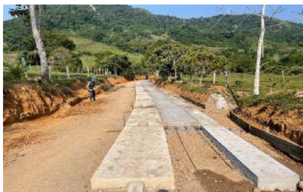
FOTOGRAFÍA 22 (Fundida de sobreo en concreto ciclópeo)
