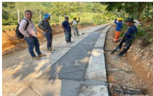
Imagen No. 10: Fundida de huella y viga riostra en concreto 3000 PSI.
