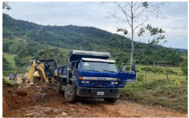
FOTOGRAFÍA 2 (Corte de Talud)
