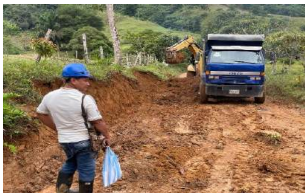
Imagen No. 1: Corte de talud.
