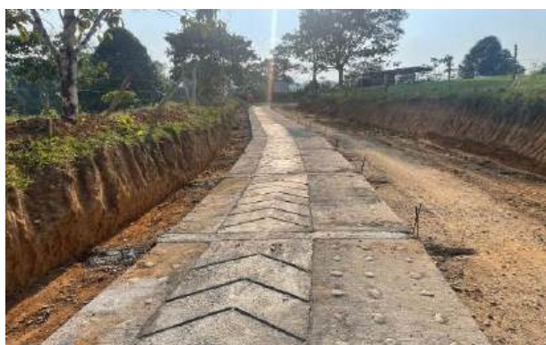
FOTOGRAFÍA 23 (Fundida de huella y viga riostra en concreto 3000 PSI)
