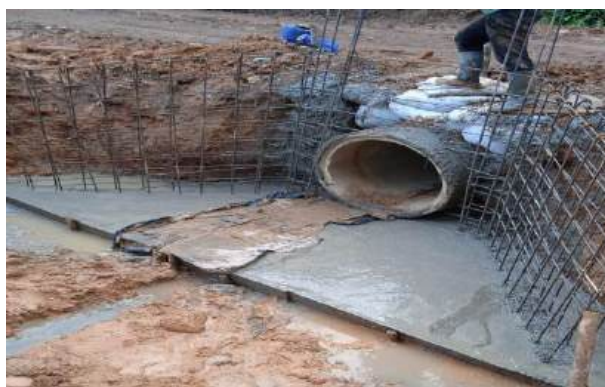
FOTOGRAFÍA 6 (Instalación de acero de refuerzo)
