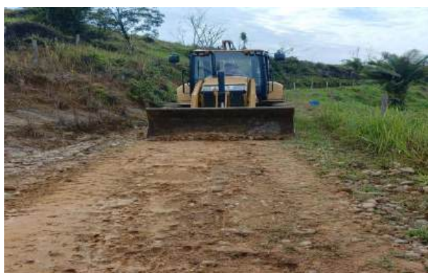
Imagen No. 21: Conformación y nivelación de subrasante.
