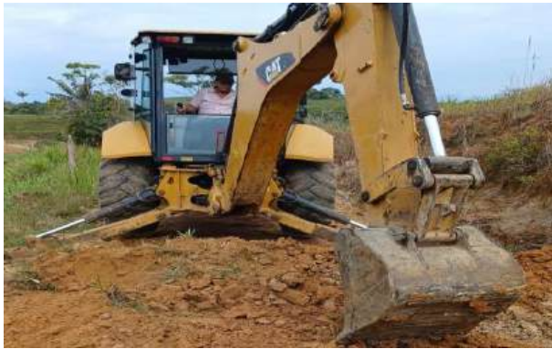
FOTOGRAFÍA 1 (Excavaciones mecánicas para tubería)
