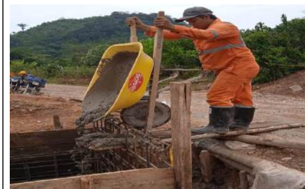
FOTOGRAFÍA 9 (Fundida de poceta en concreto 3000 PSI)
