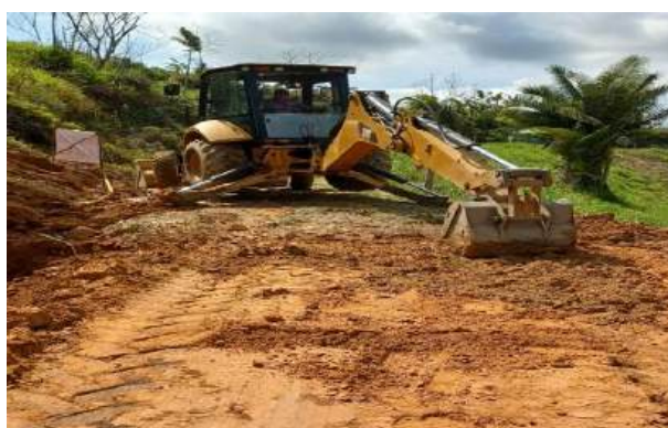
Imagen No. 25: Excavaciones mecánicas para instalación de tubos.
