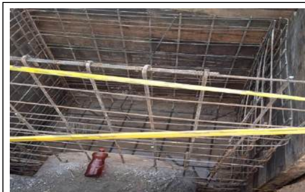
FOTOGRAFÍA 7 (Fundida de poceta en concreto 3000 PSI)
