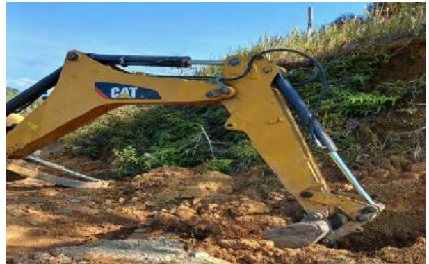
FOTOGRAFÍA 4 (Excavaciones para aletas-poceta)
