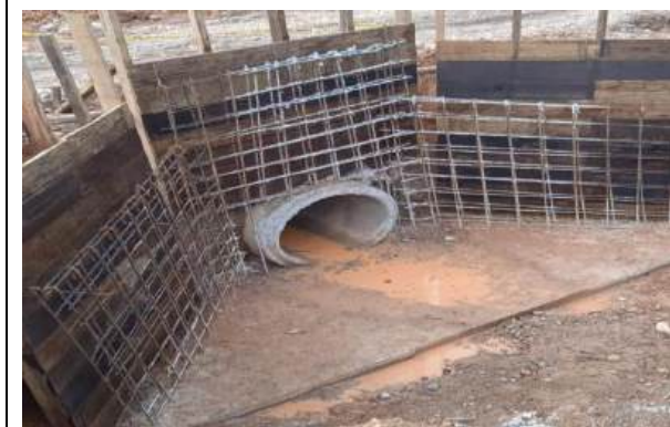
FOTOGRAFÍA 3 (Instalación de acero de refuerzo)
