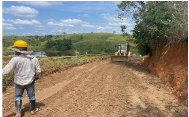
FOTOGRAFÍA 10 (Instalación sub-base granular)
