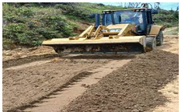
FOTOGRAFÍA 12 (Instalación sub-base granular)
