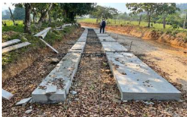
FOTOGRAFÍA 21 (Instalación de acero de refuerzo de huella)
