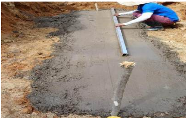
FOTOGRAFÍA 5 (Instalación del solado de limpieza)
