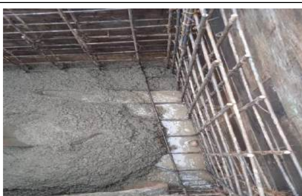
FOTOGRAFÍA 8 (Fundida de poceta en concreto 3000 PSI)
