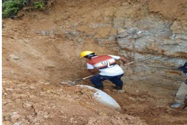
Imagen No. 26: Excavaciones manuales de roca.
