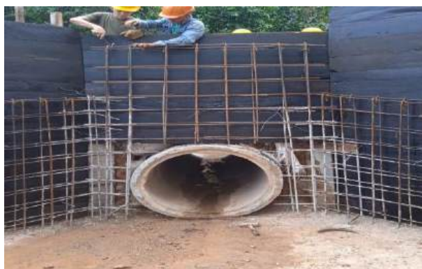
FOTOGRAFÍA 4 (Instalación de acero de refuerzo)
