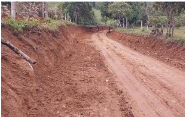
FOTOGRAFÍA 5 (Nivelación y conformación de la subrasante)
