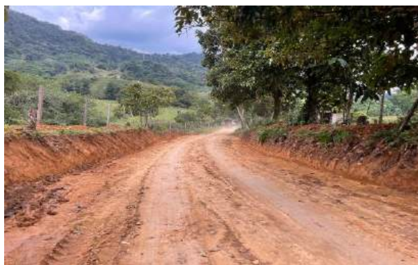
Imagen No. 2: Conformación y nivelación subrasante.
