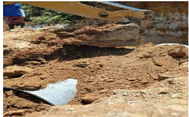
Imagen No. 30: Relleno con material seleccionado.
