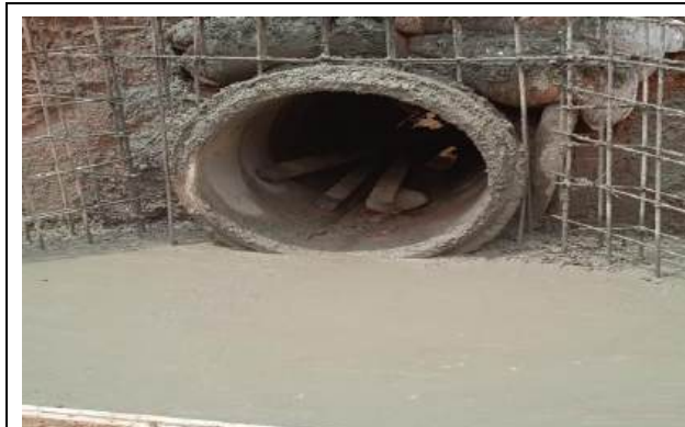
FOTOGRAFÍA 1 (Fundida de placa de descole 3000 PSI)
