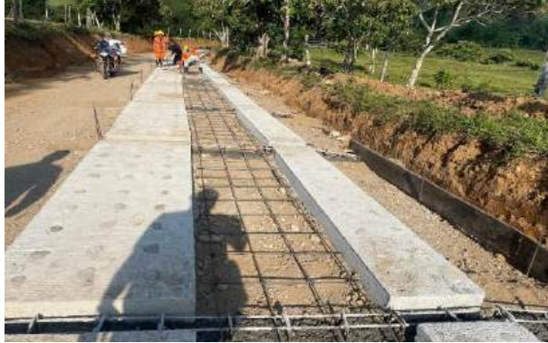
Imagen No. 7: Instalación de acero de refuerzo para huella.
