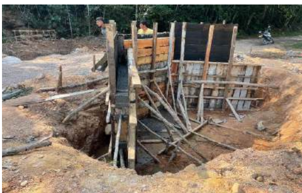
FOTOGRAFÍA 12 (Fundida de aletas y cabezal en concreto 3000 PSI)
