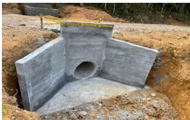
Imagen No. 17: Fundida de aletas en concreto de 3000 PSI.
