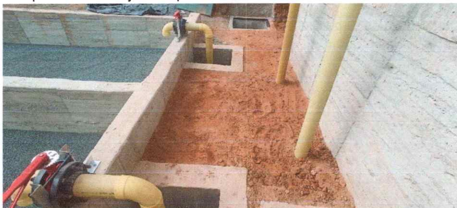
Válvulas compuerta elástica junta rápida
