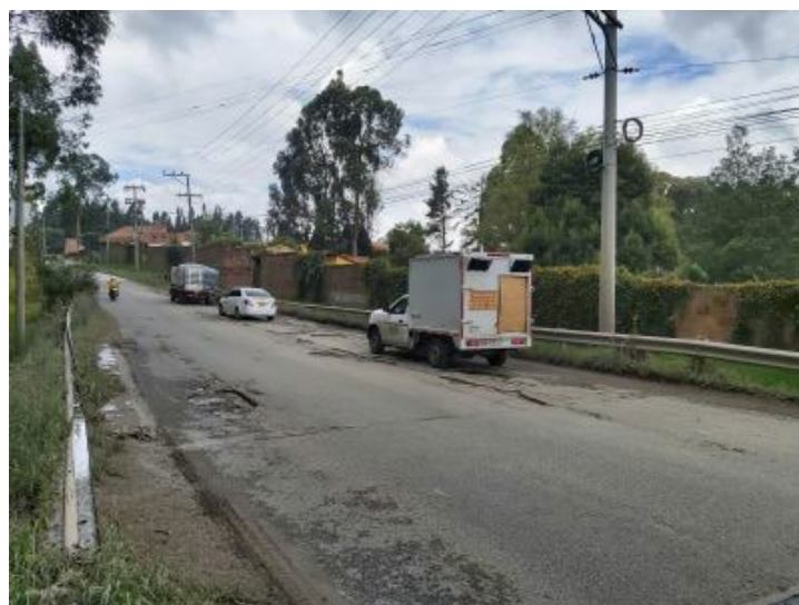
Fotografía 6 Entrada del puente costado Briceño.
