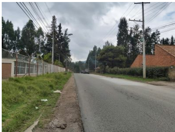
Fotografía 3 Piel de cocodrilo presentes en el pavimento
