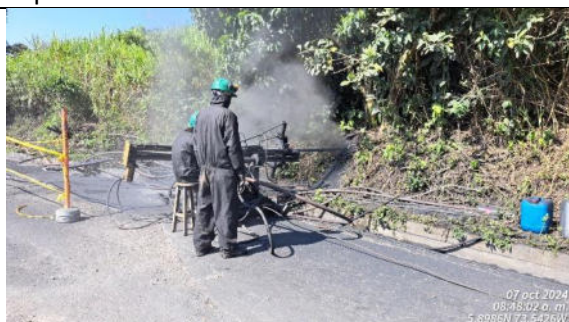
Perforación de drenes horizontales en talud superior. Muro No. 8.
