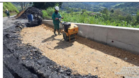
Relleno con material de afirmado compactado. Muro No. 8.
