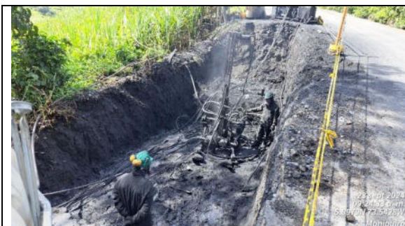
Perforación de anclajes verticales en muro No. 7.
