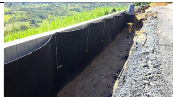
Instalación de geodren vial y relleno con material de afirmado compactado en muro No. 5.
