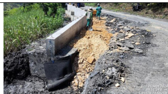
Instalación de geodren vial y relleno con material de afirmado compactado en muro No. 8.
