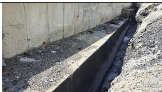
Instalación de geodren vial en muro No. 4.
