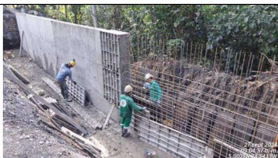
Amarre de acero de refuerzo y fundida de pantallas en concreto. Muro No. 7.
