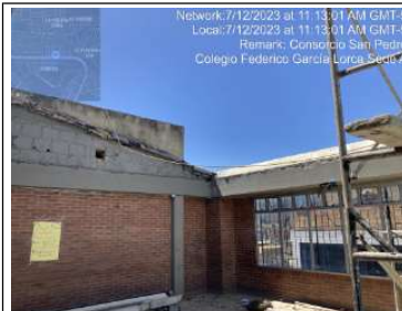
Desmonte de cubierta existente
