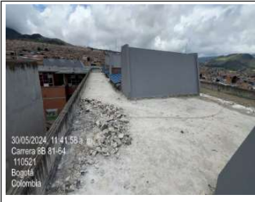
Demolición de antepiso
