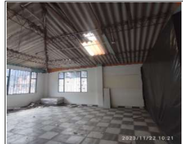
Desmonte de cielorraso y luminarias en Aula 3
