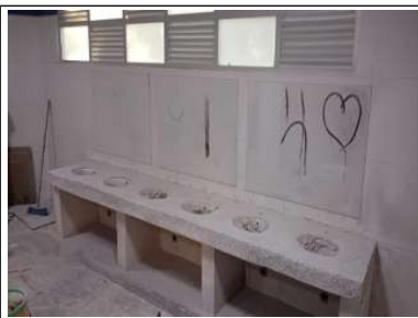
Instalación de Espejos baños niños primer piso
