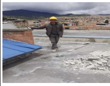
Demolición de antepiso
