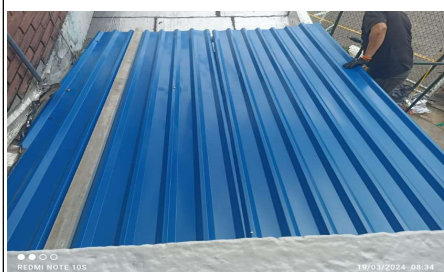
Cubierta de Patio e impermeabilizacion de placa
