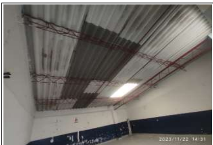
Desmonte de luminarias en Aula 4
