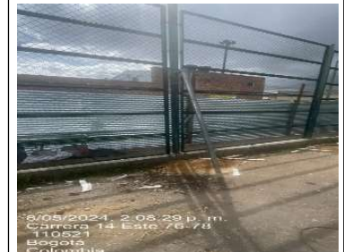
Instalación de tubiera de anclajes
