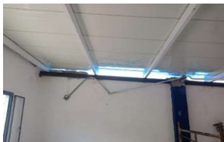
elevación del nivel de cubierta
