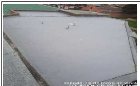
impermeabilización de placa terraza baños
