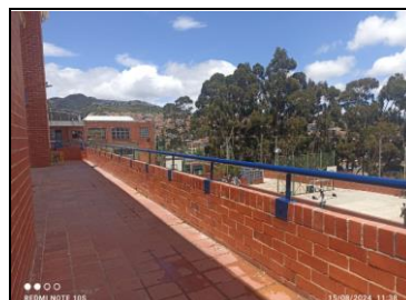
Estado final mamposteria y baranda
