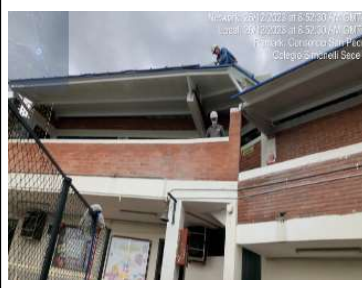
Instalación de nueva cubierta modular tipo sandwich
