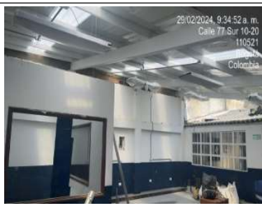
Instalación de teja translúcida en cubierta
