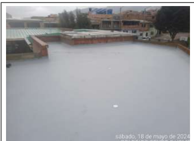
impermeabilización de placa terraza salon química
