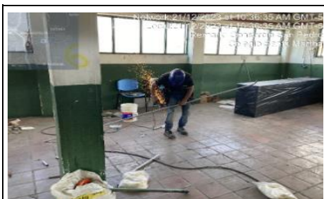
Intalación de acometidas electricas aula 301
