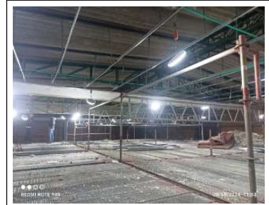
Desmante de tuberia electrica existente
