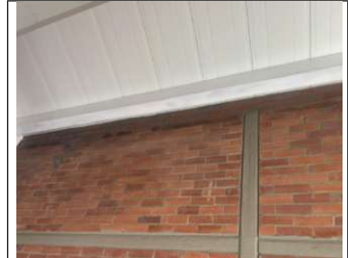
Instalación de encorizado y pintura
