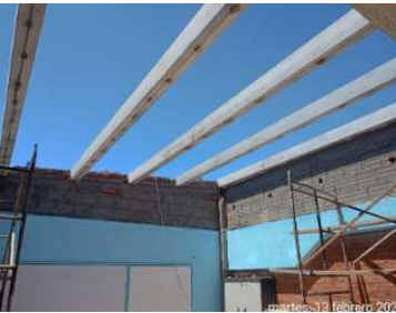
desmonte de cubierta en salones 304-305-306
