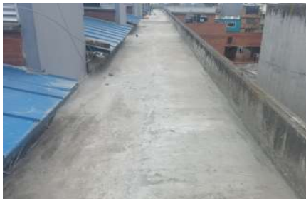
Fundida de mortero de nivelación
