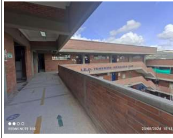
Entrega de area intervenida etapa 1
