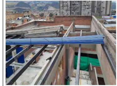
Instalacion cubierta y flanches
