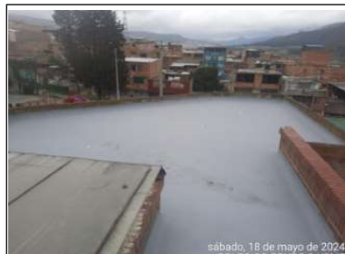
impermeabilización de placa terraza salon química
