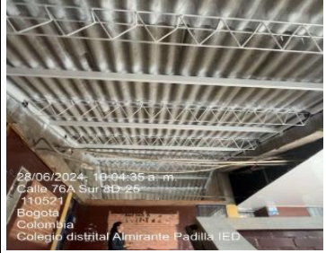
Instalación de perfileria metalica
