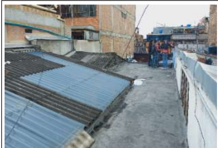
Desmonte de red electrica sobre cubierta
