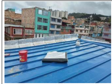
Impermeabilización de antepechos canales
