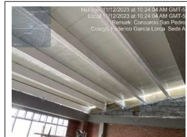
Instalación de perfiles metalicos y cubierta
