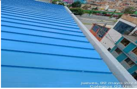
impermeabilización de canales
