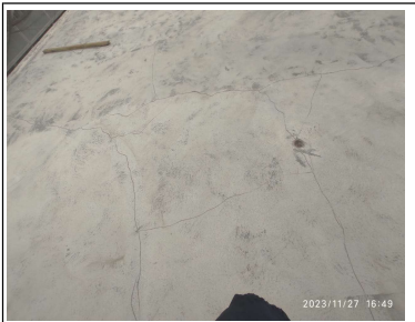
Limpieza de placa, Pulida de piso y Sello de fisura en placa
