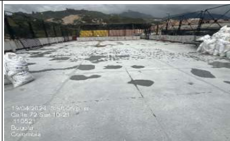
Sello de fisuras
