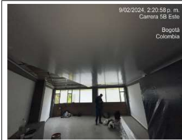
instalación de cubierta en zona de circulación
