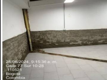
Cambio de bajantes y tubería hasta cajas de inspección
