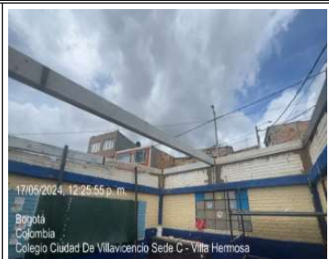
Encorcoe de muros
