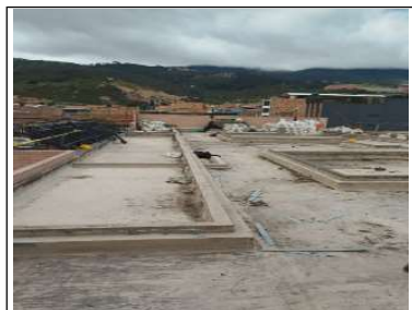
Retiro de membrana PVC
