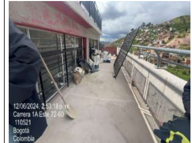
Se continua con retiro de membrana en gradería
