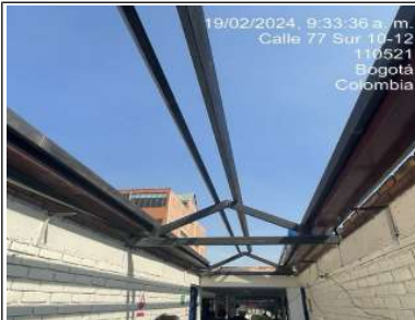
estructura metalica de zona de circulación entrada.
