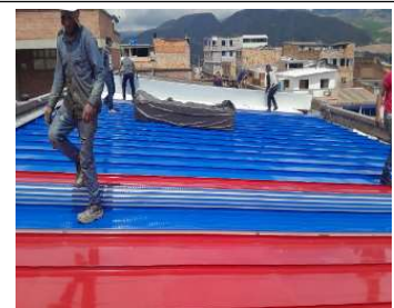
Instalación de cubierta
