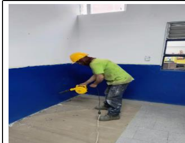
Uso de medios externos para secado de pintura
