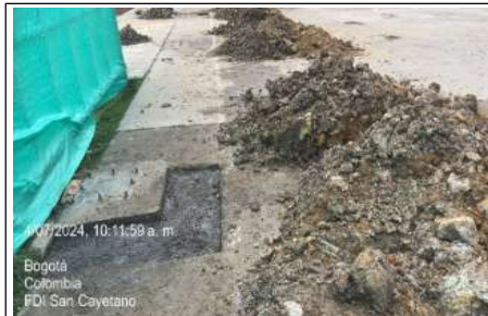
Relleno de zapatas
