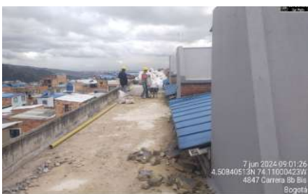
Retiro de escombros
