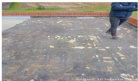
retiro de manto en placa de 1er piso
