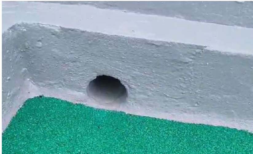
Ilustración 3 Retoque aplicación impermeabilizante en pasante.
