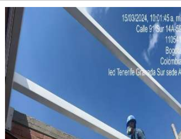
Instalación de perfilieria metalica
