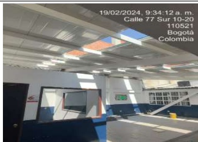
instalación de cubierta de zona de biblioteca
