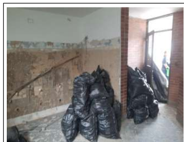
Retiro de escombros
