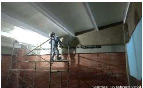
instalación de perfilera y cubierta en salones 304-305-306
