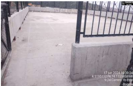
Se continua con sello de dilataciones constructivas y retiro de manto en graderías
