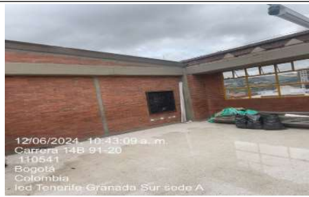
se continua con el desmonte de cubierta
