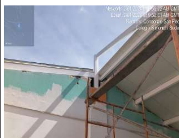
Instalación de perfiles metalicos para cubierta
