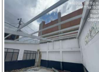
instalación de perfilera metalica en salon No. 6
