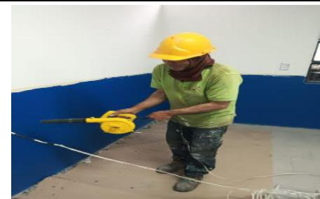
Uso de medios externos para secado de pintura
