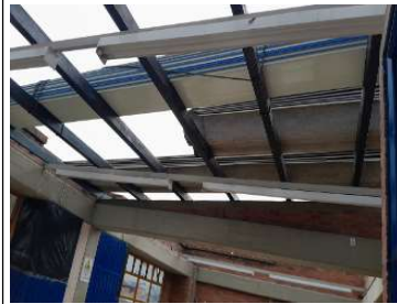
Inatulación estructura de cubierta
