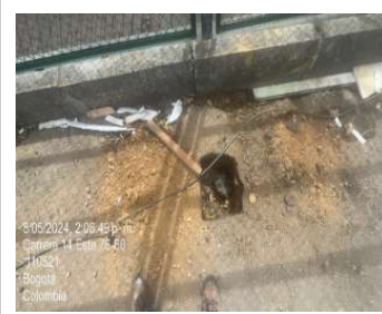
Excavación para anclajes
