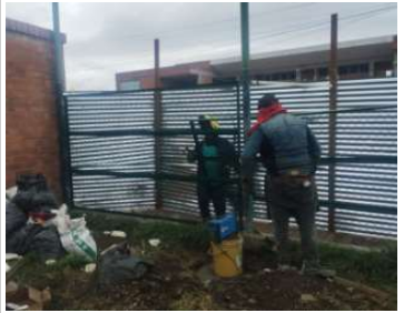
Instalación de paneles
