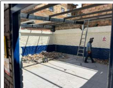
Continua Instalación de perfileria en salon N°. 1
