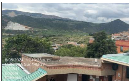
Retiro de Manto sobre Placas
