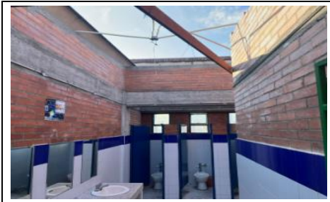
Desmante de cubierta en zona de baños
