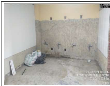
Instalacion de ceramica de muro
