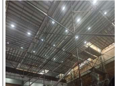
Armado de plataforma en andamio multidireccional
