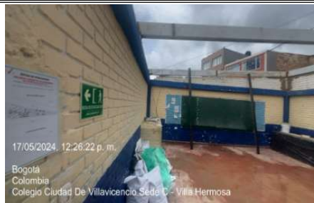
Instalación de perfilera
