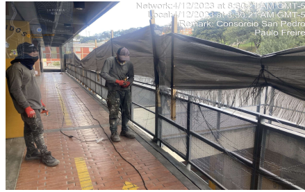
Lijado y limpieza de baranda
