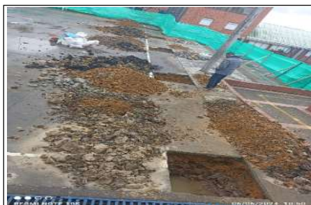
Excavaciones para zapatas
