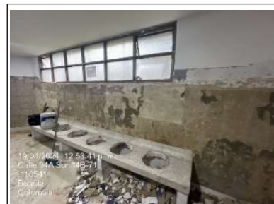
Desmonte de bateria sanitaria
