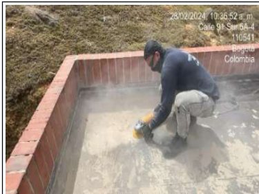
Impermeabilización de placa 3
