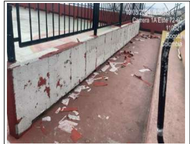
Retiro de Manto sobre la superficie
