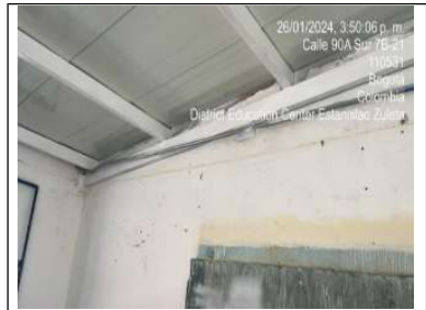
pintura en cerchas
