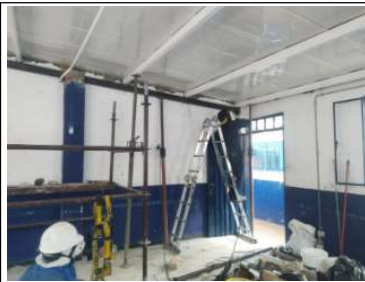
elevación del nivel de cubierta
