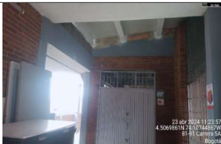
encorocce de muros
