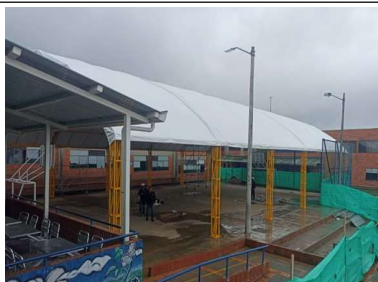
Estado final cubierta cancha
