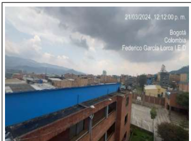
Desmonte de manto asfáltico
