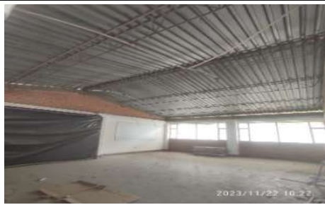
Desmonte de cielorraso y luminarias en Aula 4
