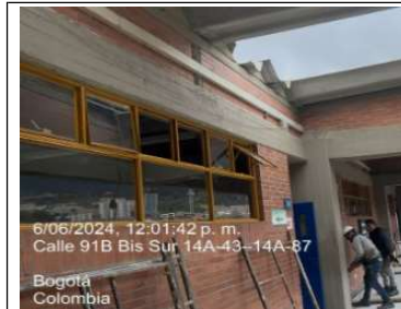
Desmante de cubierta
