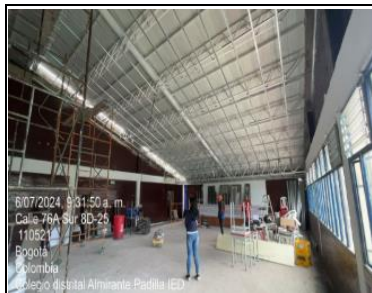
6/07/2024, 9:31:50 a. m. Calle 76A Sur 8D-25 110521 Bogotá Colombia Colegio distrital Almirante Padilla IED Instalación de estructura para cielo raso en auditorio
