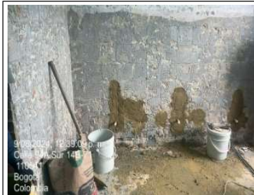
Demolicion de enchape baño de niños segundo piso
