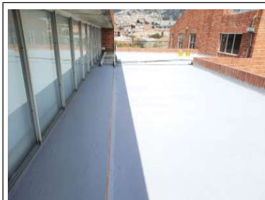
Impermeabilización de placa 1
