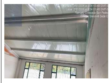
Instalación de cubierta tipo sandwich
