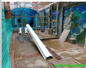
Instalación de canales
