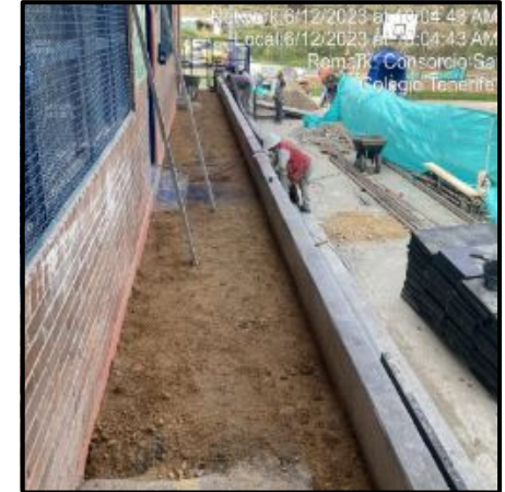
RELLENO DE SENDERO
