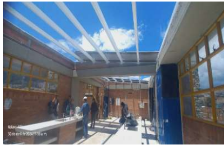
Instalación de perfileria
