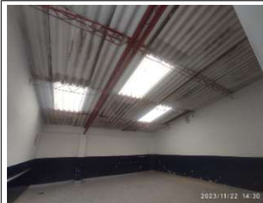
Desmonte de luminarias en Aula 3
