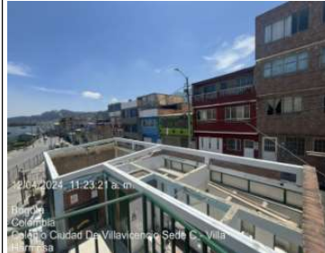
Instalación de perfilera
