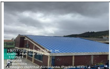
19/07/2024, 9:26:02 a. m. Calle 76A Sur 8D-25 110521 Bogotá Colombia Colegio distrital Almirante Padilla IED Se termina la instalación de cubiera
