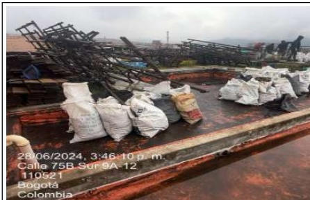
Demolición y retiro de jardines existentes
