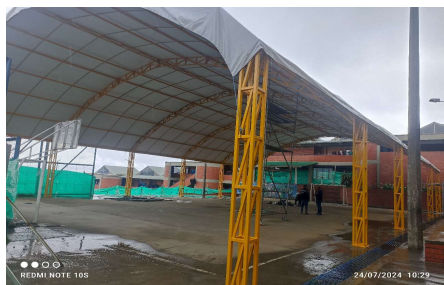
Estado final cubierta cancha
