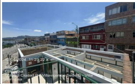
Desmante de cubierta
