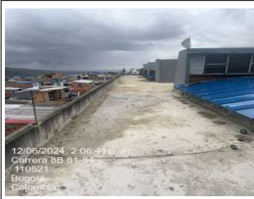
Se continua con la demolición de antepiso
