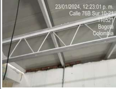
Encoroco de muros
