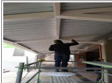
Pintura en estructura existente
