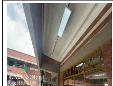
instalación de encorizado
