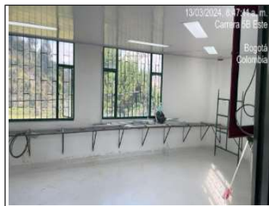
Instalación de lamparas e instalaciones electricas
