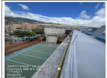
Instalación de tubería para bajante de agua
