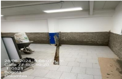
Cambio de bajantes y tubería hasta cajas de inspección
