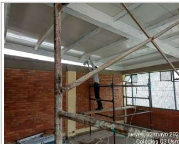
Repinte de estructura metalica
