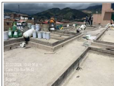
Retiro total de membrano de pvc existente
