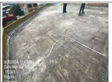
Inducción de fisuras
