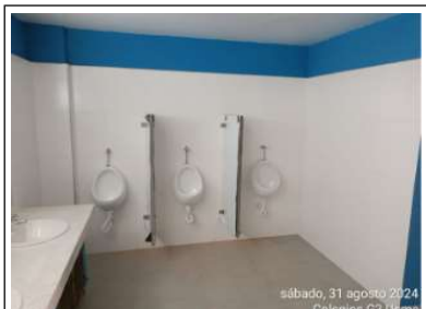
se termina actividades en baños de segundo piso
