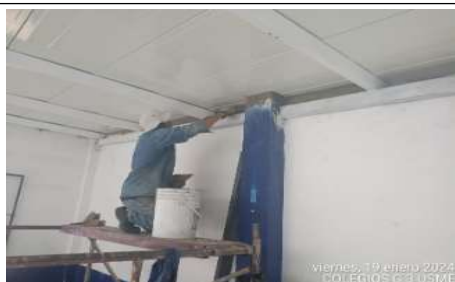
Encorrozado de muros
