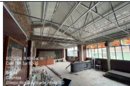
6/07/2024, 9:40:45 a. m. Calle 76A Sur 8D-25 110521 Bogotá Colombia Colegio distrital Almirante Padilla IED Instalación de primer tendido y estructura para cielo raso en cafetería
