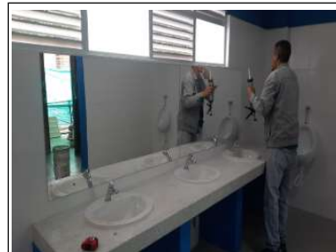
Instalación de espejos en bateria segundo piso
