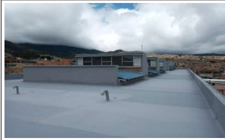
Se termina la instalación del sistema de impermeabilización
