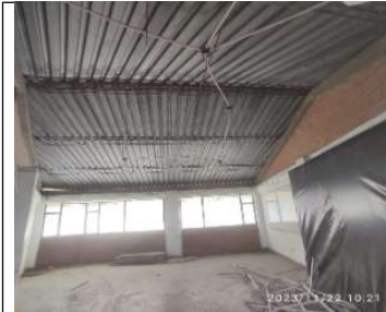
Desmonte de cielorraso y luminarias en Aula 2
