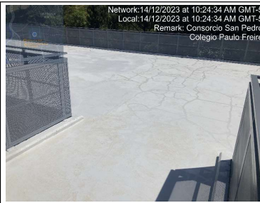
Instalacion de primera capa de imprimación para impermeabilización de placa
