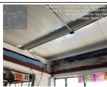
Instalación de puntos electricos aula 301 y 302
