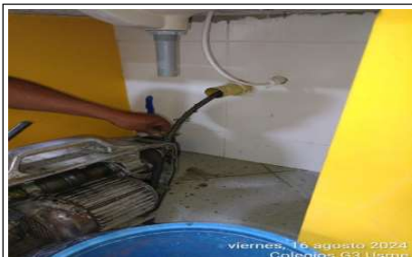
Sondeo de tuberia
