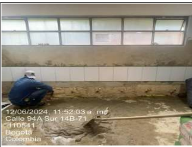
Instlacion de ceramica de muro
