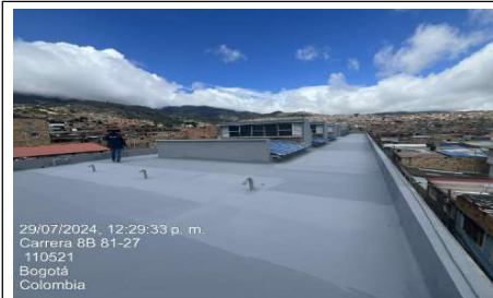
Se termina la instalación del sistema de impermeabilización
