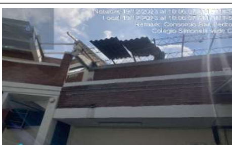
Desmonte de cubierta existente.
