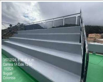
Instalación y terminado de impermeabilización de gradería
