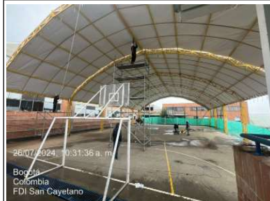
Instalación de estructura metalica para cubierta
