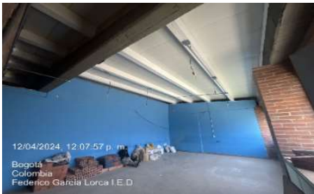
encorocce de muros
