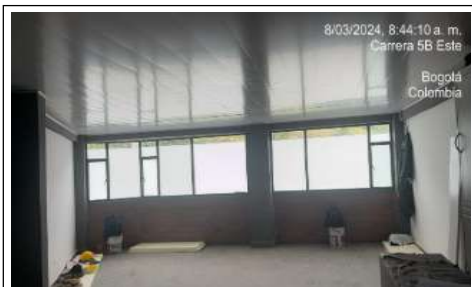
Instalación de cielo raso en salones
