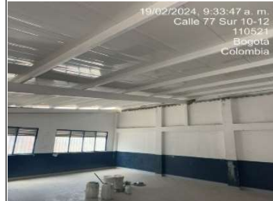
instalación de cubierta aula No. 6
