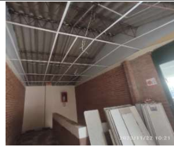
Desmonte de cielorraso y luminarias en pasillo
