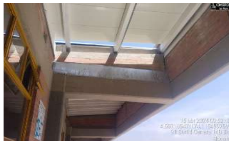
Instalacion cubierta y flanches
