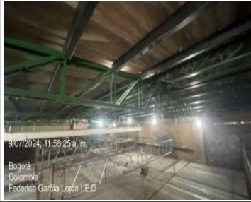
Instalación de correas
