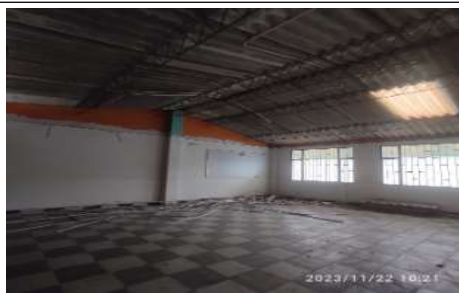
Desmonte de cielorraso y luminarias en Aula 1
