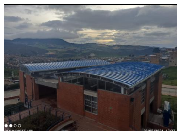
Estado final cubierta
