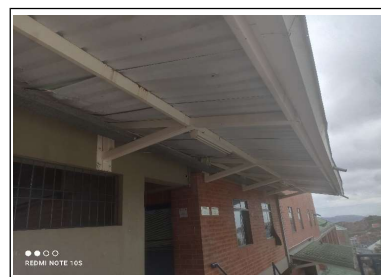
Estado inicial cubierta de Circulación
