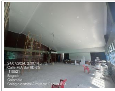
24/07/2024, 2:30:14 p. m. Calle 76A Sur 8D-25 110521 Bogotá Colombia Colegio distrital Almirante Padilla IED Instalación de pintura en vigas y columnas
