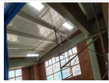
Instalación luminarias y red electrica.
