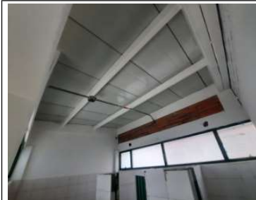
Encorcoe y pintura de muros
