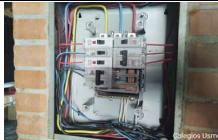
Se realiza instalaciones electrica
