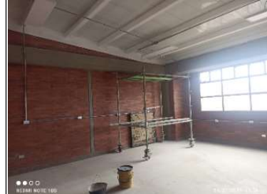
Se termina instalación de cubierta en saon 309
