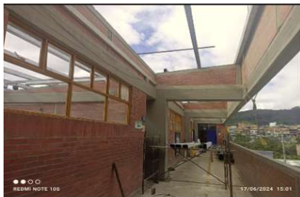
Se continua con el desmonte de cubierta
