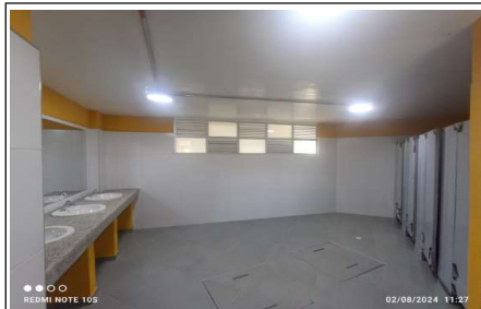
Estado final bateria de baños niñas primer piso
