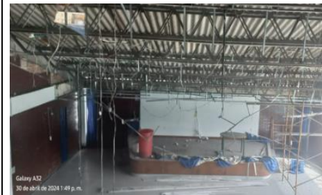
Desmonte de Cielo raso
