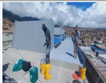
Instalación de Sikafill
