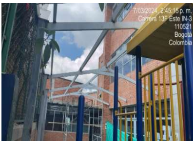
Instalación de porticos
