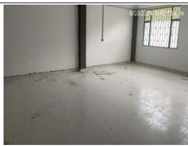
Instalación de guardaescoba
