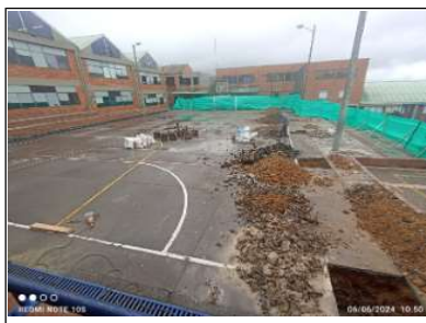
Excavaciones para zapatas
