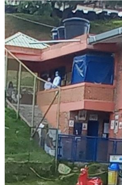
ENFERMERÍA Y FILTRO MANEJO DE AGUAS
