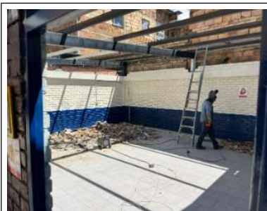
Instalación de perfileria en salon N°. 1
