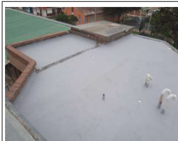
Estado final Impermeabilización placa de cubierta en zona de paños y salón de química
