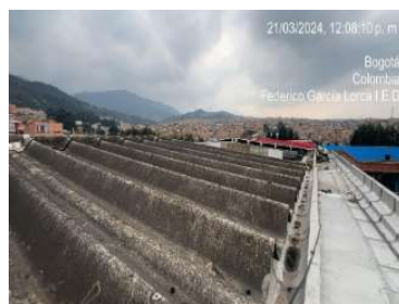
Desmonte de cubierta
