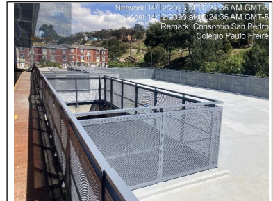
Instalacion de primera capa de imprimación para impermeabilización de placa
