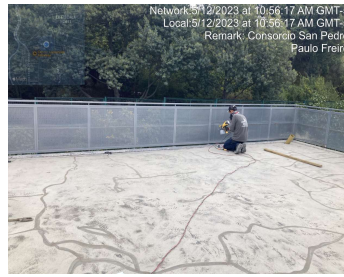
Aplicación de anticorrosivo en barandas
