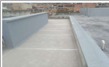
Corte y sello de Juntas constructivas
