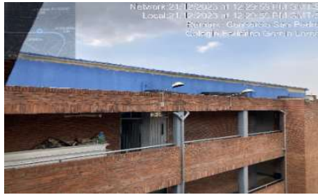
Instalación de cubierta tipo sandwich segundo tendido
