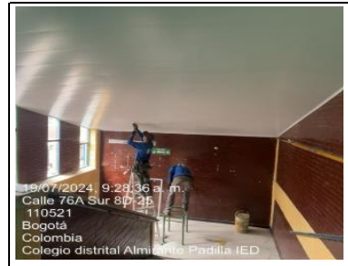
19/07/2024, 9:28:36 a. m. Calle 76A Sur 8D-25 110521 Bogotá Colombia Colegio distrital Almirante Padilla IED Instalación de cielo raso en circulación
