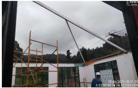
Instalación de perfilera metalica para nueva cubierta
