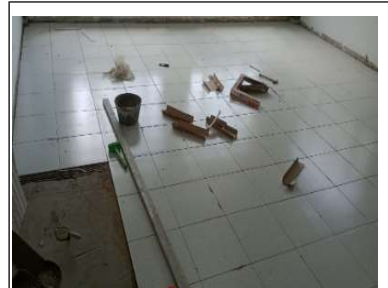
Instalación de duropiso
