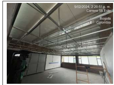
Estructura de cielo raso
