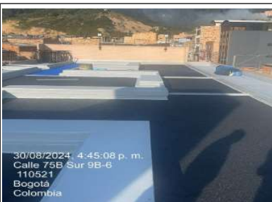
se instala piso chip
