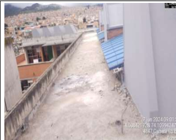
Demolición de antepiso
