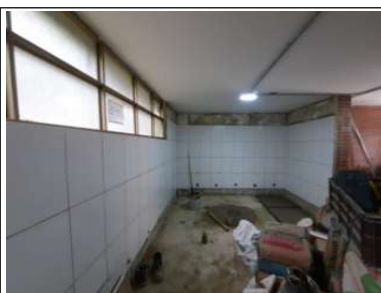
Instalación de enchape de muros de batería sanitaria niñas primer piso
