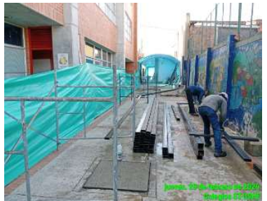
Material estructura metalica, Armado Porticos estructura metalica de cubierta.
