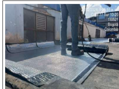
Instalación de manto en placa de cubierta
