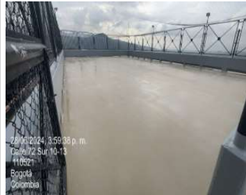
Instalación de cuarzo en placas
