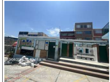
Instalación de perfilera
