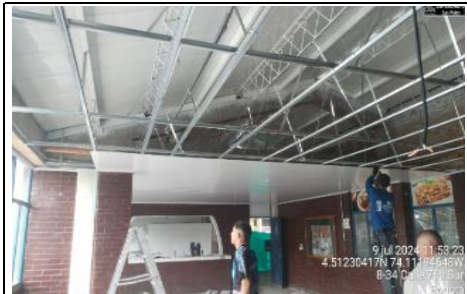
9/07/2024, 11:59:20 4.51230417N 74.1145945W 8:34 C (07/07/2024) Bogotá Instalación de cielo raso en cafetería
