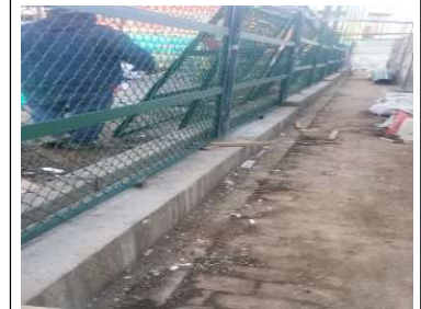
Instalación de paneles
