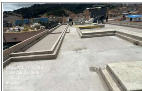
Continua la instalación de mortero
