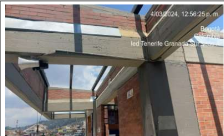
Desmonte de cubierta
