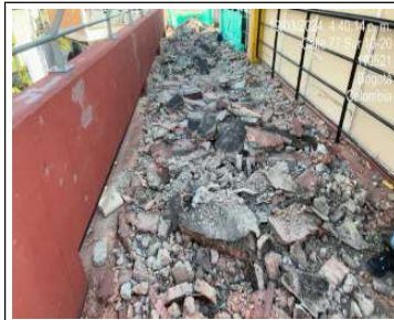
Demolición de circulaciones
