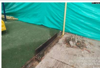
Instalación de bajantes
