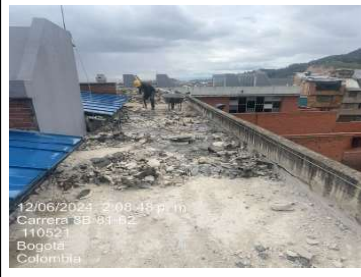
Se continua con la demolición de antepiso
