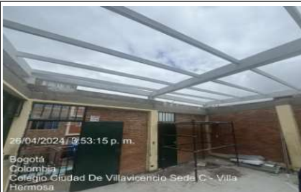
Instalación ed perfilera
