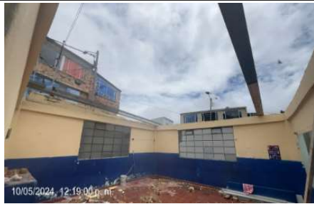
Desmonte de cubierta en salon 303 y 304
