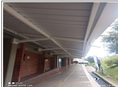
Instalación de flanches en cubierta de circulación
