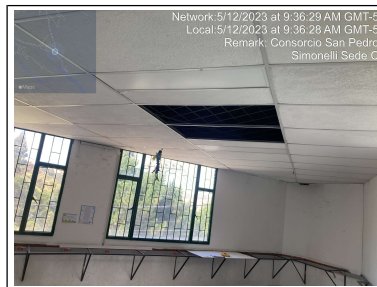
Desmante Cielo raso
