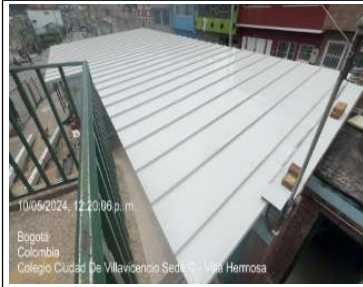
Instalación de cubierta en salon 203
