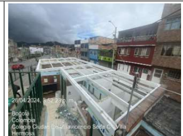
Instalación de perfilera
