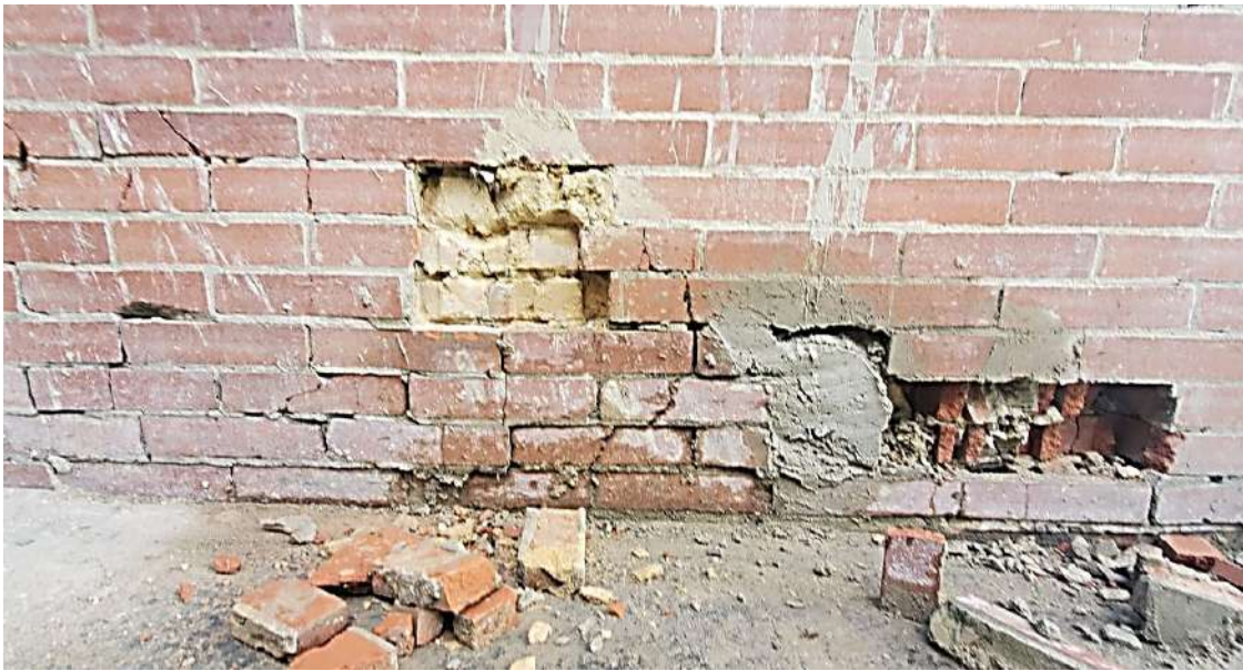
Imagen 1. Muro fachada costado norte. Fecha: 15-08-2024
