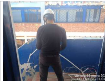
Desmante de tubería eléctrica
