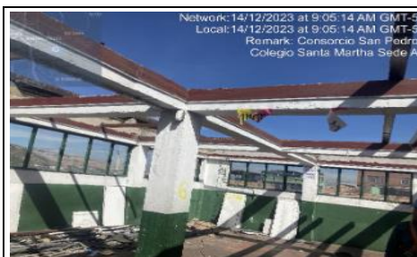
Desmontede cubierta existente
