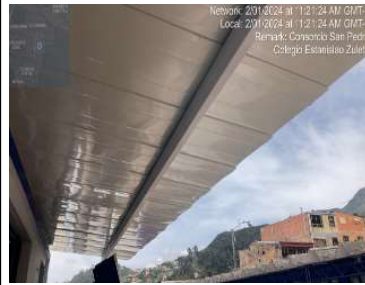
Instalación cubierta tipo sadwich
