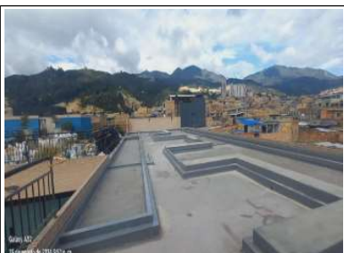
Se realiza sello de junta de dilatación
