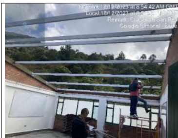
Pintura de perfileria metalica
