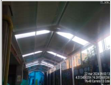
Instalación de cubierta
