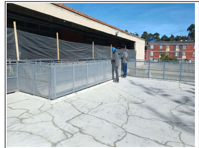
Induccion y sellado de fisuras en plac y Lijado y limpieza de baranda
