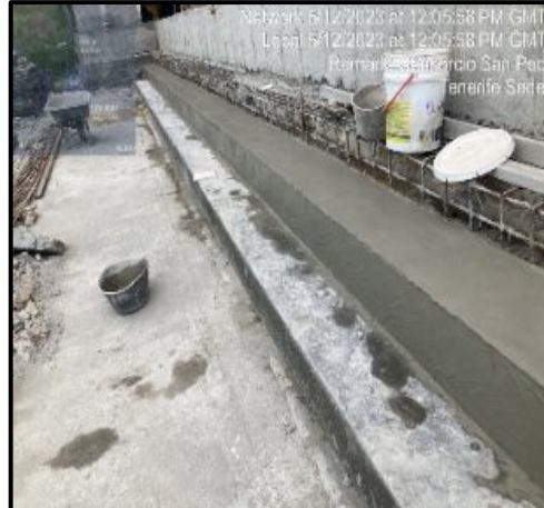
FUNDIDA DE GRADAS
