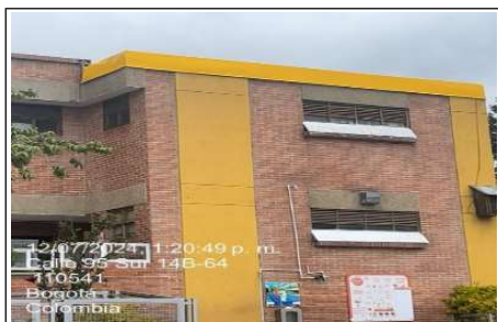
Instalación de Flanches
