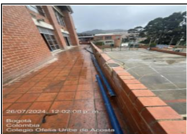
Durante mamposteria y baranda
