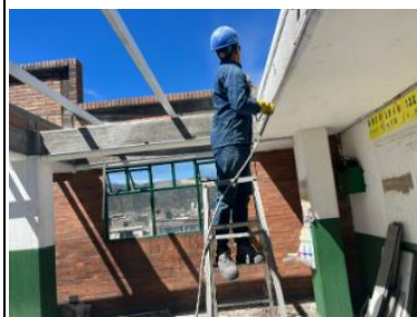
instalación y pintura de perfiles en salon 304 y zona de baños
