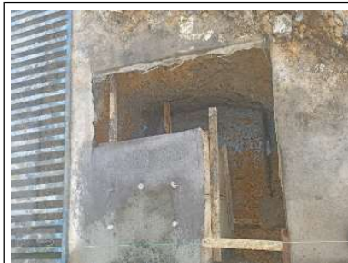
Fundida de zapatas
