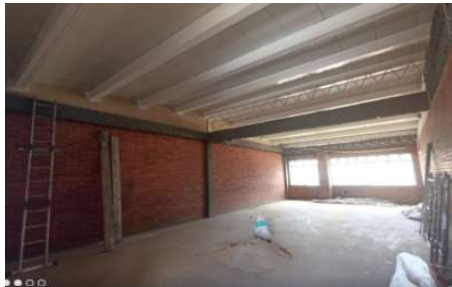
encorocce de muros
