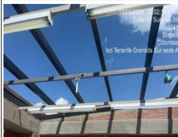
Instalación de perfiles en cubierta
