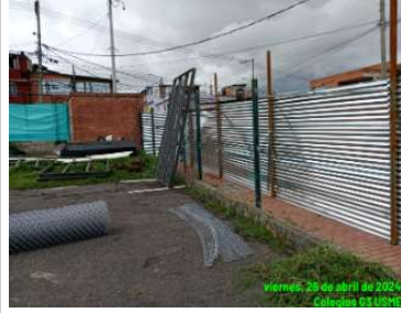
Desmante de paneles existentes
