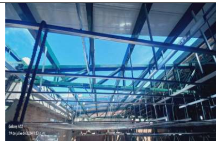
Desmonte de cubierta existente
