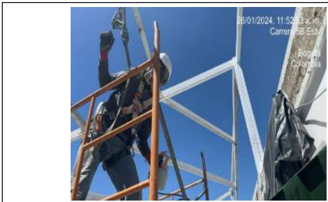
Pintura en perfilera y correas de cubierta
