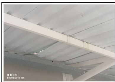
Estado inicial cubierta de Circulación
