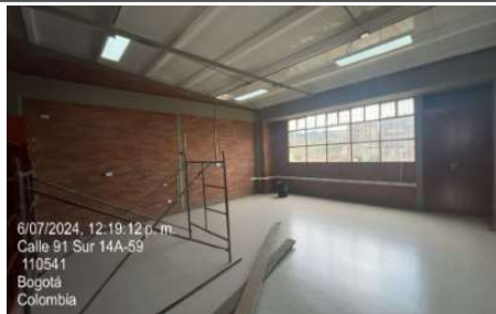
Pintura de tubo rectangular para instalación de video beam
