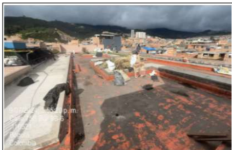
Retiro de membrana PVC
