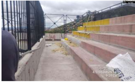
Retiro de alfombra de graderías
