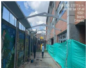
Instalación de porticos
