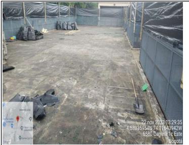
Retiro de manto asfáltico existente
