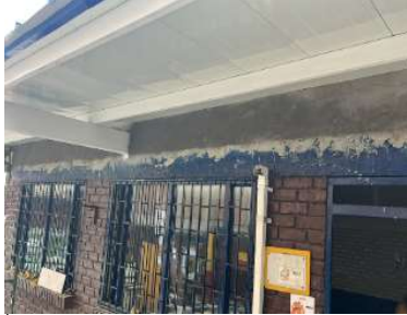
Encoroco de muros
