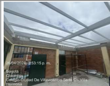
Instalación de perfilera
