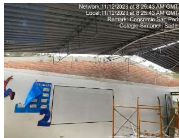
Instalación de platinas para perfiles metalicos de cubierta
