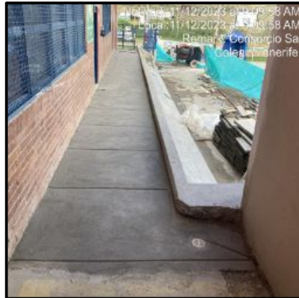
FUNDIDA DE PLACA PASILLO Y ENFERMERÍA
