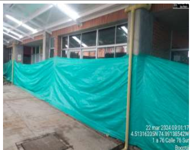
Instalación de bajantes
