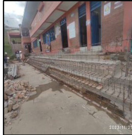
DEMOLICIÓN DE GRADAS Y AMARRE DE ACERO
