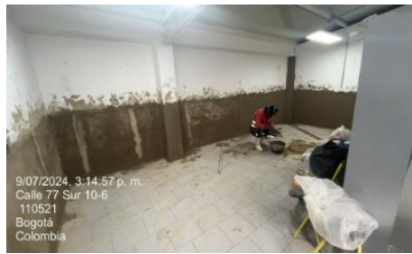
Aplicación de Pañete en muros
