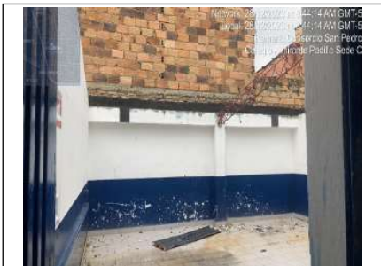
Instalación de platinas metalicas
