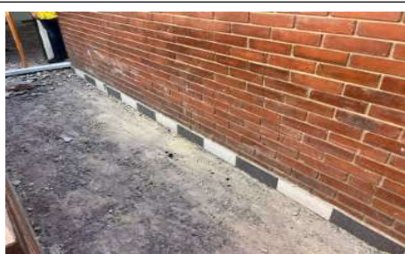
Demolición de piso de circulación
