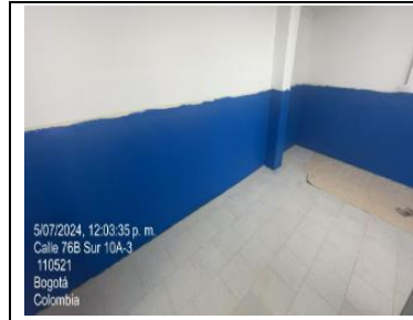
Aplicación de Pintura en Muros
