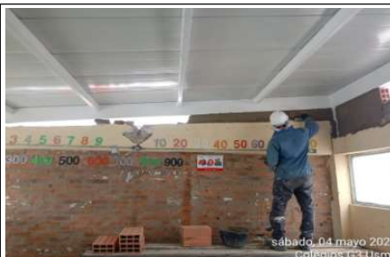
Encorizado de Muros
