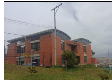
Estado final limpieza e impermeabilizacion de fachada
