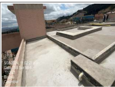
Continua la instalación de mortero
