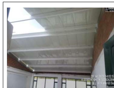
Instalación de cubierta tipo sandwich
