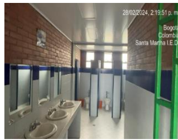
Entrega de zona de baños
