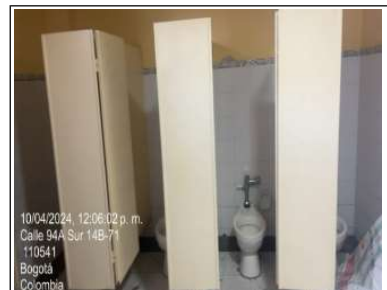
Desmonte de bateria sanitaria
