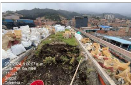
Retiro de jardines existentes
