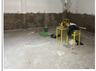
se termina instalación de cubierta del Salon No. 1
