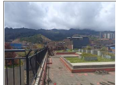
Retiro de estructura metalica de piso laminado
