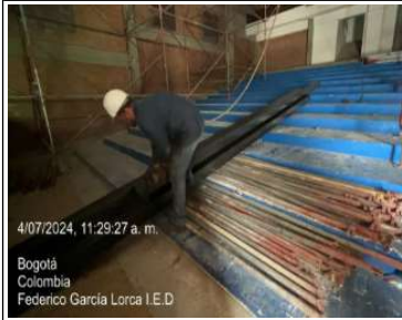
Trasiego de material para inicio de instalacion de estructura
