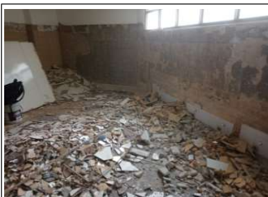
Demolición de enchape de muros y pisos
