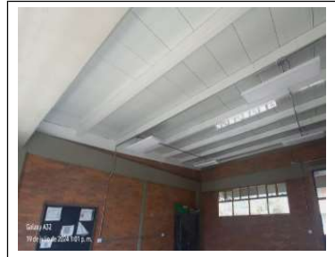
Se realiza instalación electrica
