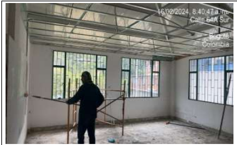
Pintura en salones y estructura de cielo raso
