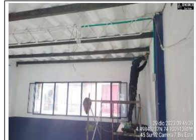
Instalación de perfiles metalicos y platinas de soporte
