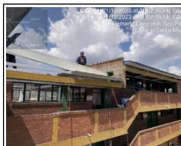
Instalación de Cubierta tipo Sandwich aula 303
