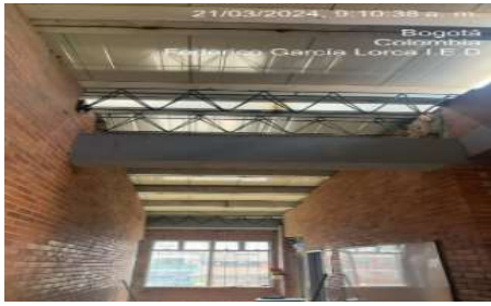
Instalación de cubierta
