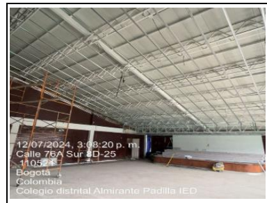
12/07/2024, 3:08:20 p. m. Calle 76A Sur 8D-25 110521 Bogotá Colombia Colegio distrital Almirante Padilla IED Terminación de primer tendido e inicio de segundo tendido de cubierta
