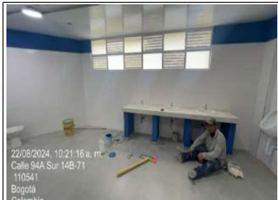
Instalación de lavamanos y griferia en bateria de segundo piso
