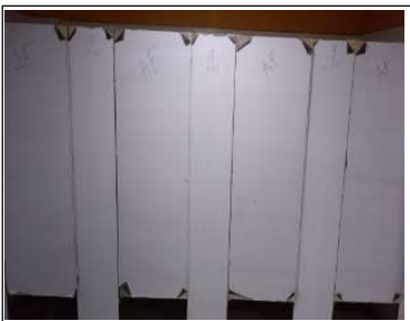
Instalación de divisiones baño niñas primer piso
