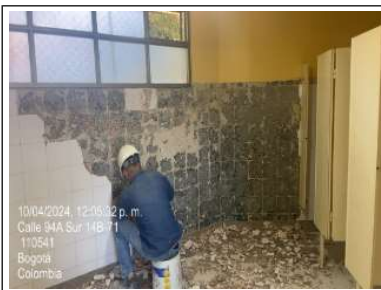
Demolición de enchape de muros
