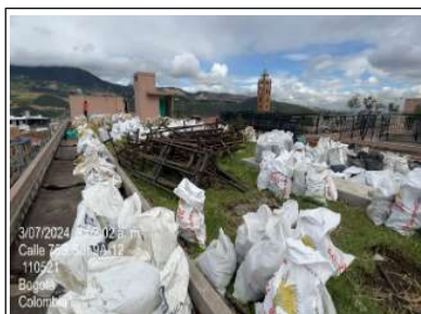
Retiro de jardines existentes
