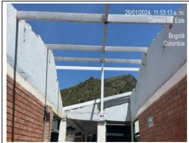
Instalación de correas y perfiles en cubierta, pasillo y salon 5
