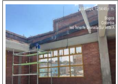
Instalación de perfiles en cubierta
