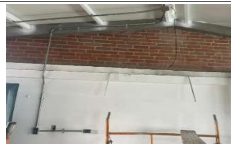
Instalación de putos electricos, interruptores y tomacorriente sencillos
