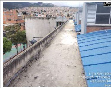
Se culmina actividad de demolición
