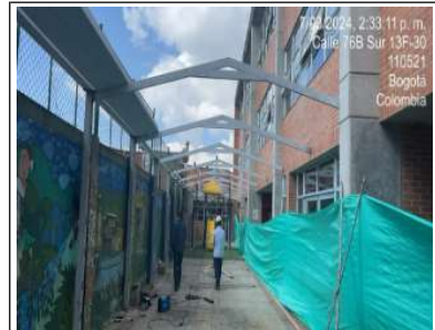
instalación de perfilera metalica
