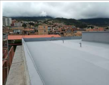
Se termina la instalación del sistema de impermeabilización
