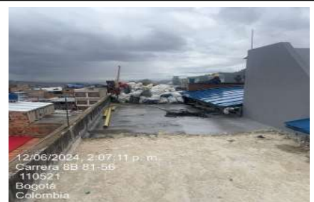
Retiro de escombros
