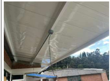
Instalación de red electrica
