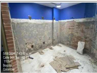
Demolición de enchape en baños del 2do piso
