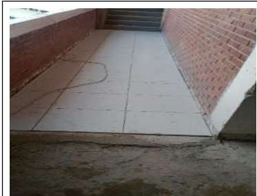
Instalación de duropiso en circulación
