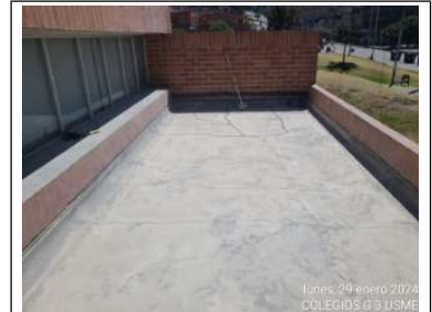
Limpieza e inducción de fisuras
