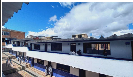
Cambio de cubierta bloque 1
