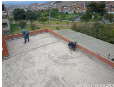
Picado de placa para adherencia
