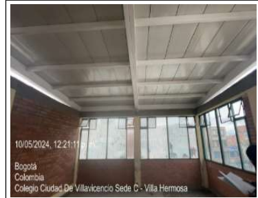
Instalación de cubierta salon 504
