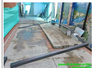
Armado Porticos estructura metalica de cubierta.
