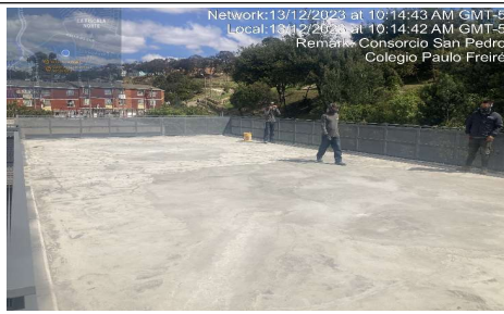
Instalacion de primera capa de imprimación para impermeabilización de placa
