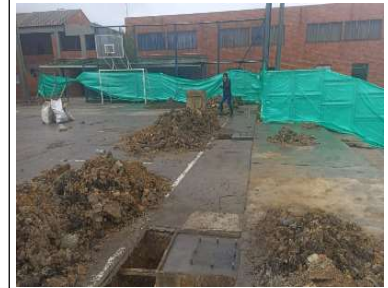
Armado y fundida de pedestales
