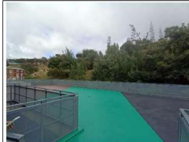
Inducción de fisuras
