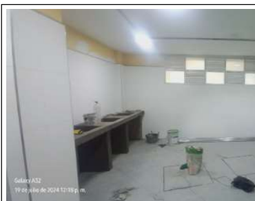
Pañete en muros de lavaplatos y resane de muros
