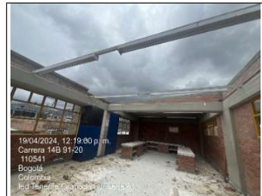
Desmonte de cubierta zona de laboratorio
