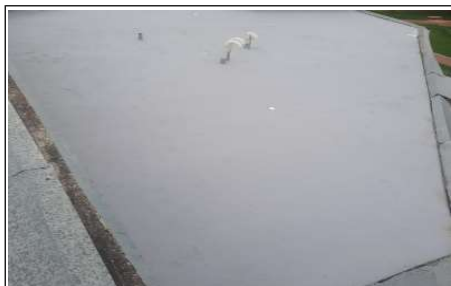
impermeabilización de placa terraza baños
