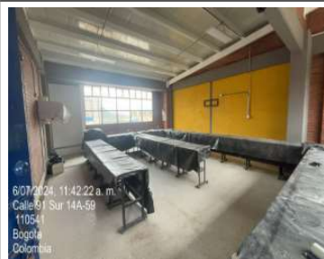
Terminación de las instalaciones electricas
