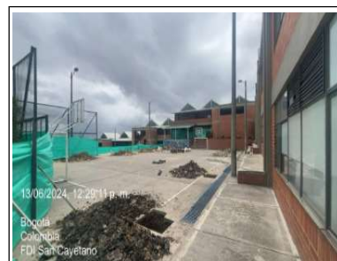
se continua con excavación de zapatas
