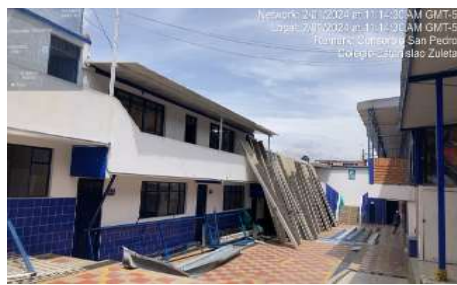
Desmante de cubierta
