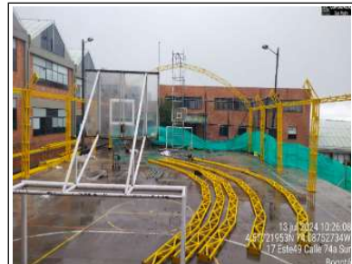
Instalación de estructura metalica para cubierta
