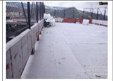
Inducción de fisuras
