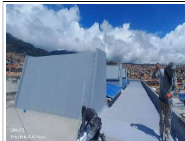
Instalación de Sikafill
