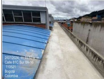
Fundida de mortero de nivelación
