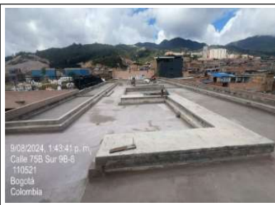
Se termina instalación de mortero y se espera secado
