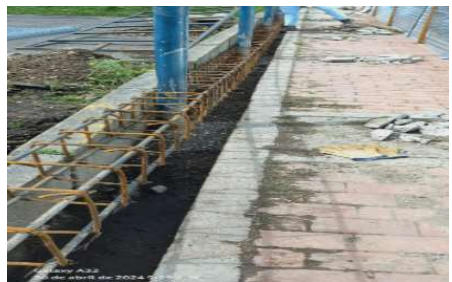
Armado de Viga de Amarre
