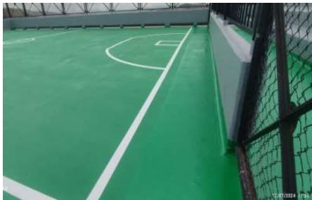
Instalación del sistema de impermeabilización vulkem en cancha
