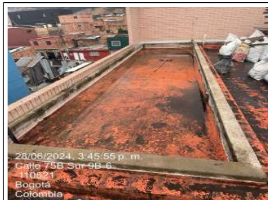
Demolición y retiro de jardines existentes
