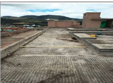
Retiro de membrana PVC
