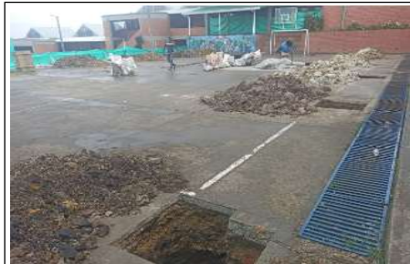
Perfilado de excavaciones
