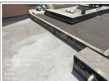
Instalación de mortero
