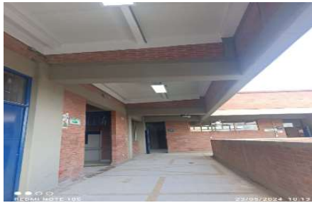
Entrega de area intervenida etapa 1
