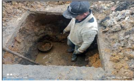
Se continua con excavación de zapatas
