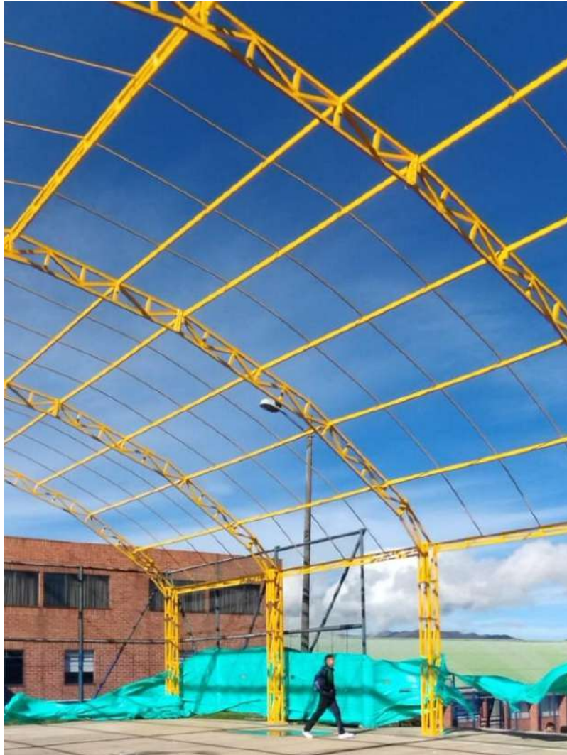
Ilustración 2: panorámica de la estructura
