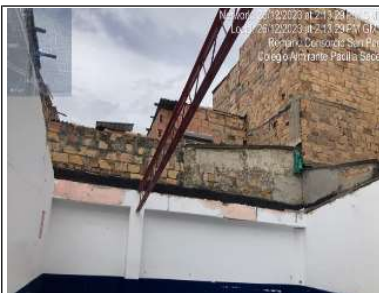
Desmonte de cubierta existent
