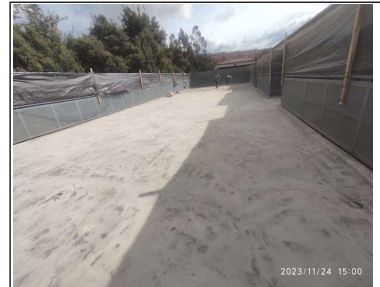
Pulida de placa para retiro de emulsión asfáltica
