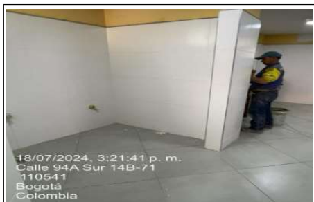
Se culmina instalación de enchape de piso y se realiza emboquillado de enchape de muro
