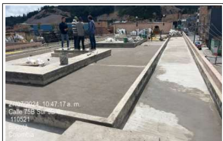
Instalación de mortero
