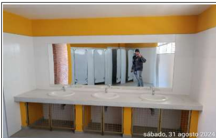
se termina actividades en baños de segundo piso
