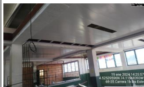
instalación de cielo raso en salon 301
