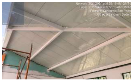
Instalación cubierta tipo sadwich
