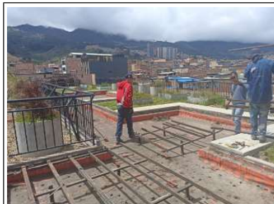
Retiro de piso laminado
