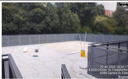
Preparación para aplicación segunda capa de imprimante para impermeabilización de placa
