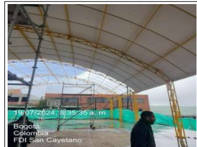
Instalación de estructura metalica para cubierta
