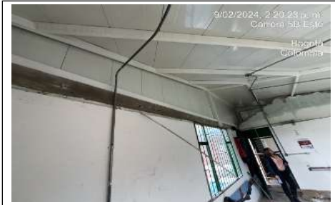
estructura de cubierta
