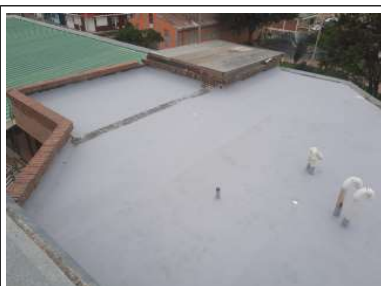
impermeabilización de placa terraza salon química
