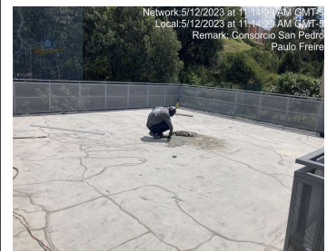
Mortero de Nivelación de placa
