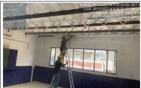
Aplicación de anticorrosivo a estructura metalica
