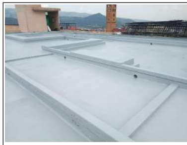
Instalación de sistema de impermeabilización
