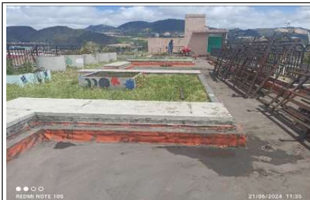
Retiro de piso laminado
