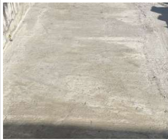
Fundida de mortero de nivelación
