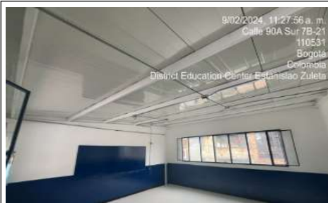
instalación de red electrica area 2
