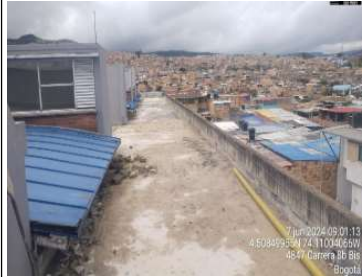
Demolición de antepiso
