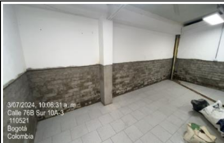
Aplicación de impermeabilizante en muro de mampostería
