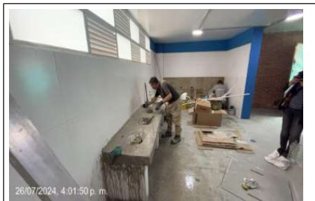
se termina instalacion de enchape de piso y se realiza emboquillado de enchape de muro baños niños primer piso
