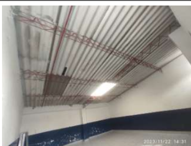
Desmonte de luminarias en Aula 2
