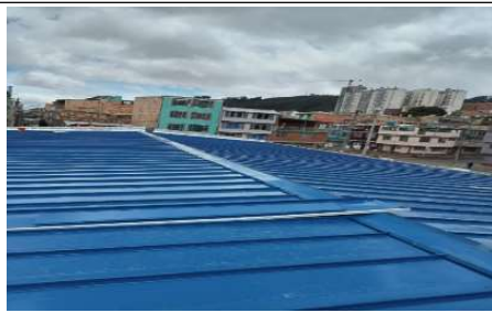
Instalación de cubierta y caballete
