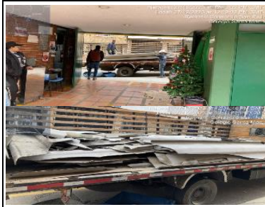
Disposicion final tejas de asbesto cemento
