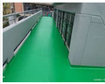
Instalación del sistema de impermeabilización vulkem en cancha
