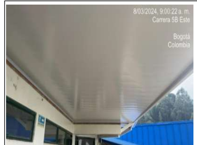
Instalación de cielo raso en Circulaciones
