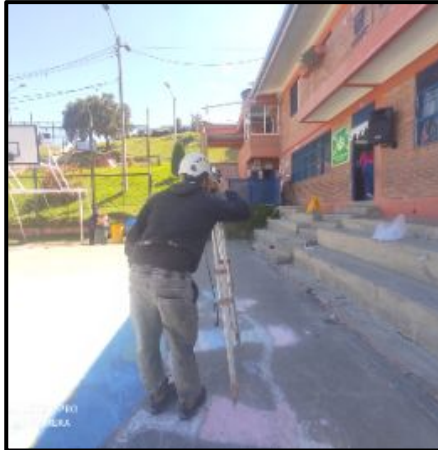
LOCALIZACIÓN Y REPLANTEO
