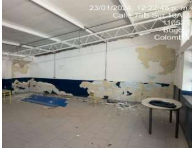
Retiro de pintura en muros
