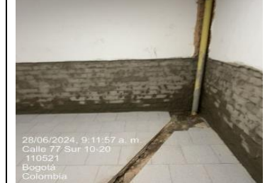
Cambio de bajantes y tubería hasta cajas de inspección
