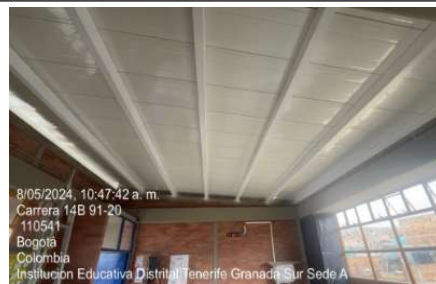
Instalación de cubierta
