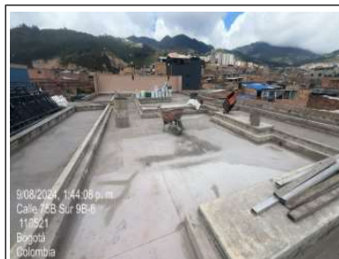
Se realiza corte de dilataciones constructivas
