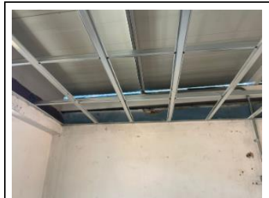
Instalación de estructura para cielo raso
