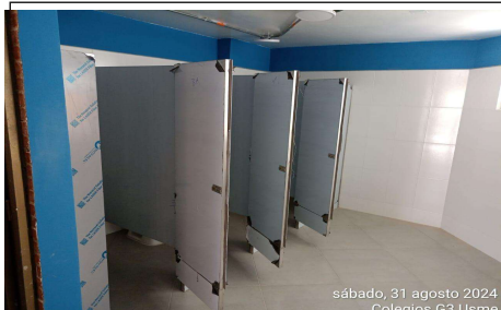
Estado final bateria de baños niños preescolar segundo piso
