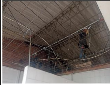
Inicio de instalacion de correas
