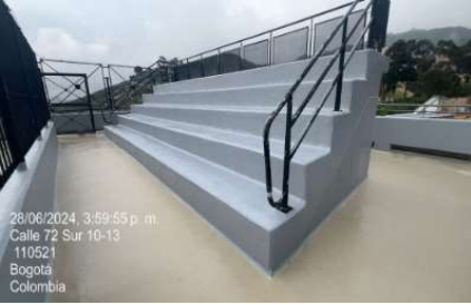
Instalación del sistema de impermeabilización vulkem en gradería
