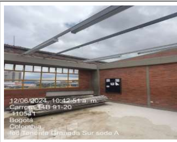
se continua con el desmonte de cubierta
