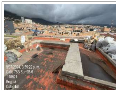
Retiro de material procedente del retiro y demoliciones de jardineras
