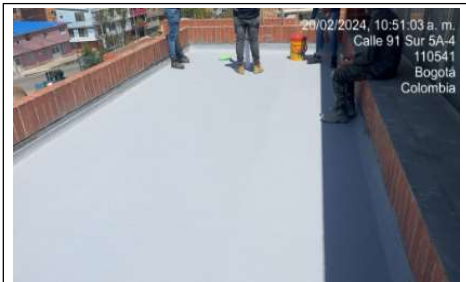
impermeabilización de placa 3
