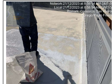
Instalación de cubierta salon 504 Aplicación de Sikadur 501 para acabado con agarre
