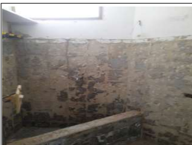
Demolición de enchape de muros y pisos
