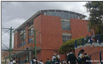
Estado inicial fachada
