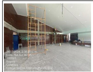
24/07/2024, 2:30:10 p. m. Calle 76A Sur 8D-25 110521 Bogotá Colombia Colegio distrital Almirante Padilla IED Terminación de cielo raso e instalaciones electricas en auditorio
