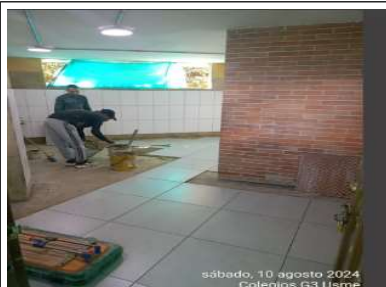
Instalación de enchape en baño de niña del segundo piso
