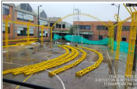
Instalación de estructura metalica para cubierta
