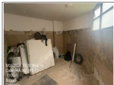
Retiro de escombros
