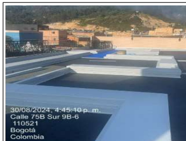
se instala piso chip
