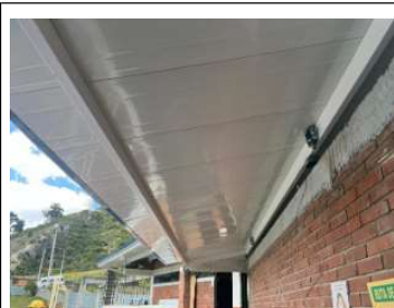
Instalación de perfiles metalicos para cubierta
