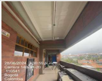
Instalación de cubierta
