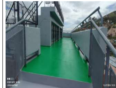
Instalación del sistema de impermeabilización vulkem en circulación
