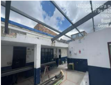
instalación de perfilera metalica en ludoteca
