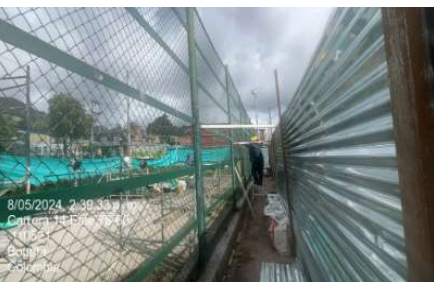
Instalación de paneles metalicos
