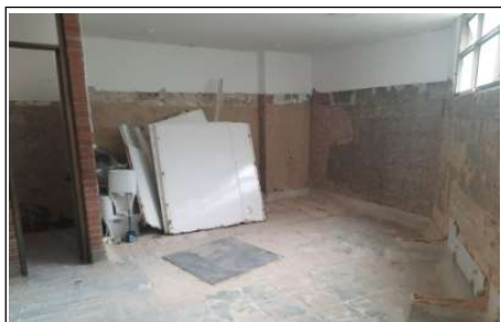
Demolición de enchape de muros y pisos
