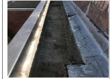
Limpieza de canal
