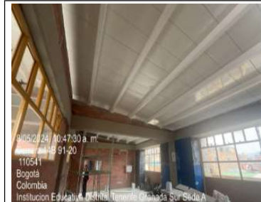
Instalación de cubierta
