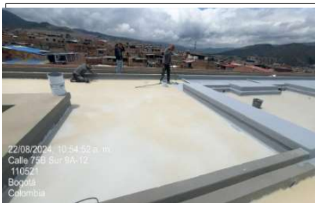
Instalación de sistema de impermeabilización
