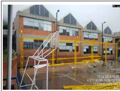
Instalación de estructura metalica para cubierta
