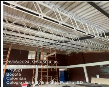
Pintura en cerchas
