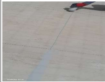
Aplicación del sello en los dilataciones constructivas
