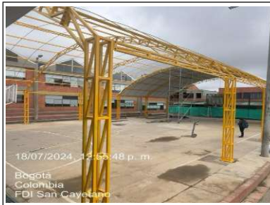
Instalación de estructura metalica para cubierta
