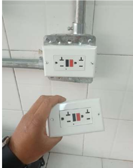
Ilustración 1 Cambio toma GFCI.
