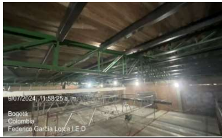
Instalación de correas
