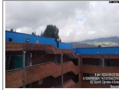
impermeabilización de cubierta
