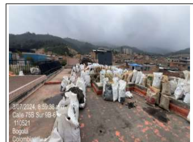
Retiro de material procedente del retiro y demoliciones de jardineras
