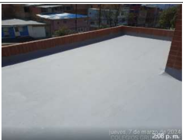
Impermeabilización de placa 1
