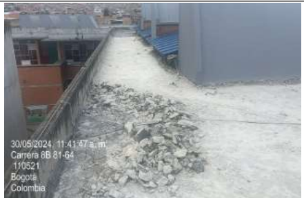
Demolición de antepiso
