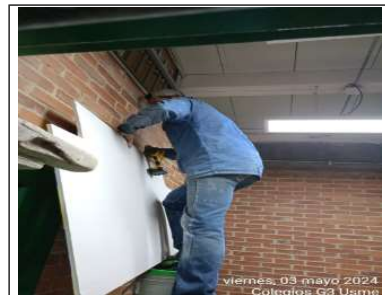
Instalación de encorizado de eterboard
