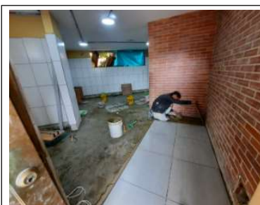
Instalación de enchape de piso en baño de niñas primer piso
