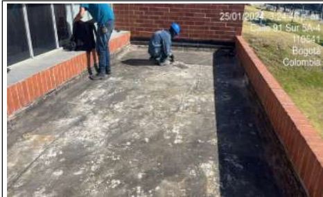
Retiro de manto existente
