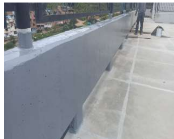
Se inicia actividad de impermeabilización de antepechos muros cancha
