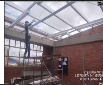
Instalación de estructura metálica
