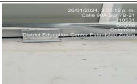
Cambio de Platinas, se instala platina acordadas en comité
