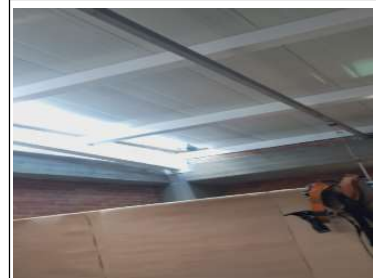
Instalación de cubierta
