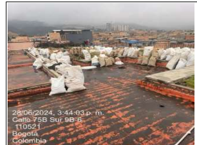
Demolición y retiro de jardines existentes
