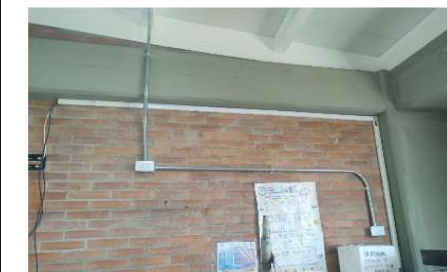
Se realiza instlaciones electrica
