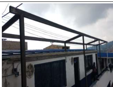
instalación de cubierta area 1
