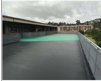
Aplicación de pintura en uretano
