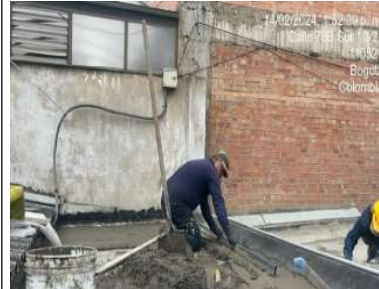
Afinado de piso en mortero impermeabilizado
