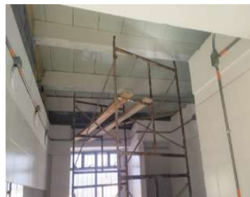
Encorrece zona de baños
