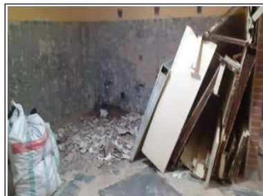
Desmante de puertas y divisiones
