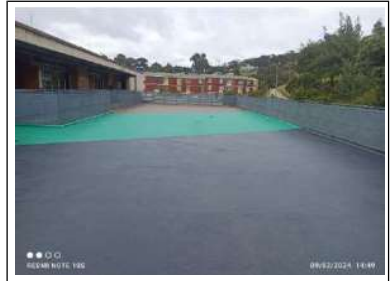
Retiro de escombros
