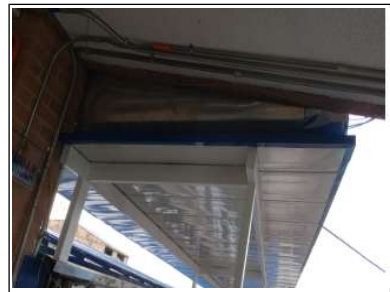
Instalación de cubierta area 1
