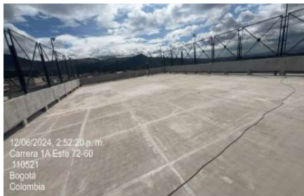
Se continua con sello de dilataciones constructivas
