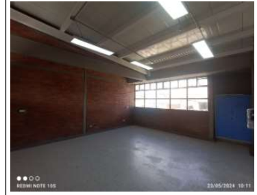
Entrega de area intervenida etapa 1
