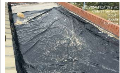
inducción de fisura en placa 2 y afinado
