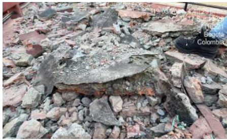
Demolición de circulaciones
