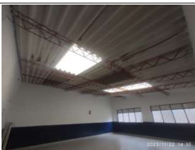
Desmonte de luminarias en Aula 5
