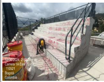
Se continua con Retiro de membranas muros de antepechos
