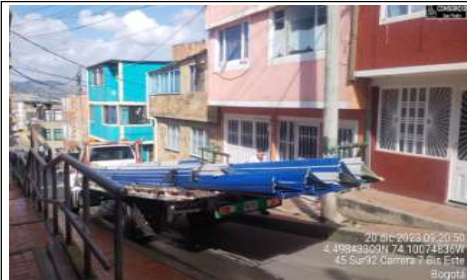
Llegada material Cubierta tipo Sandwich
