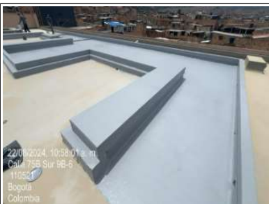
Instalación de sistema de impermeabilización
