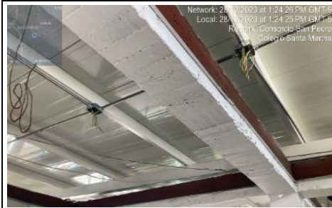
Cableado de puntos electricos aulas 301, 302 y 303
