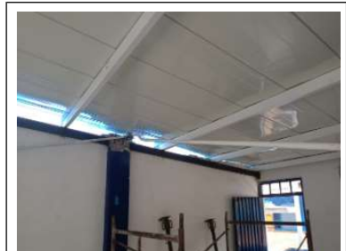
elevación del nivel de cubierta
