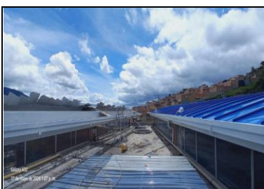
Durante intervención cubierta
