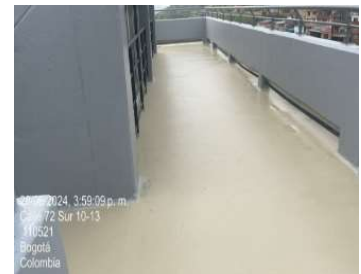
Instalación de cuarzo en placas
