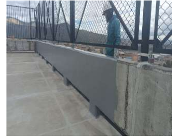
Se inicia actividad de impermeabilización de antepechos muros cancha
