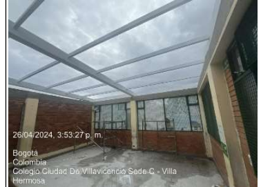
Instalación ed perfilera
