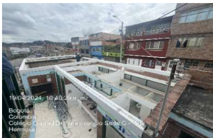
Instalacion estructura de cubierta
