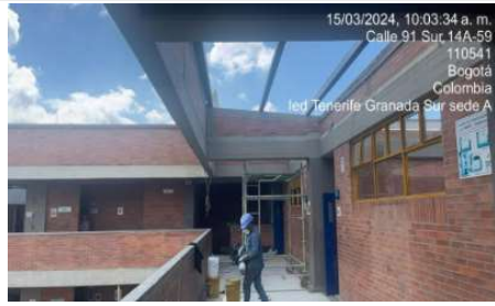
Desmonte de cubierta
