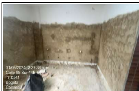
se inicia aplicaci3n de pañete en muro
