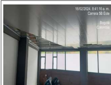
instalación de cielo raso
