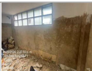
se inicia aplicaci3n de pañete en muro
