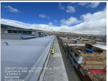
Instalación de tubería para bajante de agua
