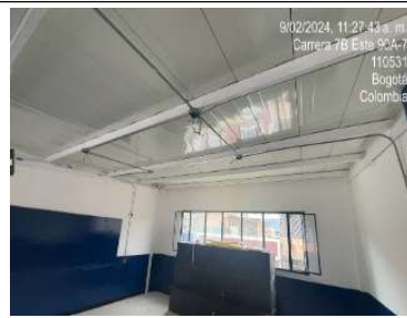
instalación de red electrica area 3
