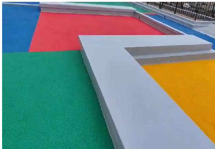
Ilustración 4 Sello piso chip y pintura en bancas.
