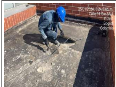
Demolición de antepiso
