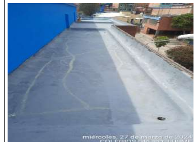
Tratamiento de Fisuras
