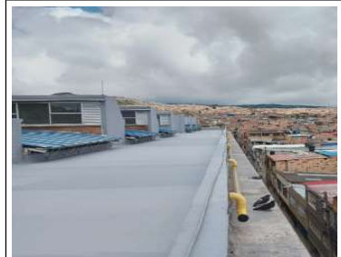
Instalación de tubería para bajante de agua
