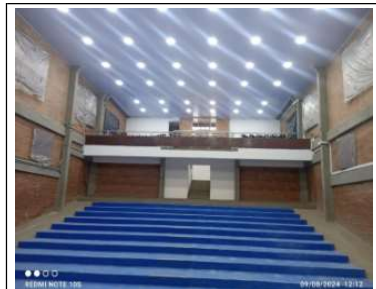
Aplicación de pintura en muros blancos
