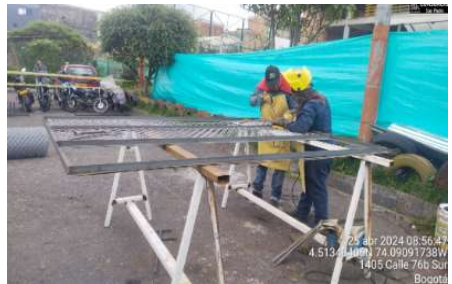
Fabricación de paneles metalicos
