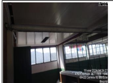
instalación de cielo raso en salon 301-A
