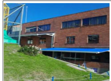
Instalación de cubierta en circulación
