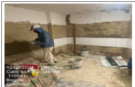
Instlacion de ceramica de muro
