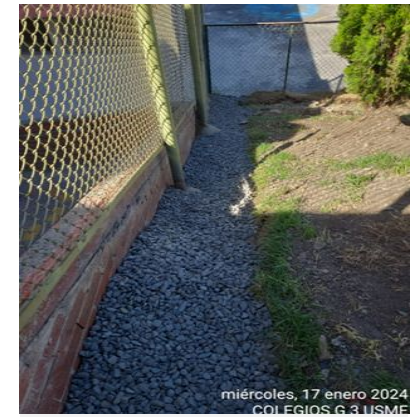
FILTRO MANEJO DE AGUAS LLUVIAS
