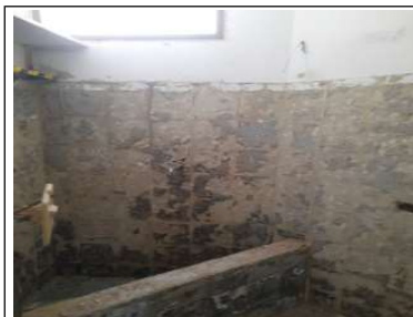
Desmonte de enchape
