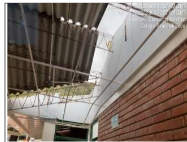
Desmonte de cubierta existente
