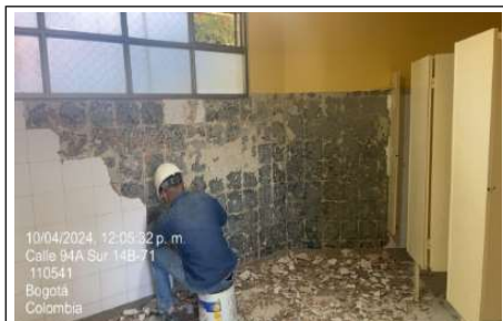
Demolición de enchape de muros
