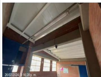
Se termina instalación de cubierta en salon 309
