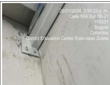
Cambio de Platinas, se instala platina acordadas en comité
