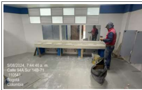
Pulida de meson de granito
