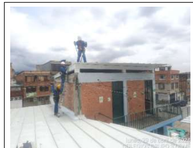
Instalación de cubierta
