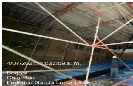
Trasiego de material para inicio de instalacion de estructura
