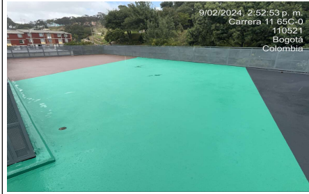
Aplicación de pintura en uretano
