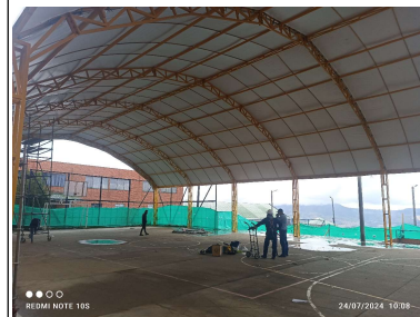
Estado final cubierta cancha
