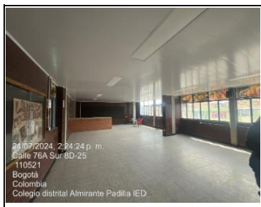
24/07/2024, 2:24:24 p. m. Calle 76A Sur 8D-25 110521 Bogotá Colombia Colegio distrital Almirante Padilla IED Entrega área de Cafería y Cocina
