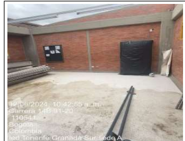
se continua con el desmonte de cubierta
