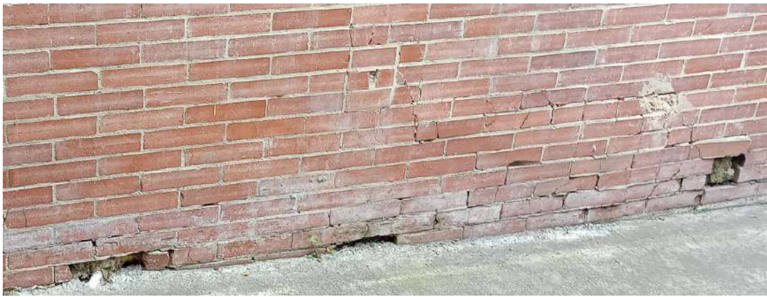
Imagen 2. Muro fachada costado norte. Fecha: 15-03-2024
