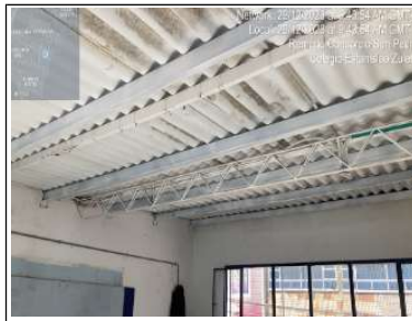
Estructura metalica instalada
