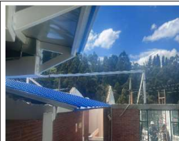
Instalación de perfilera para cubierta en salon 5 y circulación
