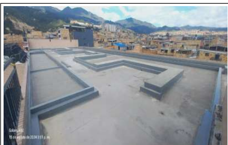
Se inicia con la aplicación de sistea vulkem
