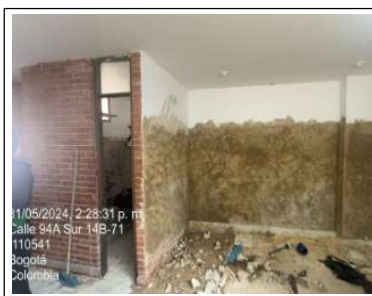
se inicia aplicaci3n de pañete en muro
