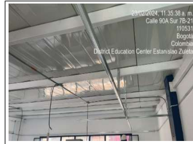
Instalación de cielo razo
