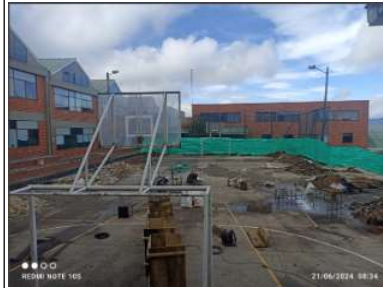
Se realiza formaleta Se realiza canastas y aplicacion de anticorrosivo
