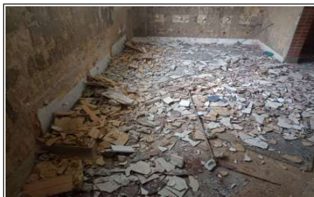
Demolición de enchape de muros y pisos
