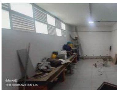
Instalación de Ventanas
