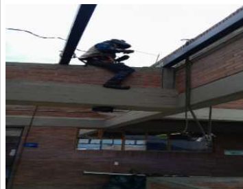
Instalación de perfiles en cubierta
