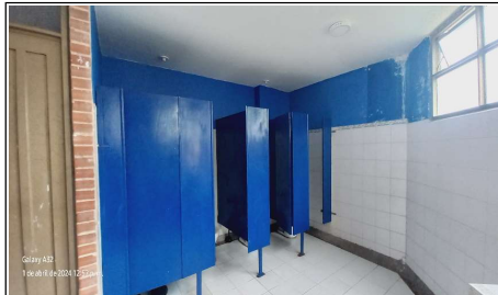
Estado inicial baño niños segundo piso
