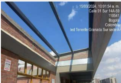
Instalación de perfilieria metalica
