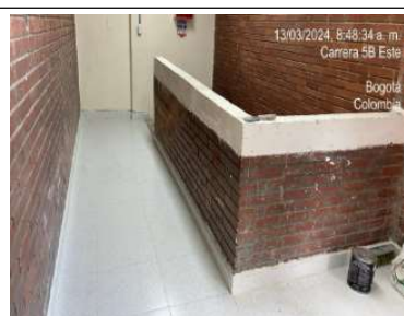
instalación de Duro piso en circulación
