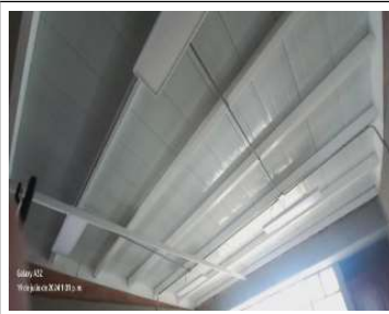
Continúa la instalación de cubierta en salón 309 - danzas
