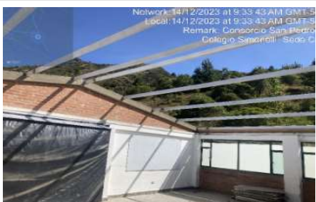
Instalación de perfiles metalicos para cubierta
