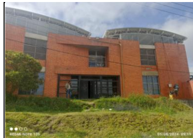
Durante limpieza e impermeabilizacion de fachada
