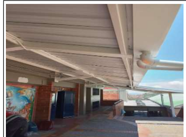
Estado final cubierta circulación
