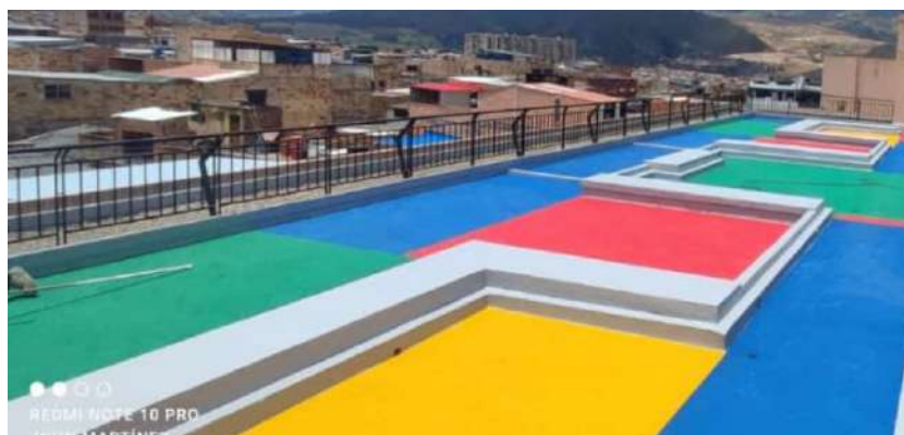
Ilustración 5 Sello piso chip y pintura en bancas.
