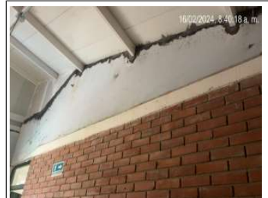
encorizado de muros
