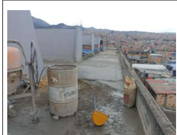
Fundida de mortero de nivelación
