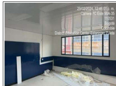
Instalación de cielo razo
