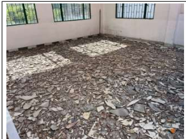
Demolición de piso salon 4
