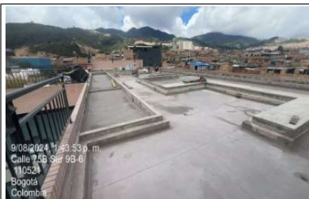
Se termina instalación de mortero y se espera secado
