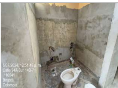
Aplomado de pañete en muros
