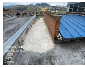
Demolición de antepiso
