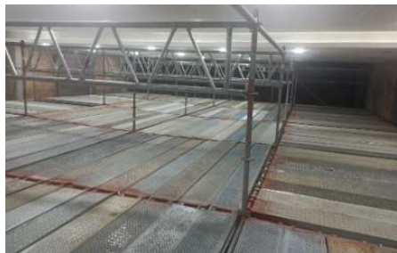
Armado de plataforma en andamio multidireccional
