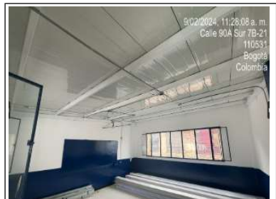
instalación de red eléctrica área 1
