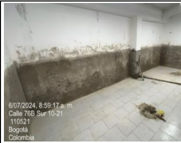
aplicación de Pañete en muros
