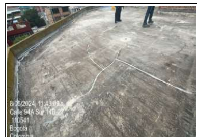
Impermeabilización placa de baños y salón de química
