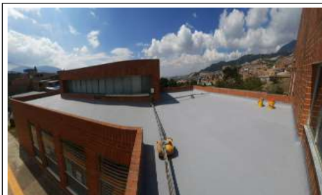
Impermeabilización de placa 1
