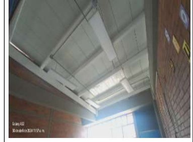
Instalación de 1er tendido de cubierta
