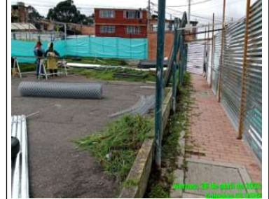
Desmante de paneles existentes
