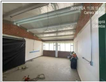
encorroe de salones 1-2 y 3 e instalaciones eléctricas
