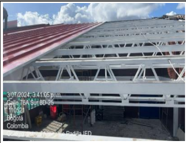
Instalación de primer tendido de cubierta en auditorio
