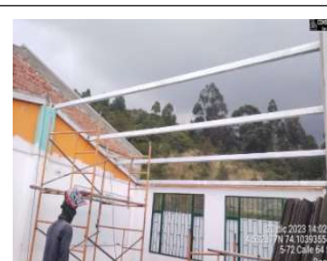
Instalación de perfiles metalicos para cubierta
