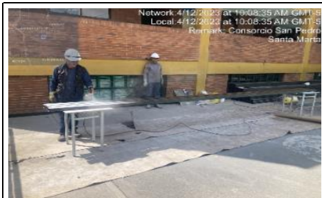
Aplicación de anticorrosivo en perfiles
