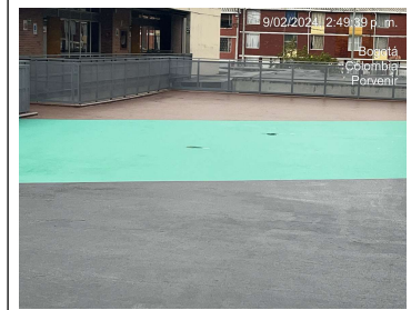
Aplicación de pintura en uretano
