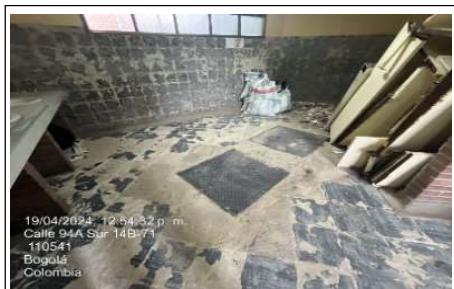
Demolición de enchape de muros y pisos
