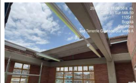
Desmonte de cubierta
