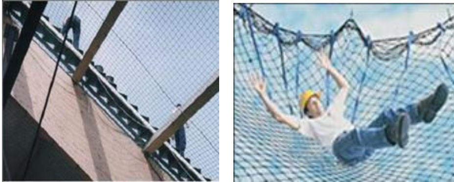
Figura 20. Red de seguridad para la detención de caídas.
